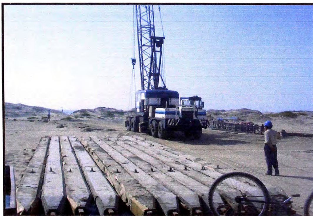
FOTO N° 02 : PILOTES DE CONCRETO CON PUNTA DE ACERO
