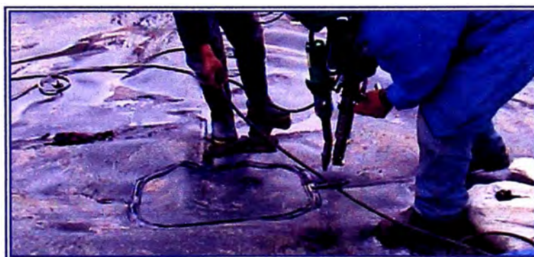
Fig. N° 06 : Sellado por Extrusión
