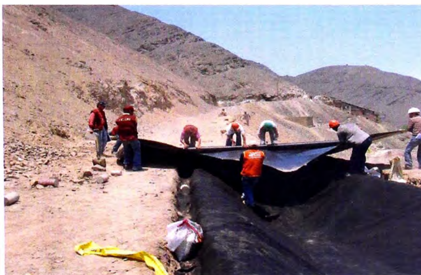
Foto N° 8 Colocación de Geomembrana
