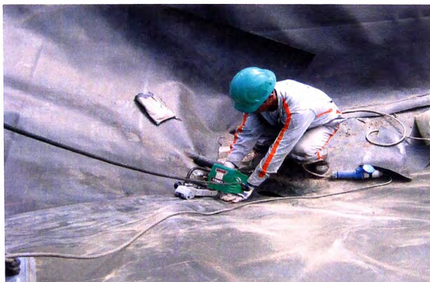
Foto N° 9 Proceso de extrusión. Sellado de Juntas
