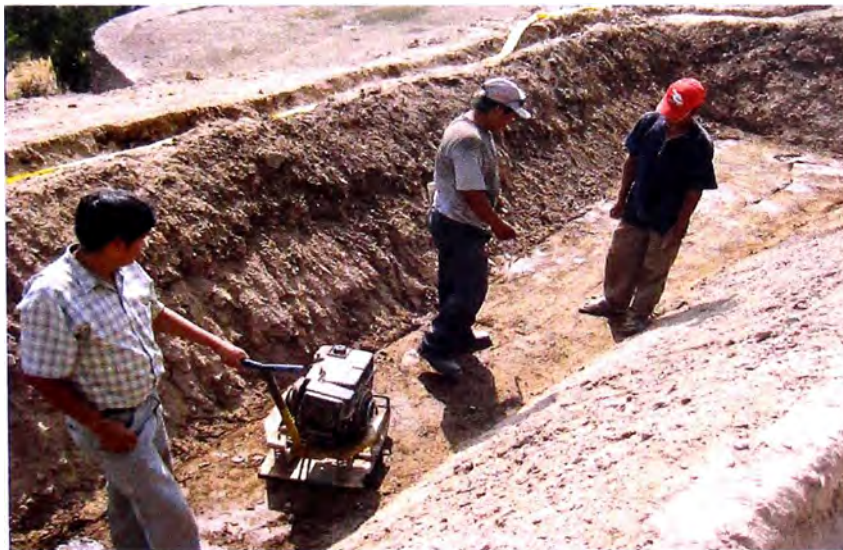
Foto N° 6 Compactación de la zona de trabajo. Mejoramiento de estabilidad
