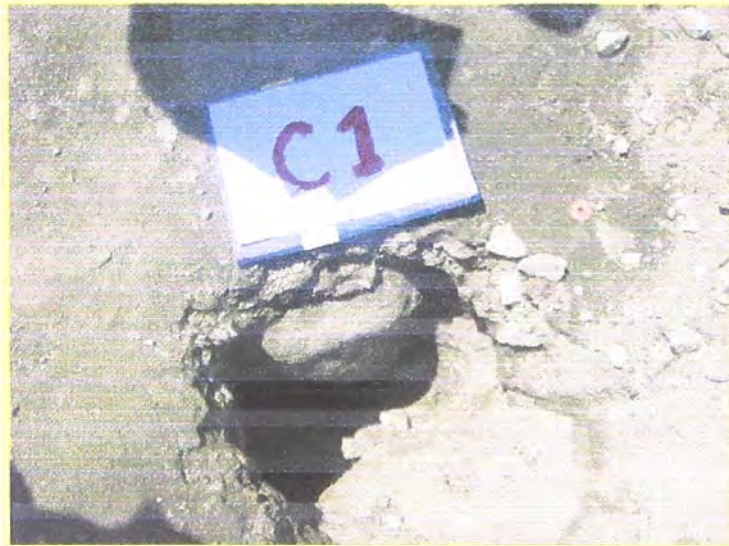
Foto 7. Calicata 1, km 57 + 040 profundidad 1.20m
