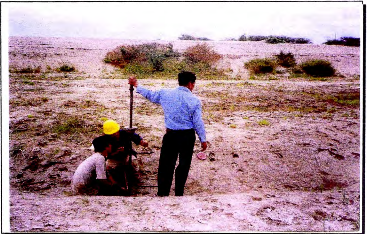
Foto N° 17: Vista del ensayo de Cono Sowers CS-01 ubicado aguas arriba del Puente Independencia.
