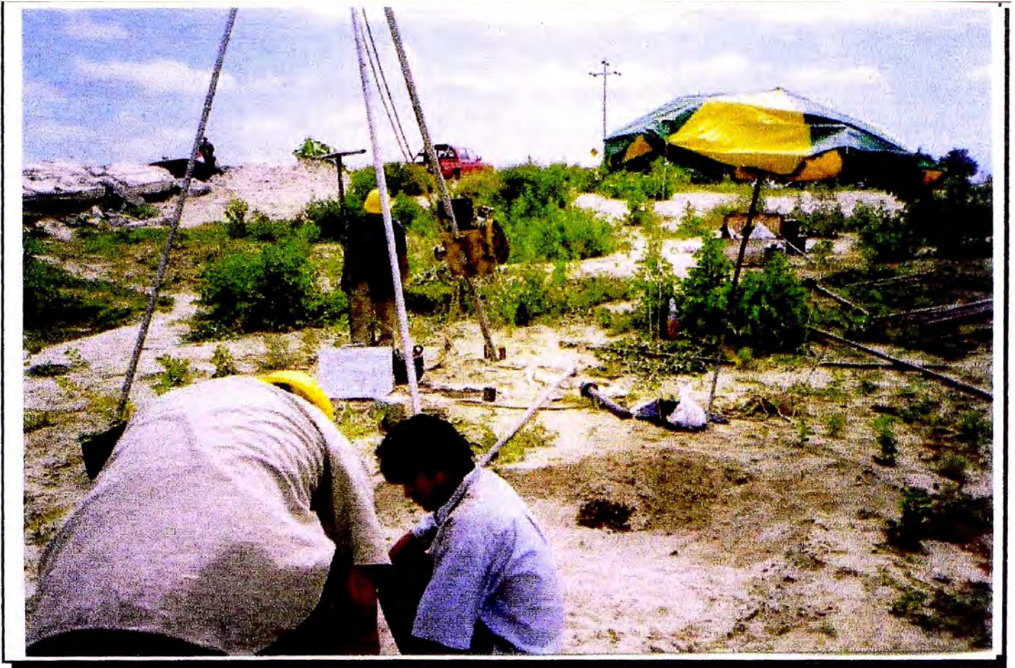
Foto N° 16: Sondaje SPT-01, se muestra el proceso de extracción de muestra con la osteadora manual (Puente Independencia).
