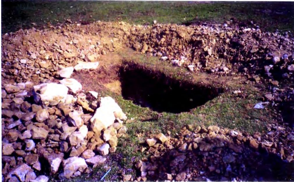
Foto 1 Excavación de calicata. Se muestra la naturaleza compacta del material el cual es extraído en grandes terrones del suelo.
