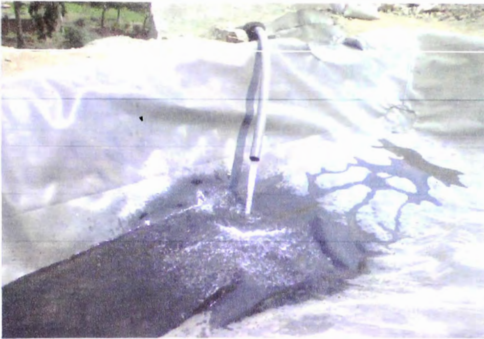
FOTO 7: En esta vista se aprecia el llenado de la poza, para lo cual se bombea agua de la poza inferior.
