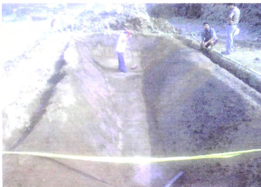
FOTO 4: En esta vista se aprecia la eliminación de partículas punzo cortantes que puedan dañar la geomembrana.
