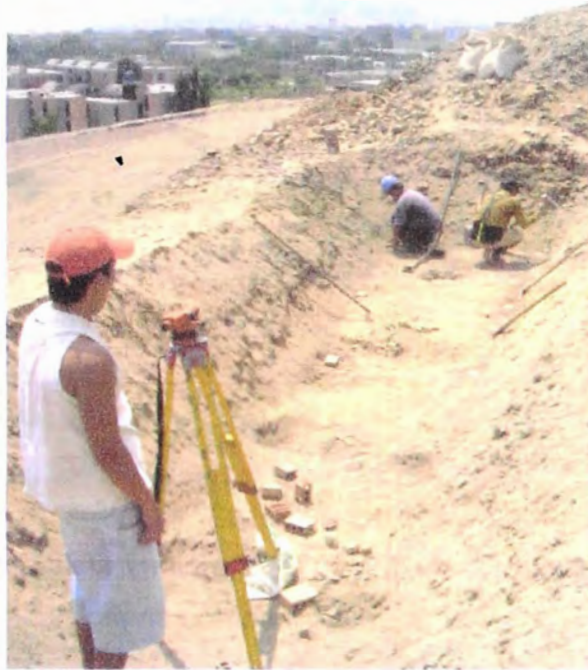
FOTO 1: En esta vista se aprecia la colocación de los niveles para el nivel de fondo de la poza.
