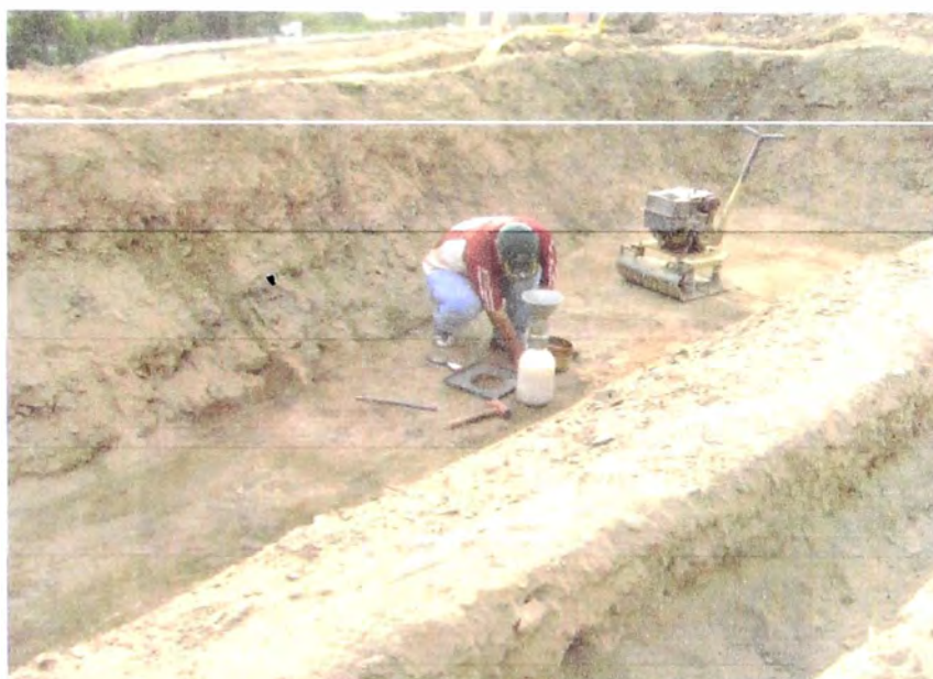
FOTO 3: En esta vista se aprecia el control de compactación con el “Cono de arena”, previa compactación.
