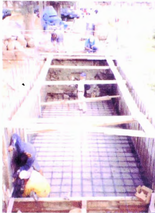
Figura 3.4 “Proceso Constructivo de Poza de Concreto Armado”
