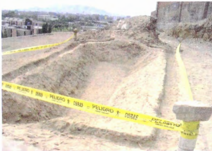
FOTO 2: En esta vista se aprecia la excavación de la poza al 100%.
