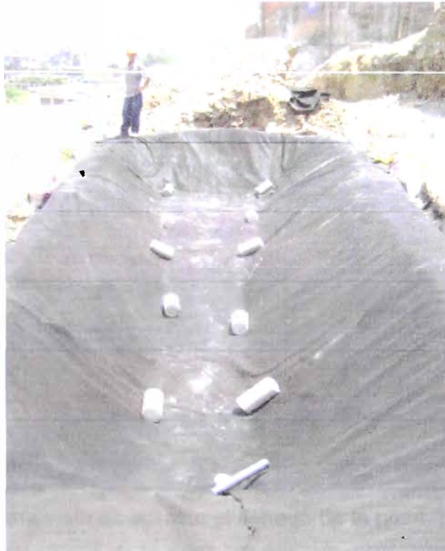
FOTO 5: En esta vista se aprecia el geotextil colocado en la superficie de la poza, para la posterior colocación de la geomembrana.
