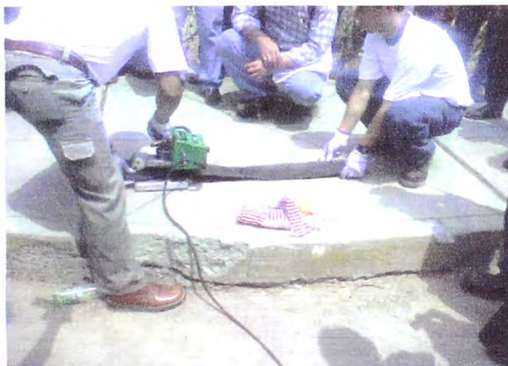
Figura 3.2: “Prueba de equipos”
