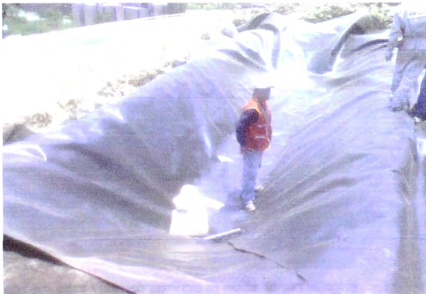
FOTO 6: En esta vista se aprecia la geomembrana colocada en la superficie de la poza
