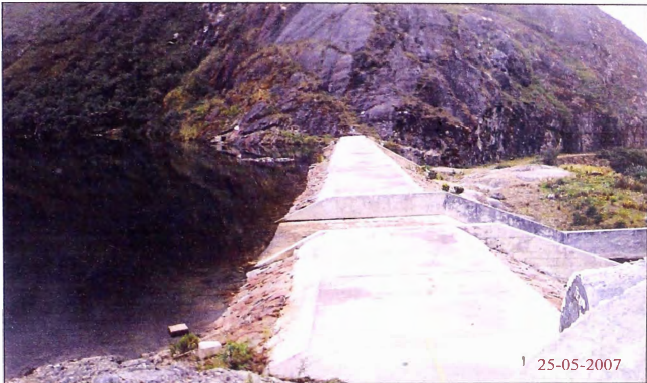
Foto 10: Presa culminada el 08-03-2000 y actualmente (25-05-2007) en funcionamiento, administrada por el Comité de Regantes de la Microcuenca de Mancapozo - Huánuco.
