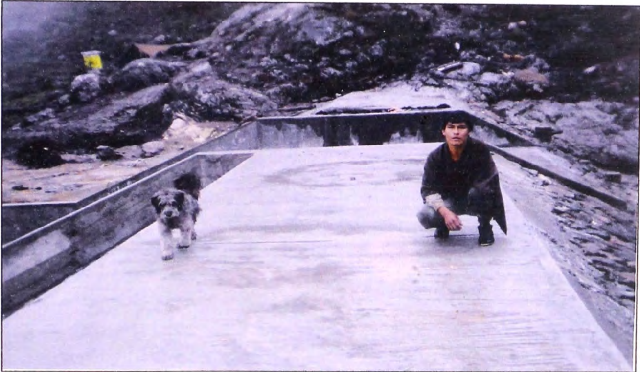
Foto 08 (arriba): Corona de la presa de 3.00 m de ancho y el vertedero de demasías completamente concluidas.
