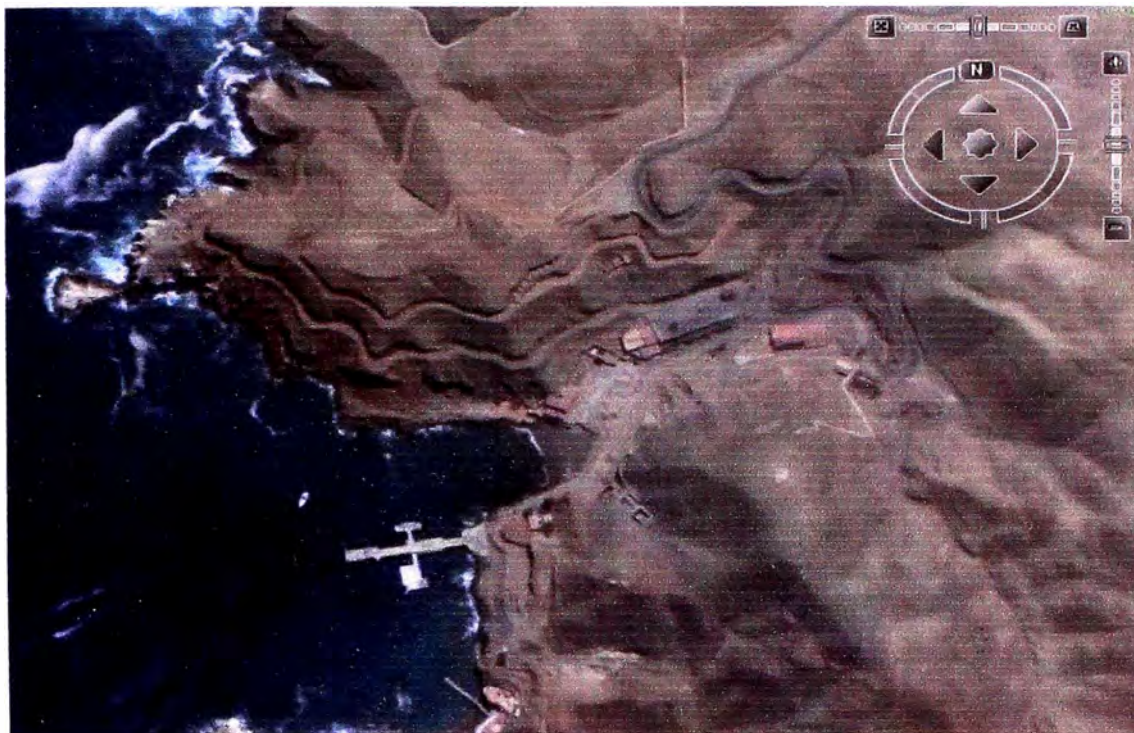
FIG. N° 03: Vista Satelital del Muelle "El Poseidón"
