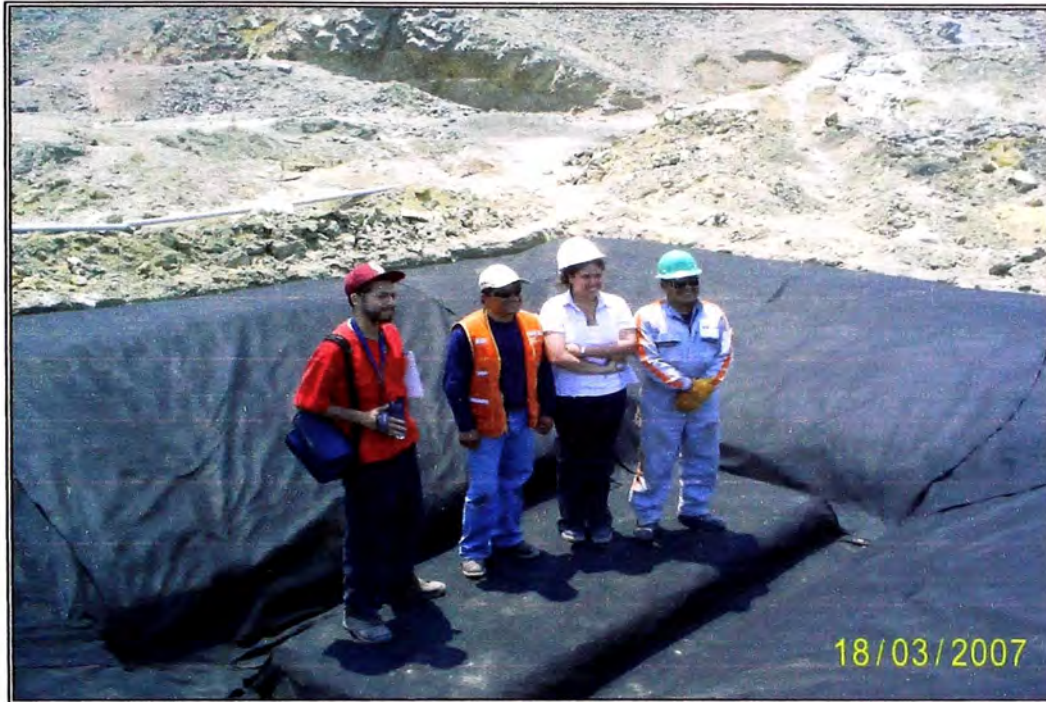
Imagen A.0.5 Instalación de geotextiles.
