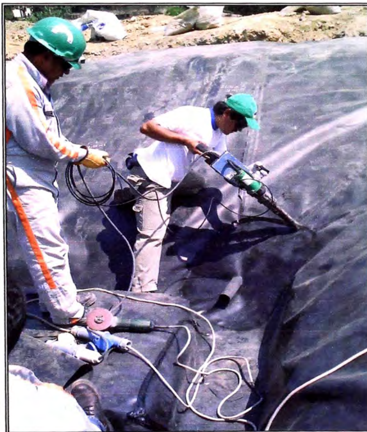
Imagen A.0.6 Instalación de geomembrana.
