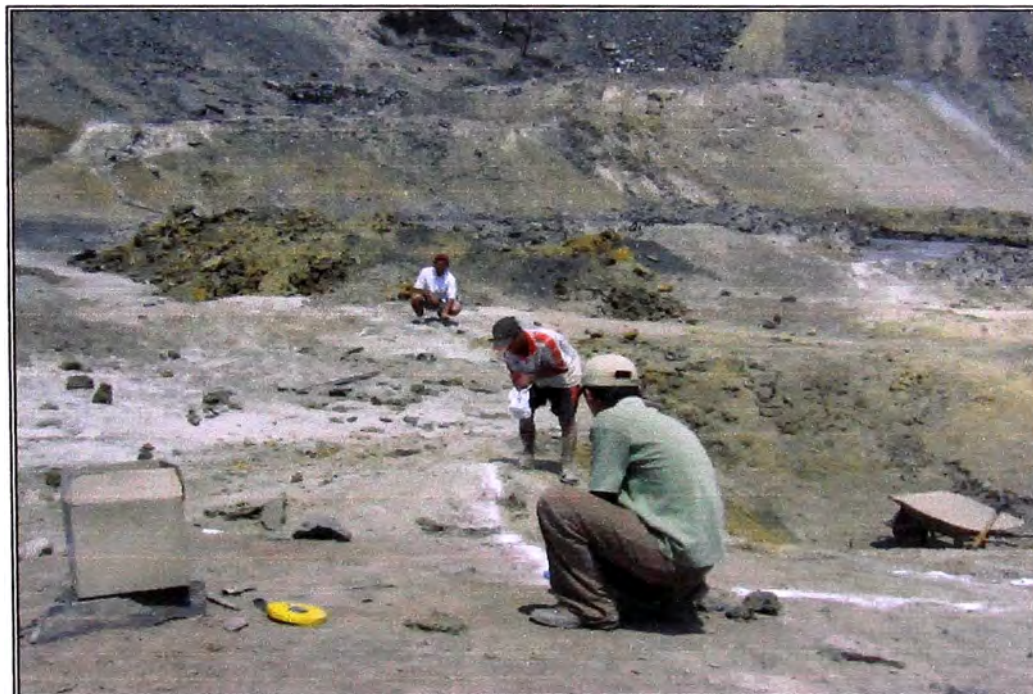
Imagen A.0.2 Trazo y Replanteo en campo.
