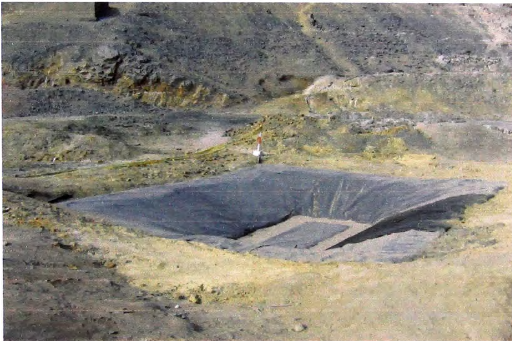
Imagen 5.1 Depósito de relaves terminado.
