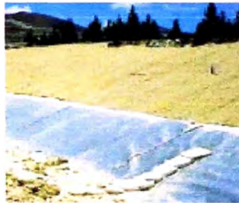
Imagen 1.5 Revestimiento de taludes, Cajamarca, Perú
