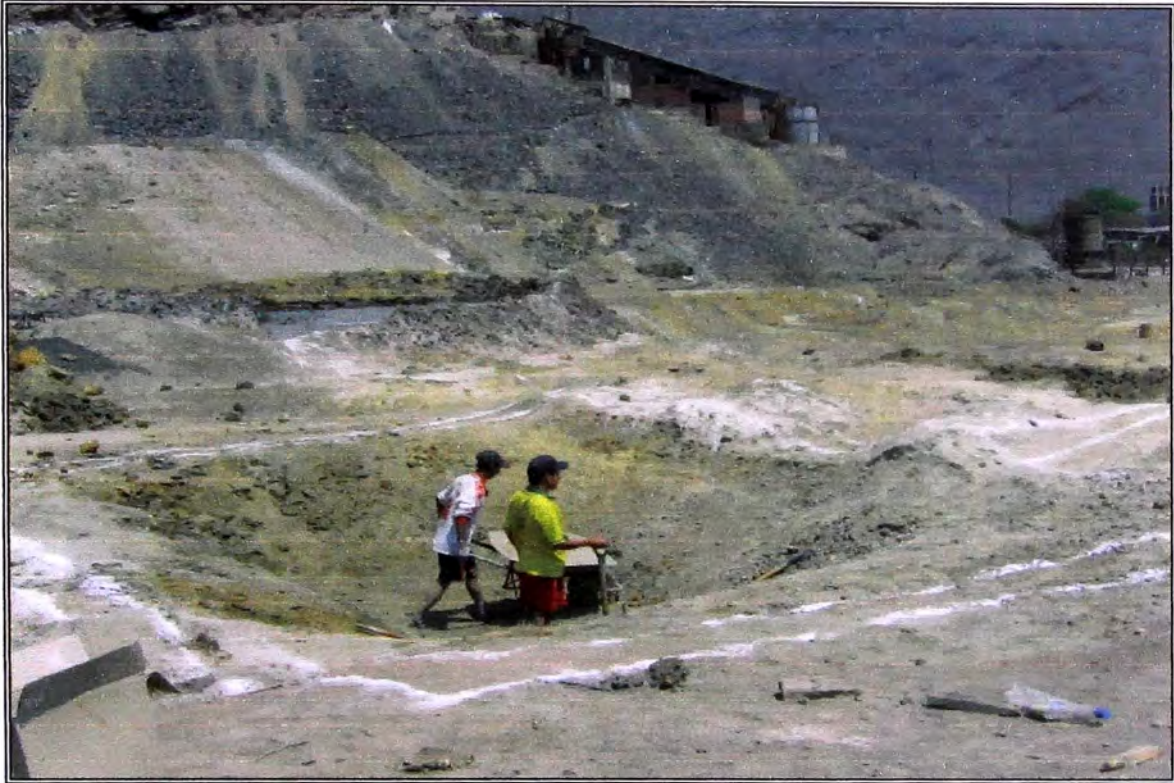
Imagen A.0.3 Excavación.
