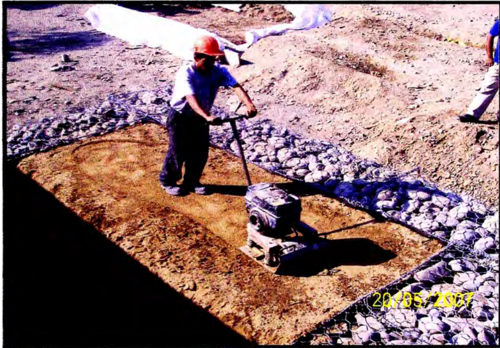
Foto N° 11: Compactación del relleno estructural.
