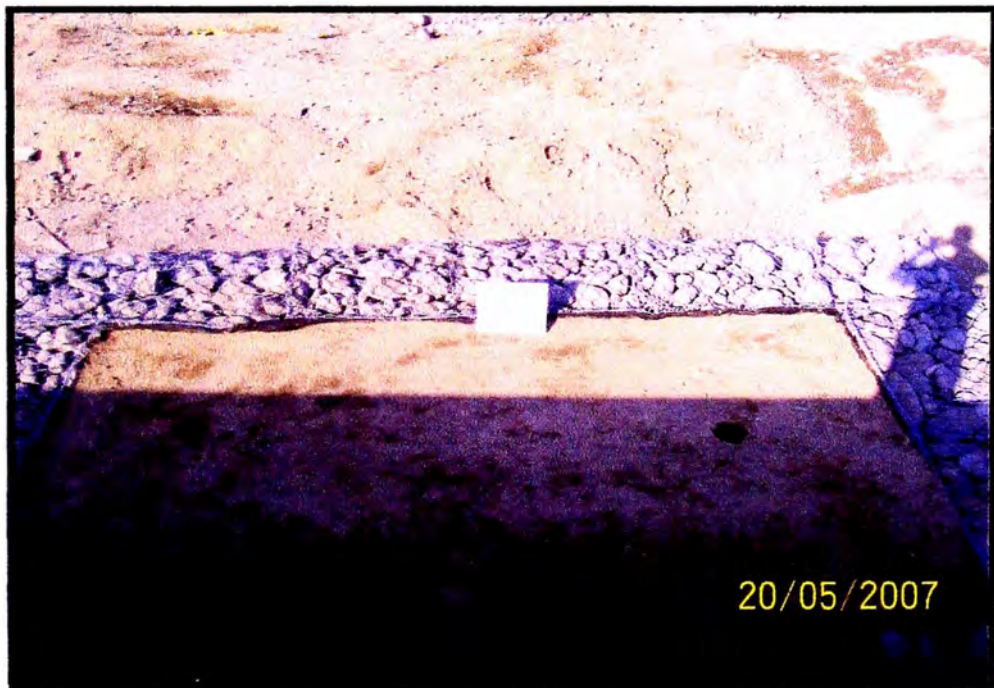
Foto N° 12: Muro terminado, se aprecia dos puntos de control de la compactación
