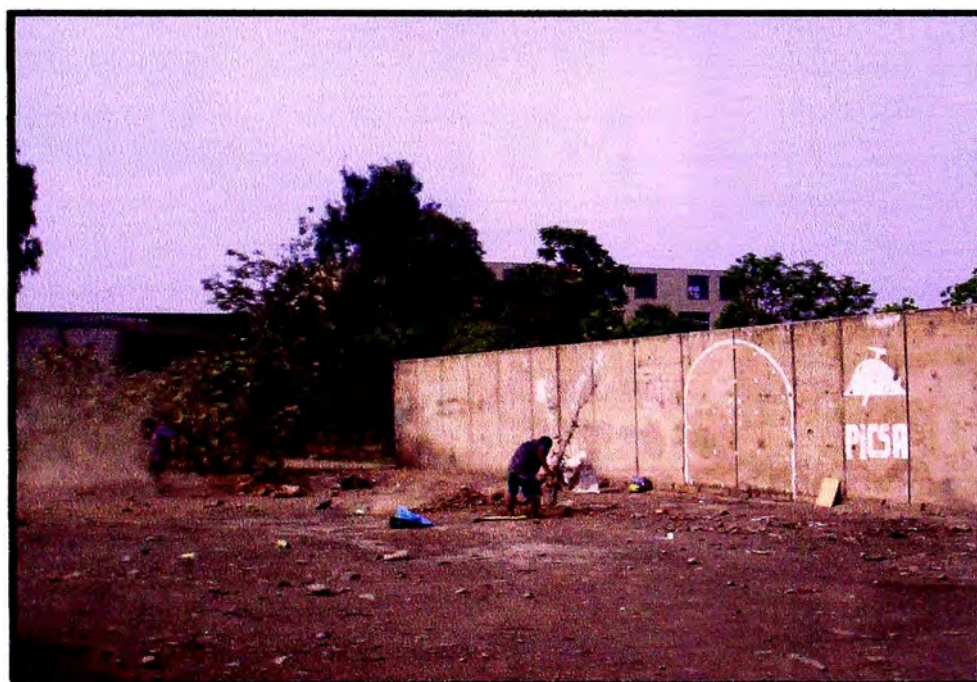
Foto N° 02: Inicio del trabajo de campo (Excavación de calicatas)
