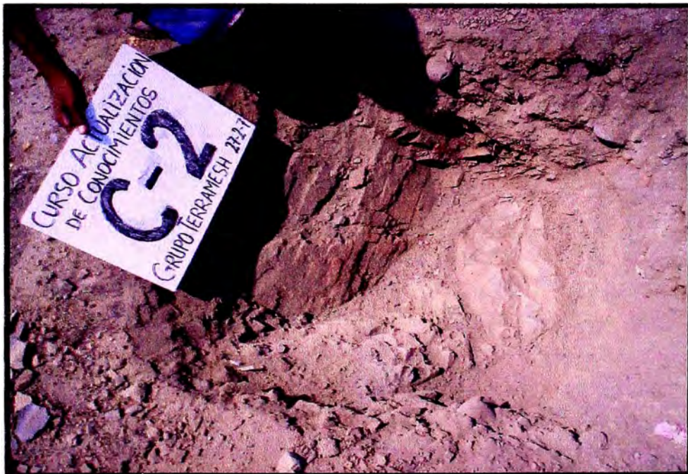
Foto N° 06: Estratigrafía de la Calicata C-2, se aprecia que la roca presenta fisuras muy cerradas.
