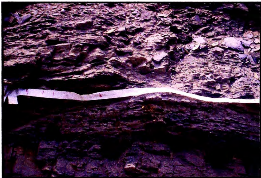
Foto N° 10: Medición del rumbo y buzamiento, de las discontinuidades.
