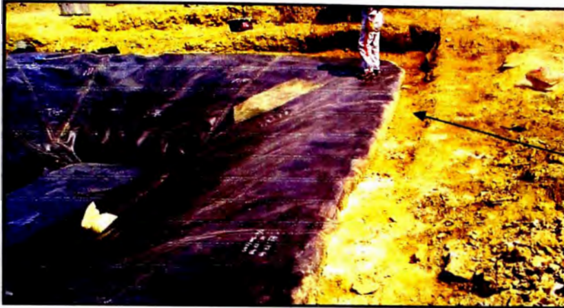
Foto N° 3.10 Se muestra las zanjas de anclaje rellenas con material propio
