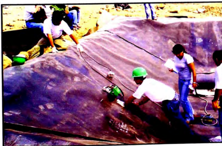
Foto 3.15 Proceso de soldadura por cuña caliente.
