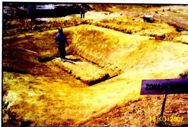
Foto N° 3.9 Verificación que los trabajos de refine, nivelación y compactación.
