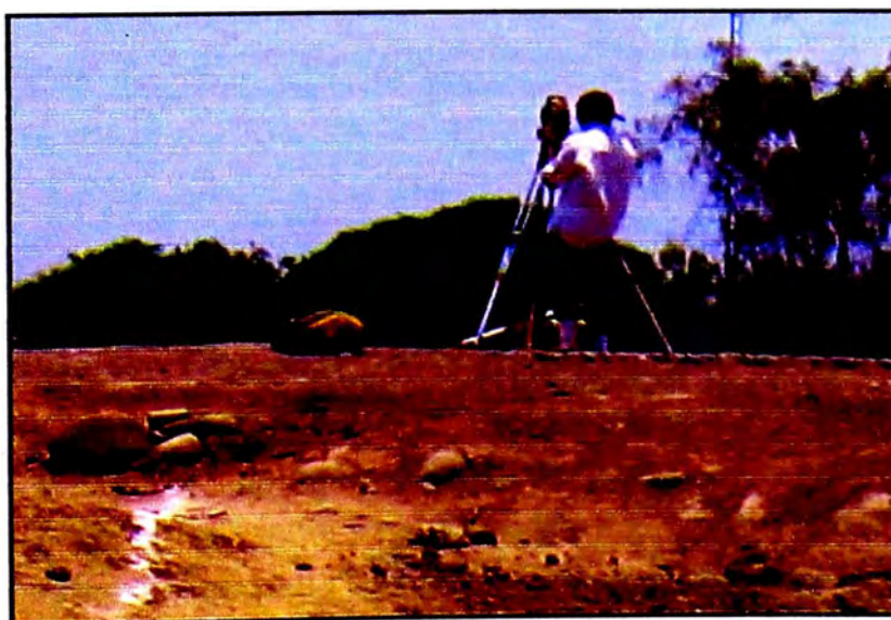
Foto N° 3.1 Empleo de Estación Total para ubicación de puntos para el Replanteo
