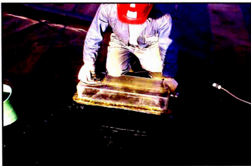
Foto 4.1 Prueba de caja de vacío
