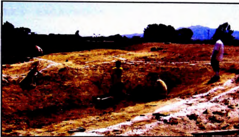
Foto N° 3.3 Trazado de zanja para colocación de tubería de salida de agua drenada.
