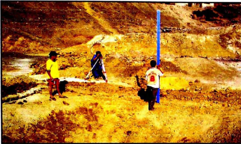
Foto N° 3.4 Empleo de Nivel Automático para control de niveles.
