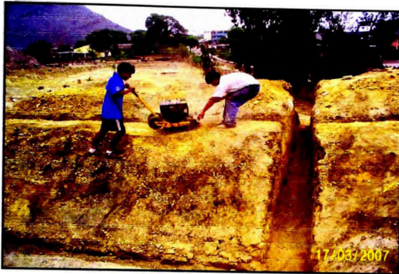
Foto N° 3.8 Compactación de la banqueta del deposito de relaves
