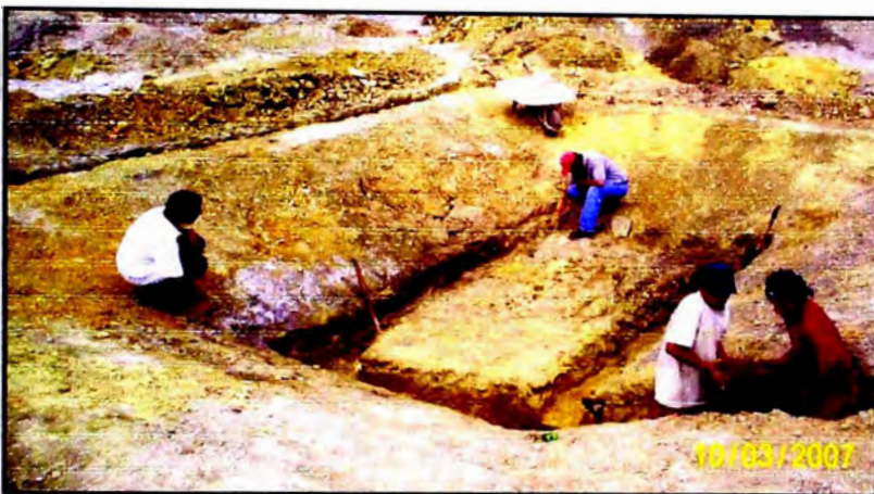
Foto N° 3.7 Verificación de los trabajos de excavación, en zanjas de anclaje.
