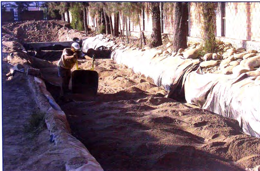
Figura 4.4: colocación de material cernido en el terreno Impermeabilizado con plástico
