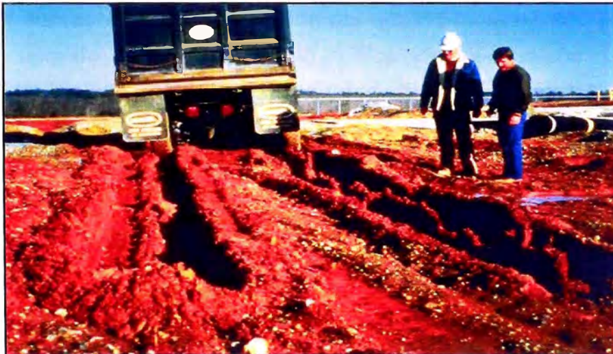
Figura 2.3 Estabilización con cemento
