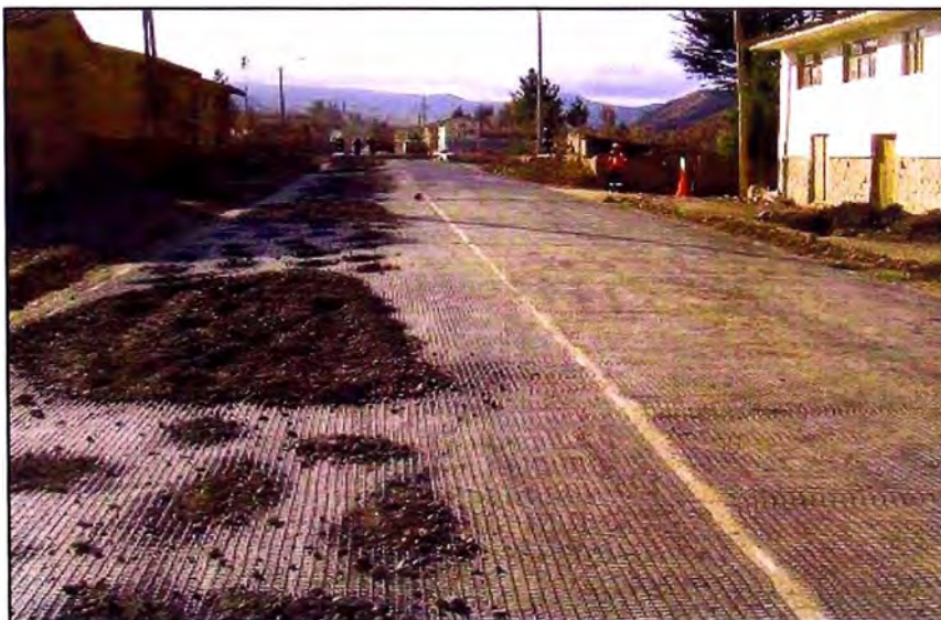
Figura 1.12 - Interoceánica Sur - Ccatca Km. 42+200, 2006 Geomalla Biaxial BX1100 (Refuerzo de Base)
