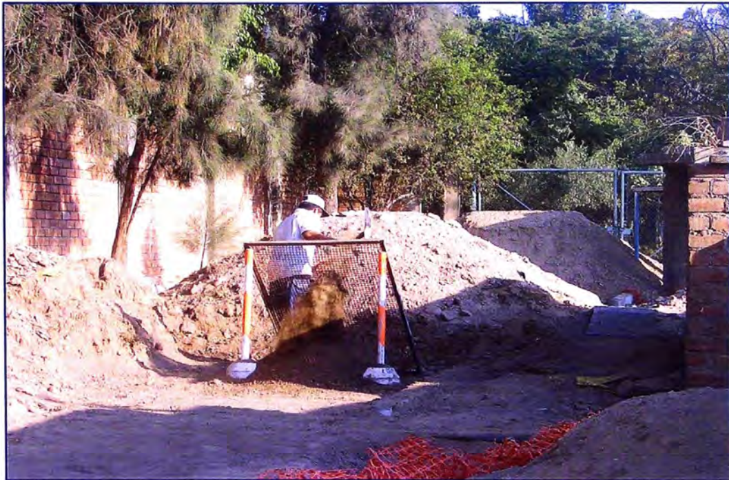
Figura 4.3: Personal zarandeando el material para ser usado como suelo de fundación.
