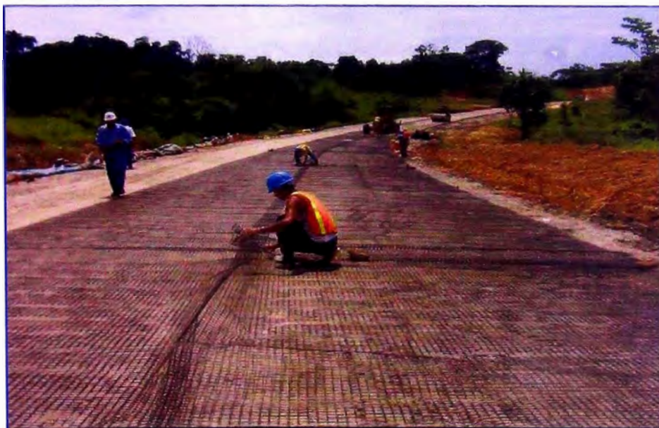
Figura 2.5 Mejoramiento de Subrasante aplicando Geomalla Carretera Iquitos – Nauta, 2004
