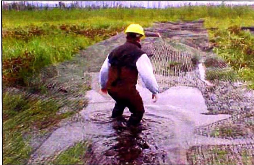
Figura 1.13 – Aplicación de Geomalla en zona pantanosa
