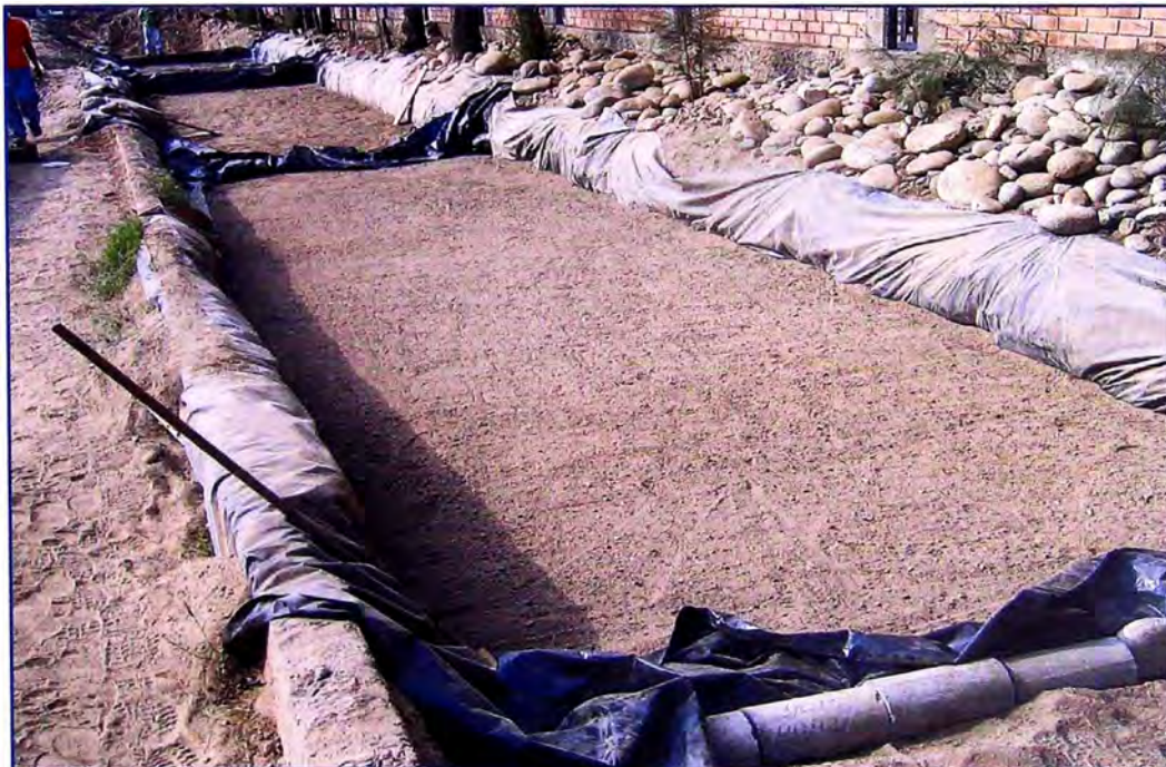
Figura 4.6: Nivelación del material degradado
