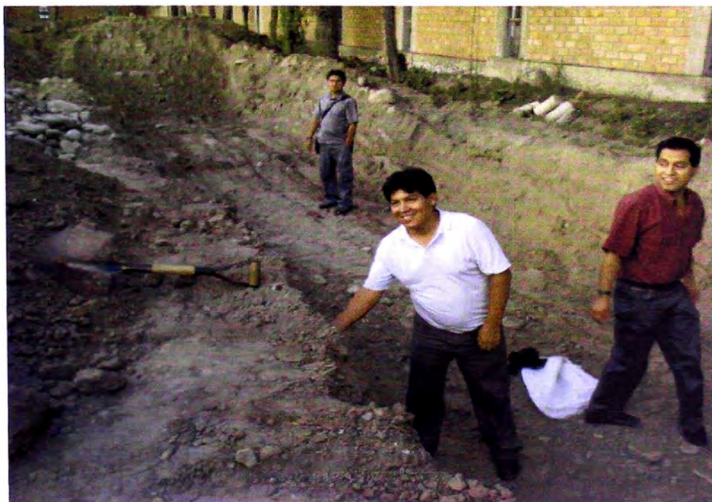
Figura 4.2: Excavación del terreno
