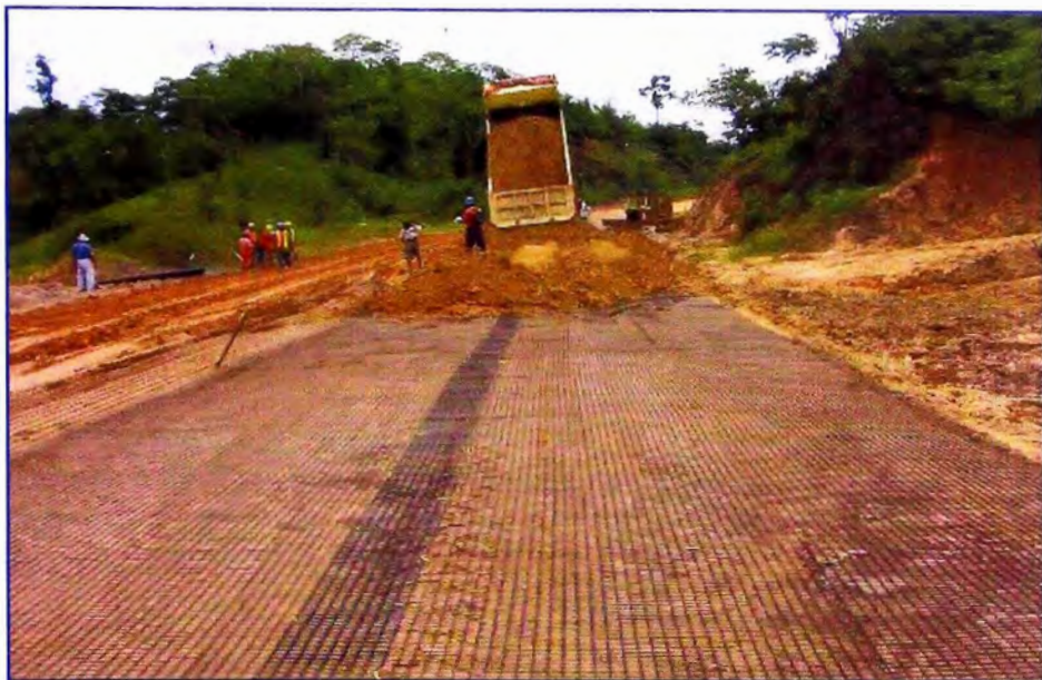
Figura 2.4 Mejoramiento de Subrasante aplicando Geomalla Carretera Iquitos – Nauta, 2004, Tramo IV: entre Nauta y Puente Itaya.
