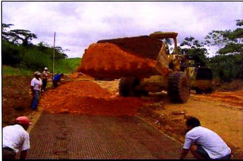
Figura 1.11 - Carretera Tarapoto – Yurimaguas, 2005 (Provias Nacional) Geomalla Biaxial BX1200 (Mejoramiento de subrasante)
