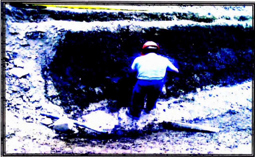
FOTO 01: En esta foto se aprecia la excavación de la poza realizado por uno de los trabajadores.
