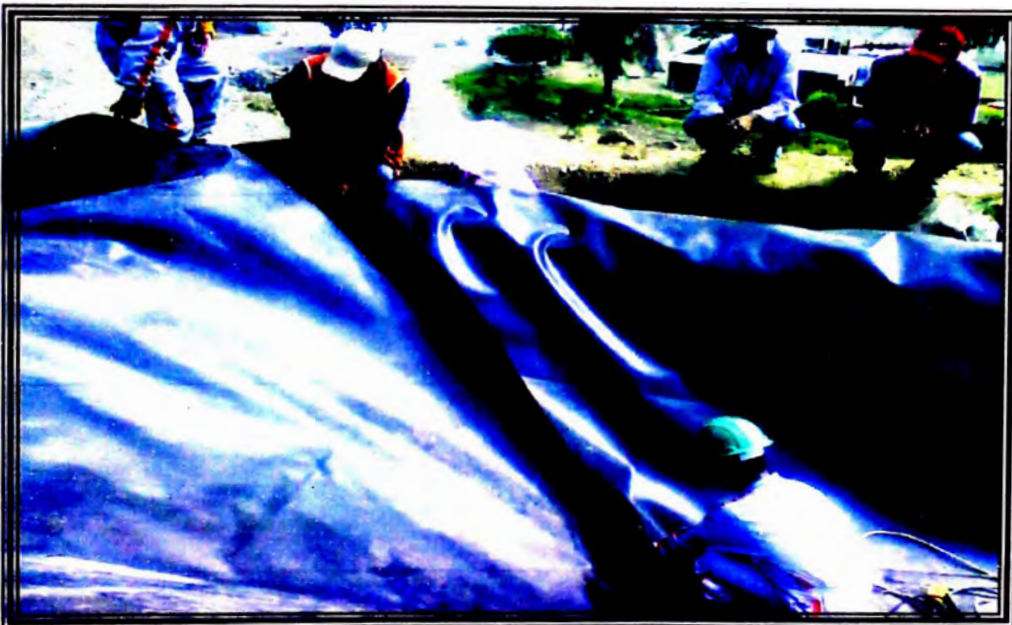
FOTO 04: En esta foto podemos apreciar la colocación de la geomembrana en una de las aristas de la poza.
