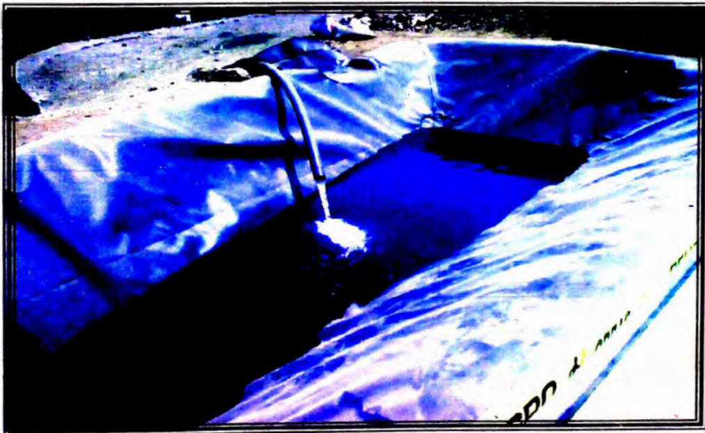
FOTO 08: En esta foto podemos apreciar el llenado de la poza mediante la tubería de impulsión proveniente de la poza inferior.
