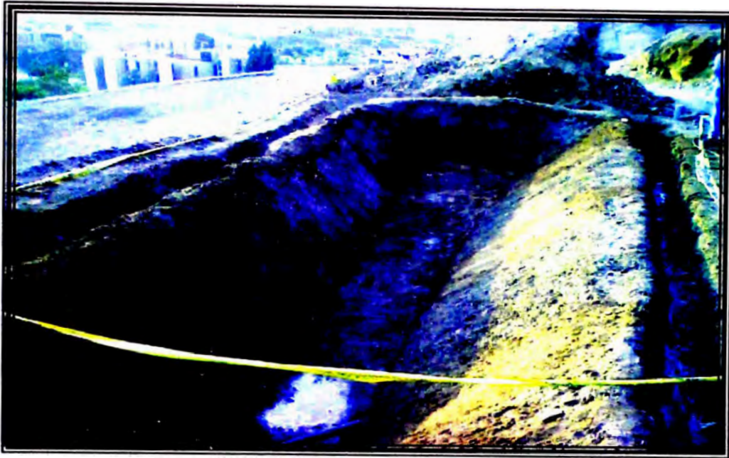
FOTO 03: En esta foto se aprecia la poza lista para la instalación del geotextil.
