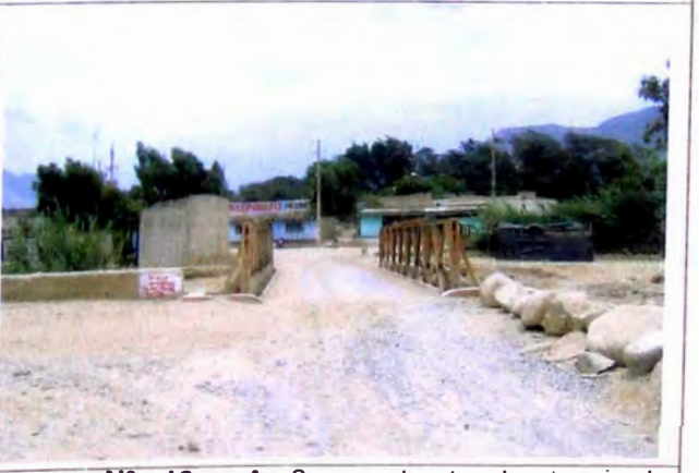
FOTO N° 18 A 3 m, de borde izquierdo afloramiento de roca fija, FIN TRAMO PUENTE MANCHAY en tramo 4+920-9+949
