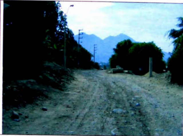
FOTO N° 13 Ambos bordes de carretera presencia de vegetación, en borde derecho canal de regadío, en tramo 9+230-9+380
