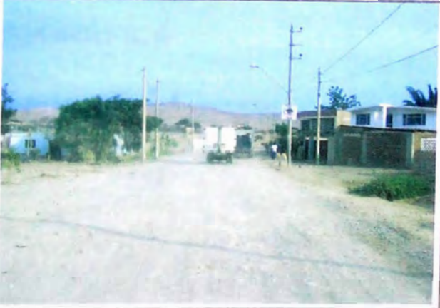
FOTO N° 46 Ambos bordes de carretera presencia de viviendas, en borde derecho postes de luz. en borde izquierdo postes de línea de teléfono en tramo 16+320-16+360
