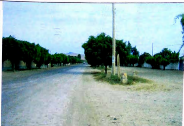
FOTO N° 41 Ambos bordes de carretera viviendas, empieza doble vía, trazo por lado izquierdo en berma central presencia de arbustos en tramo 15+200-15+400
