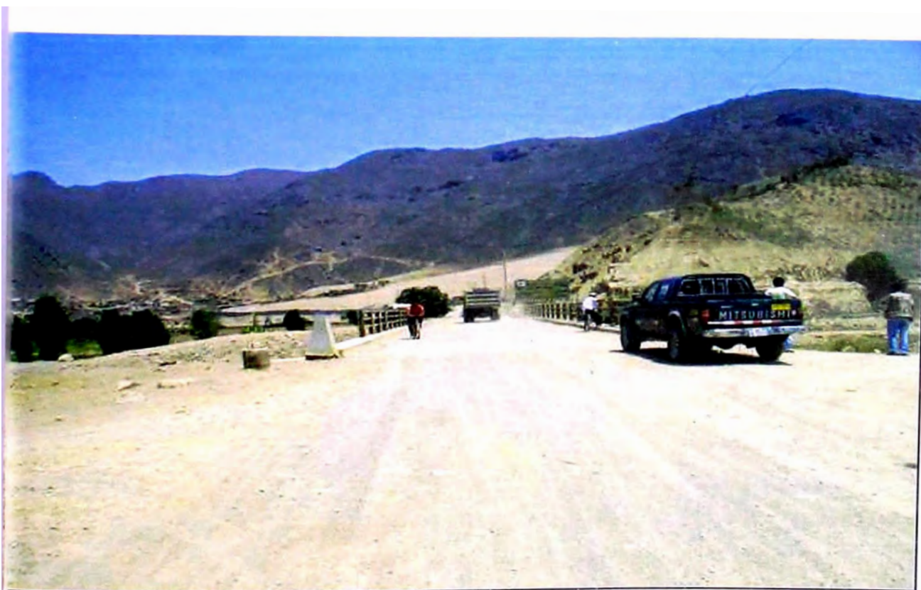
Km. 14+800: Puente Pachacamac sobre el río Lurín.
