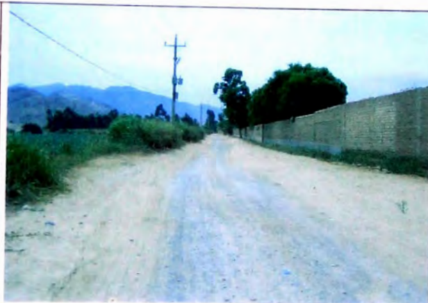
FOTO N° 20 En borde derecho terreno de cultivo, en borde izquierdo canal de regadío y cerco, tramo está a 0.50 m, por debajo terreno de cultivo, en tramo 10+310-10+770
