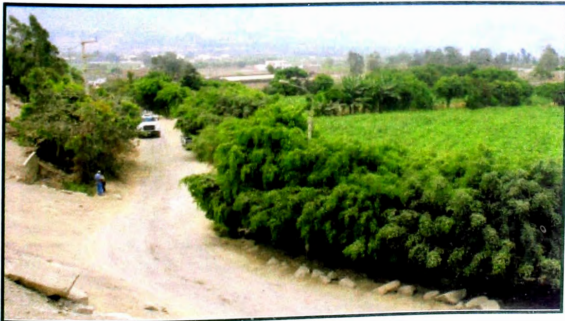
ACUEDUCTO: KM. 9+2400 (TRAMO -I)
