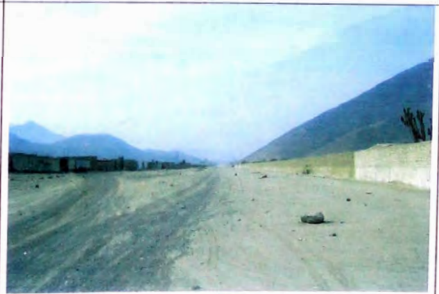
FOTO N° 10 Ambos bordes carretera ubicación de viviendas ancho de vía 25 m, trazo por carril derecho en tramo 7+500-8+500
