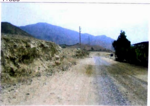
FOTO N° 10 Roca fija ubicada a 2 m, de lado izquierdo de carretera 4 m, de alto y 75° de talud en tramo 2+370-2+500
