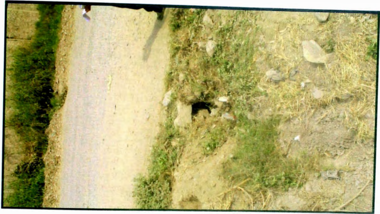
ALCANTARILLA: KM. 10+186.50 (TRAMO – I)
