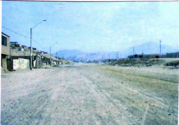
FOTO N° 05 En ambas márgenes de carretera ubicación de viviendas ancho de la vía 25 m, carretera por carril derecho en tramo 2+000-2+860
