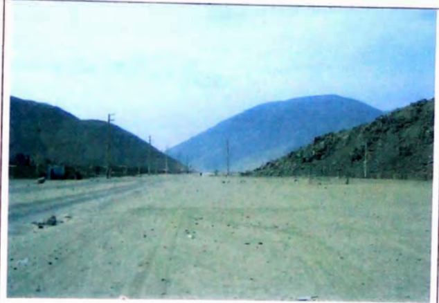
FOTO N° 08 Tramo se reduce el ancho de la vía a 12 m, por invasión de viviendas en tramo 4+340-4+840
