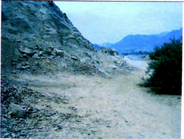
FOTO N° 33 Material suelto depositado en ladera de cerro alteración de roca fija, bolonería y clastos medianos con matriz areno gravosa en tramo 13+620-13+740
