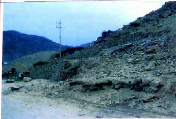
FOTO N° 24 Gaviones construidos como muros de contención en quebrada seca, en tramo 11+210-11+250
