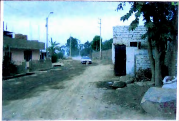
FOTO N° 16 Borde derecho cerco material noble, borde izquierdo casas y canal de regadío CPR MANCHAY BAJO en tramo 9+510-9+580
