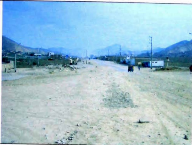
FOTO N° 07 En este tramo, trazo carretera pasa carril izquierdo por invasión e instalación de viviendas en tramo 3+760-4+340
