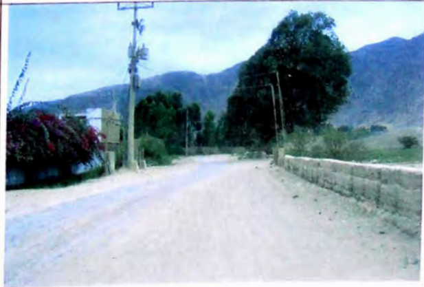
FOTO N° 18 Borde derecho cerco de terreno de adobe, borde izquierdo canal de regadío, en tramo 10+030-10+270
