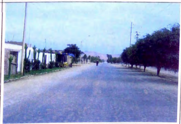
FOTO N° 42 En borde izquierdo viviendas y en borde derecho berma central con arbustos, en tramo 15+400-16+100
