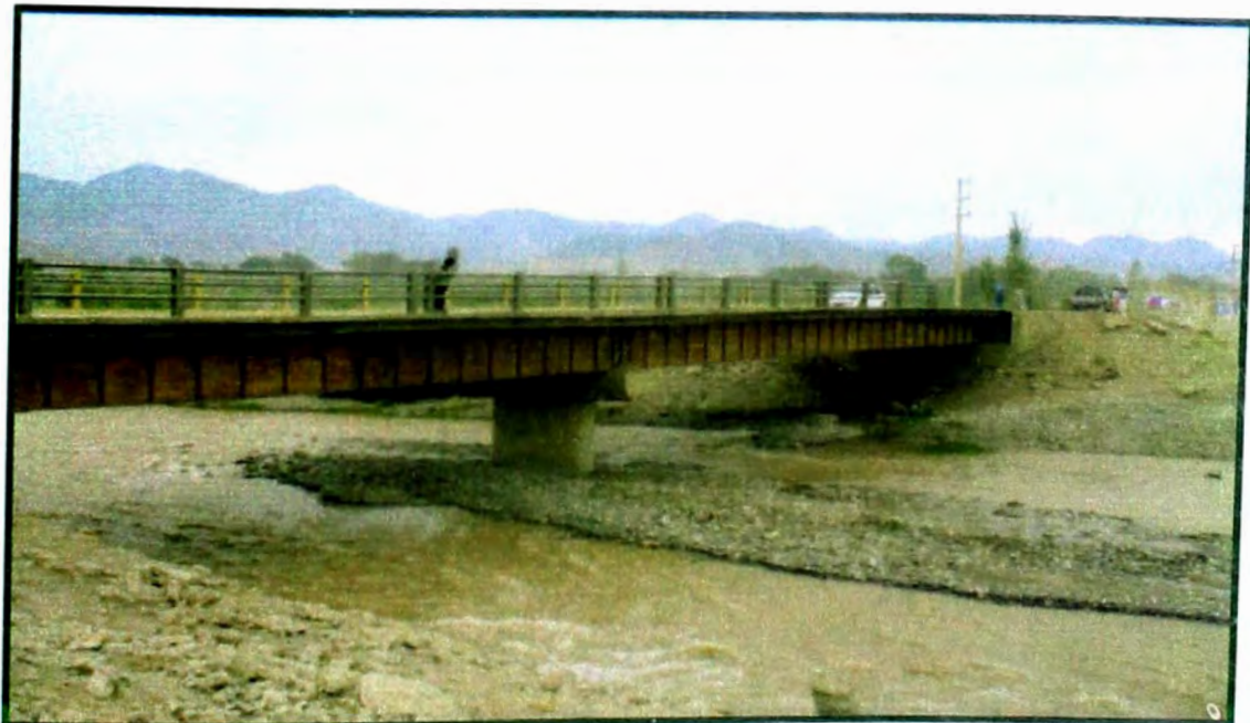
PUENTE PACHACÁMAC: KM. 14+754.42
