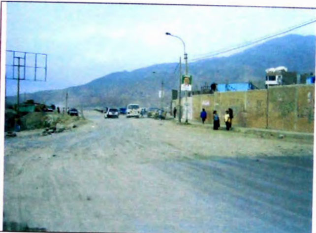
FOTO N° 01 Inicio de carretera, fin de tramo asfaltado en Portal de Manchay en terreno firme en tramo 1+650-2+000
