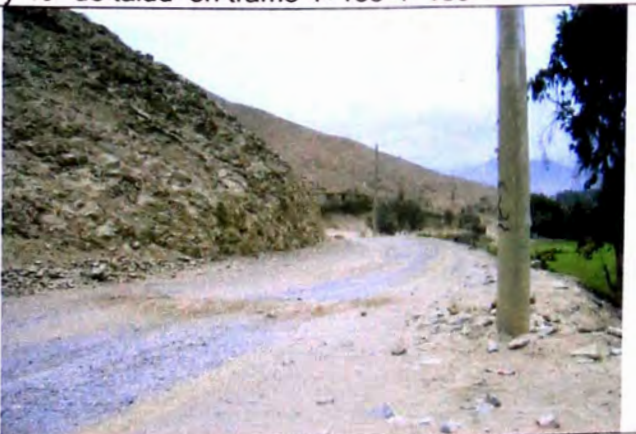
FOTO N° 17 A 2 m, de lado izquierdo afloramiento de roca fija fracturada, en tramos alterada, en tramo 4+700-4+770
