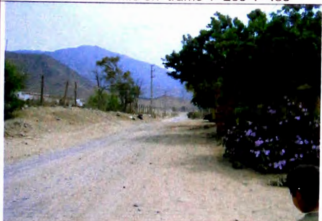
FOTO N° 09 A 2 m, de lado derecho terraza de 2 m, de altura material suelto transportado, depositado en quebrada Manchay Alto en tramo 1+900-2+100
