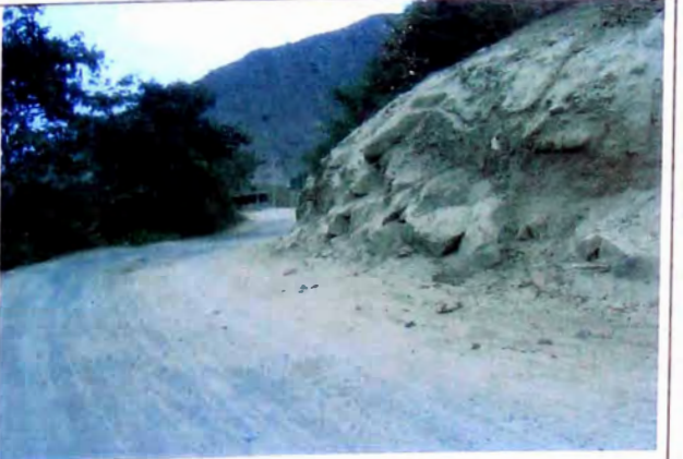
FOTO N° 30 Afloramiento de roca fija en borde derecho de carretera, altura de banco 3 m, 75° de talud en tramo 12+935-12+960
