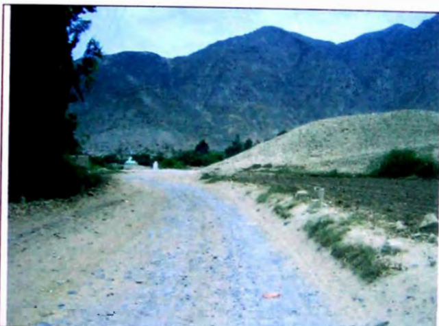
FOTO N° 19 Material suelto transportado depositado en ladera de cerro clastos de 10" a 15", matriz arenosa gravosa en tramo 10+270-10+310
