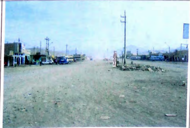
FOTO N° 06 Continúan emplazamiento de viviendas en ambos bordes de carretera manteniéndose el trazo por el carril derecho en tramo 2+860-3+760
