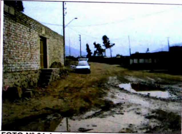
FOTO N° 01 Ambos bordes de carretera viviendas CPR MANCHAY BAJO, en tramo 00+00-00+100
