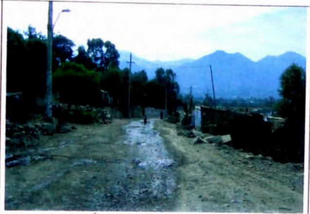
FOTO N° 14 Ambos lados viviendas, en borde izquierdo postes de luz, lado derecho, en tramo 9+380-9+460
