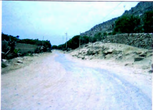
FOTO N° 21 En borde izquierdo canal de regadío y cerco, borde derecho roca suelta, alteración de roca fija, matriz areno arcillosa, en tramo 10+770-10+860
