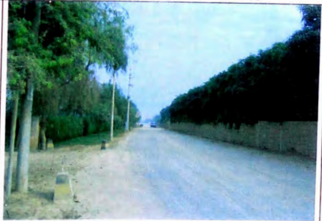
FOTO N° 40 Borde derecho de carretera muro de ladrillo de 2 m, de alto, borde izquierdo cerco de malla y muro de ladrillo y postes de luz en tramo 15+000-15+200
