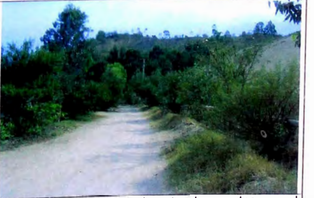
FOTO N° 36 En borde derecho de carretera canal de regadío y tubería de conducción de agua, en borde izquierdo terreno de cultivo, en tramo 14+000-14+150
