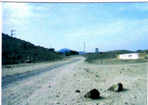
FOTO N° 11 Ambos bordes carretera viviendas, trazo por carril derecho, FIN doble vía en tramo 8+500-9+150
