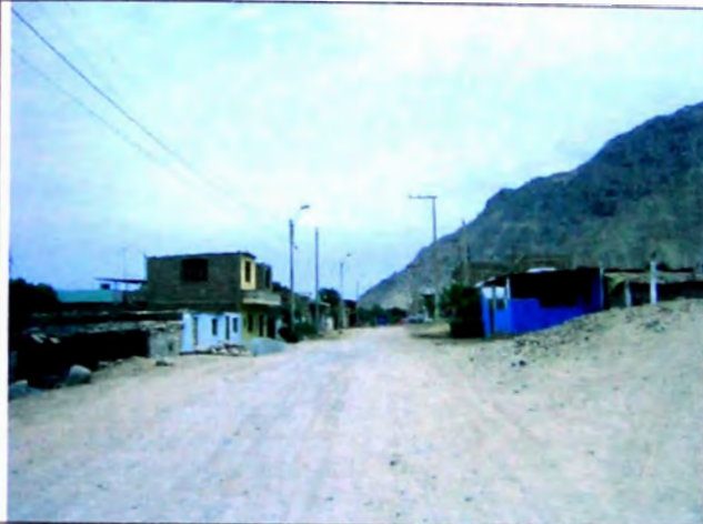
FOTO N° 25 Ambos bordes de carretera, emplazamiento de viviendas CASERIO PICAPIEDRA Material, en tramo 11+250-12+000
