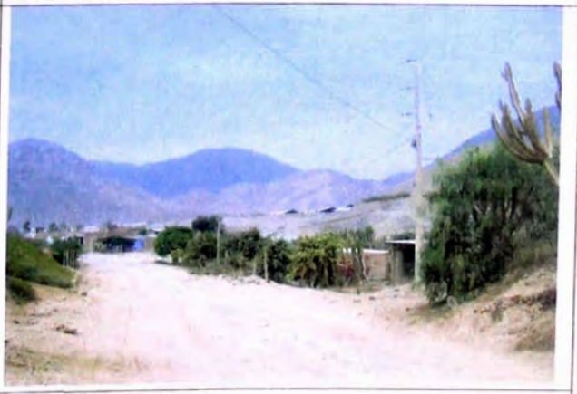
FOTO N° 12 Material suelto, a 3 m de borde interno canal de regadío, en borde derecho postes de luz, en tramo 3+060-3+300
