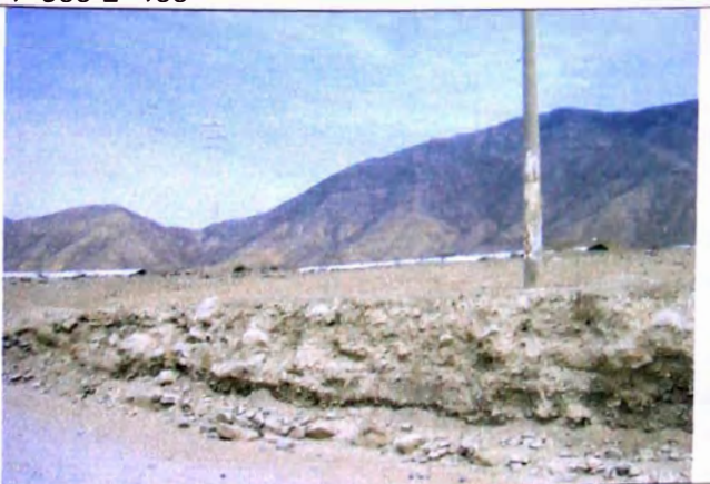
FOTO N° 11 Material suelto aluvial depositado en quebrada seca en lado izquierdo de carretera en tramo 2+860-2+960
