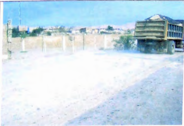
FOTO N° 48 Ambos bordes de carretera presencia de viviendas, en borde derecho postes de luz, en borde izquierdo postes de teléfono. FIN TRAMO, progresiva 16+360-16+564
