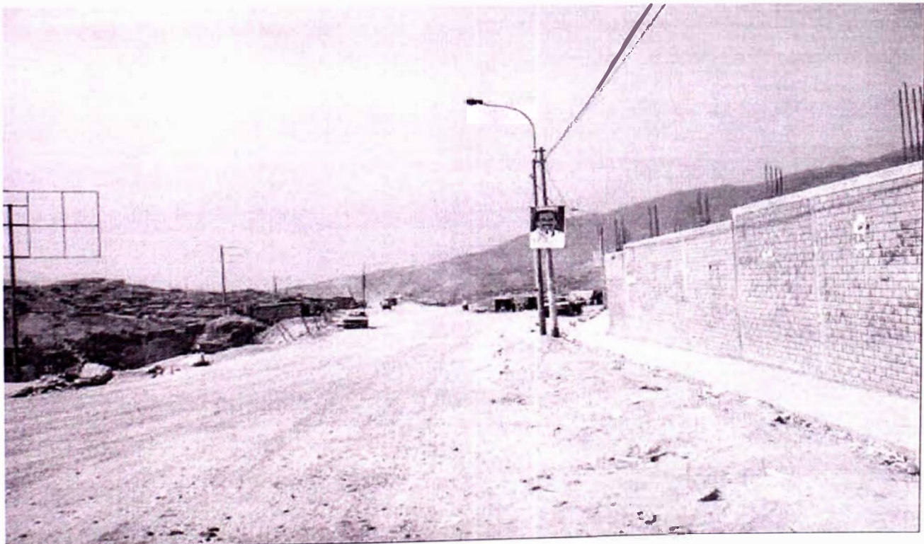
Km. 0+000: Inicio del tramo I en Manchay. 295189E – 8662726N
