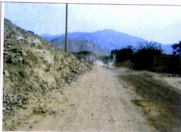
FOTO N° 08 A 2 m, de borde izquierdo roca fija altura de banco 3 m, 70° de talud en tramo 1+480-1+500
