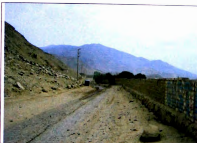
FOTO N° 07 Material suelto depositado en ladera de cerro, en lado izquierdo de carretera, en borde derecho cerco ladrillo en tramo 1+260-1+480
