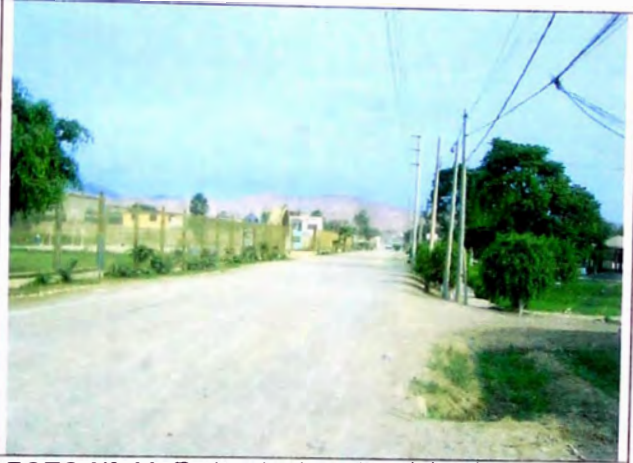
FOTO N° 44 En borde derecho viviendas y postes de luz. en borde izquierdo cerco de malla, en tramo 16+100-16+280
