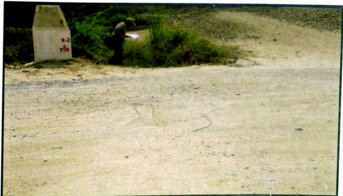
ALCANTARILLA: KM. 10+311.60 (TRAMO – I)
