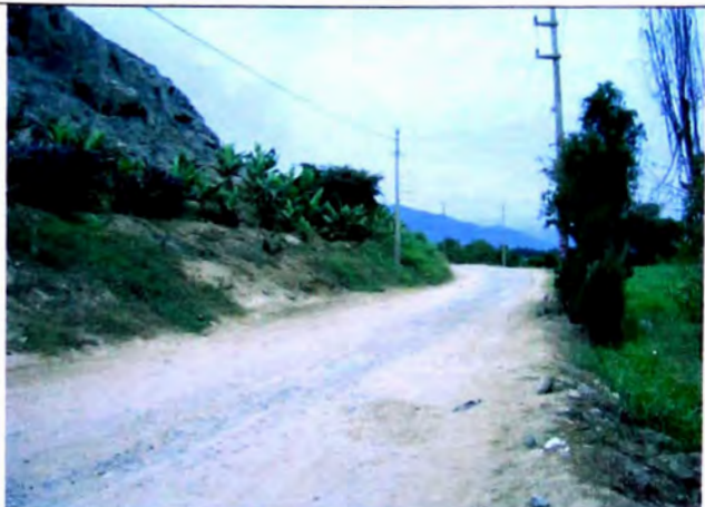
FOTO N° 27 En borde derecho material suelto depositado en ladera de cerro, altura de banco 3 m, 45° de talud, en borde izquierdo canal de regadío en tramo 12+410-12+560
