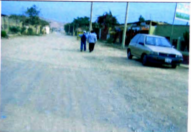
FOTO N° 45 Ambos bordes de carretera presencia de viviendas, en borde derecho postes de luz en tramo 16+280-16+320
