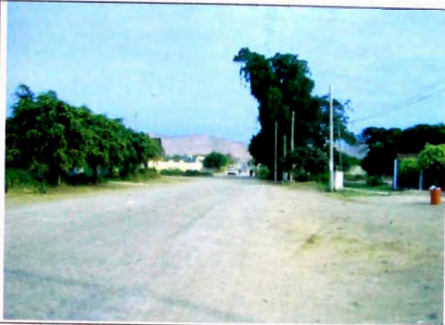
FOTO N° 43 FIN de tramo doble vía. en progresiva 16+000
