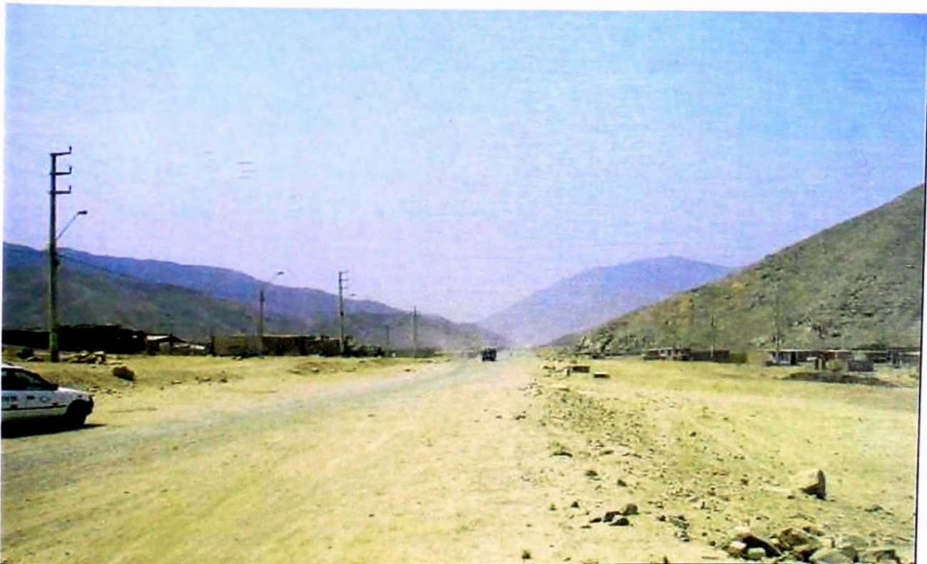
Km. 4+440: Vista del estado de la vía en Manchay
