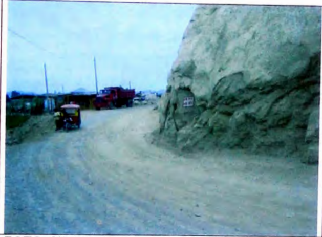
FOTO N° 32 En borde derecho de carretera afloramiento de roca fija, en tramo 13+490-13+550
