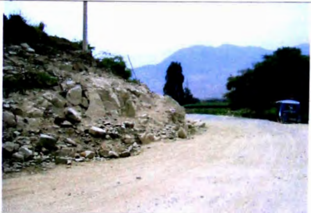
FOTO N° 15 A 2 m, de lado izquierdo afloramiento de roca fija, banco de 4 m, de altura y 45° de talud en tramo 4+100-4+180
