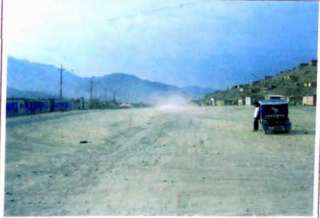
FOTO N° 04 Ambas márgenes de carretera viviendas, el ancho de la vía es de 25 m, de dos carriles, trazo va por carril derecho en tramo 1+460-2+000
