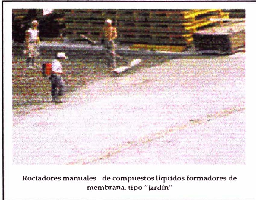
La Supervisión debe verificar la uniformidad del recubrimiento, y que la cantidad de material utilizado cubra toda la superficie requerida. Antes de reanudar el trabajo sobre un área que ha sido tratada con un compuesto de curado, asegúrese de que el compuesto tiene la suficiente resistencia para soportar pisadas u otro tipo de tránsito. Las partes dañadas se deben resellar inmediatamente durante el período de curado.
