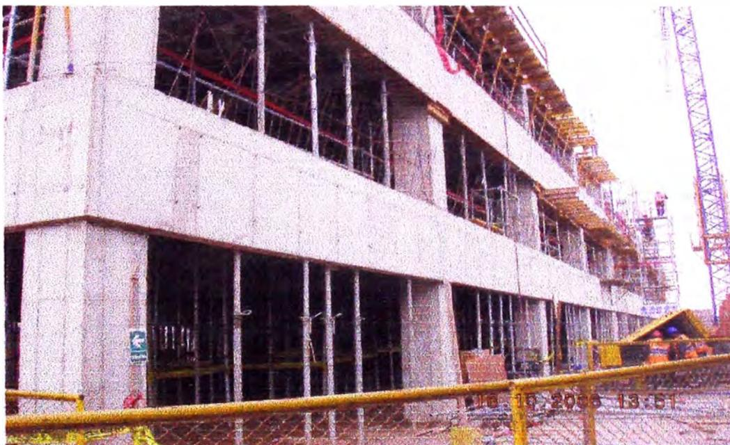
Se verifica que para proceso de vaciado de losa 3er. Nivel se han colocado puntales en los pisos inferiores.
