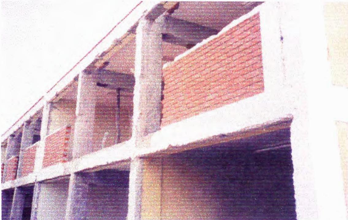
Para el proceso de reparación se ejecuta el desmontaje total de ventanas (ocasiona rotura de vidrios), corte y/o demolición de columnetas y muros, apuntalamiento y otros, pudiéndose haber evitado éstos con una adecuada Supervisión en la ejecución de la obra original.
