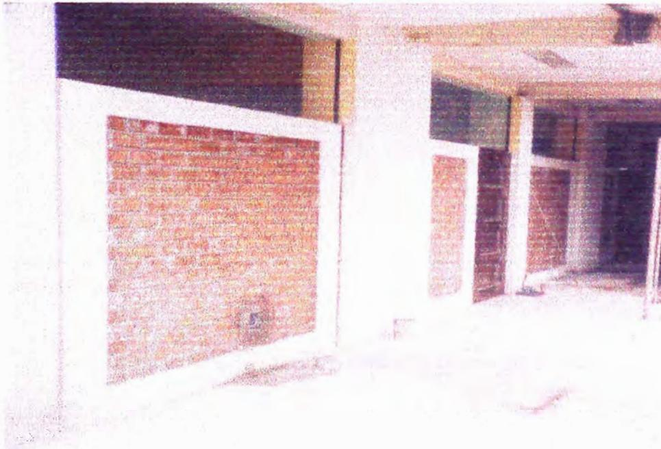
Acabado de placa de reforzamiento y tabiquería adyacente con juntas de espaciamiento adecuado.
