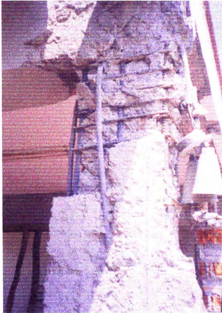
Detalle de falla por "columna corta" ubicada en la parte superior de columna
