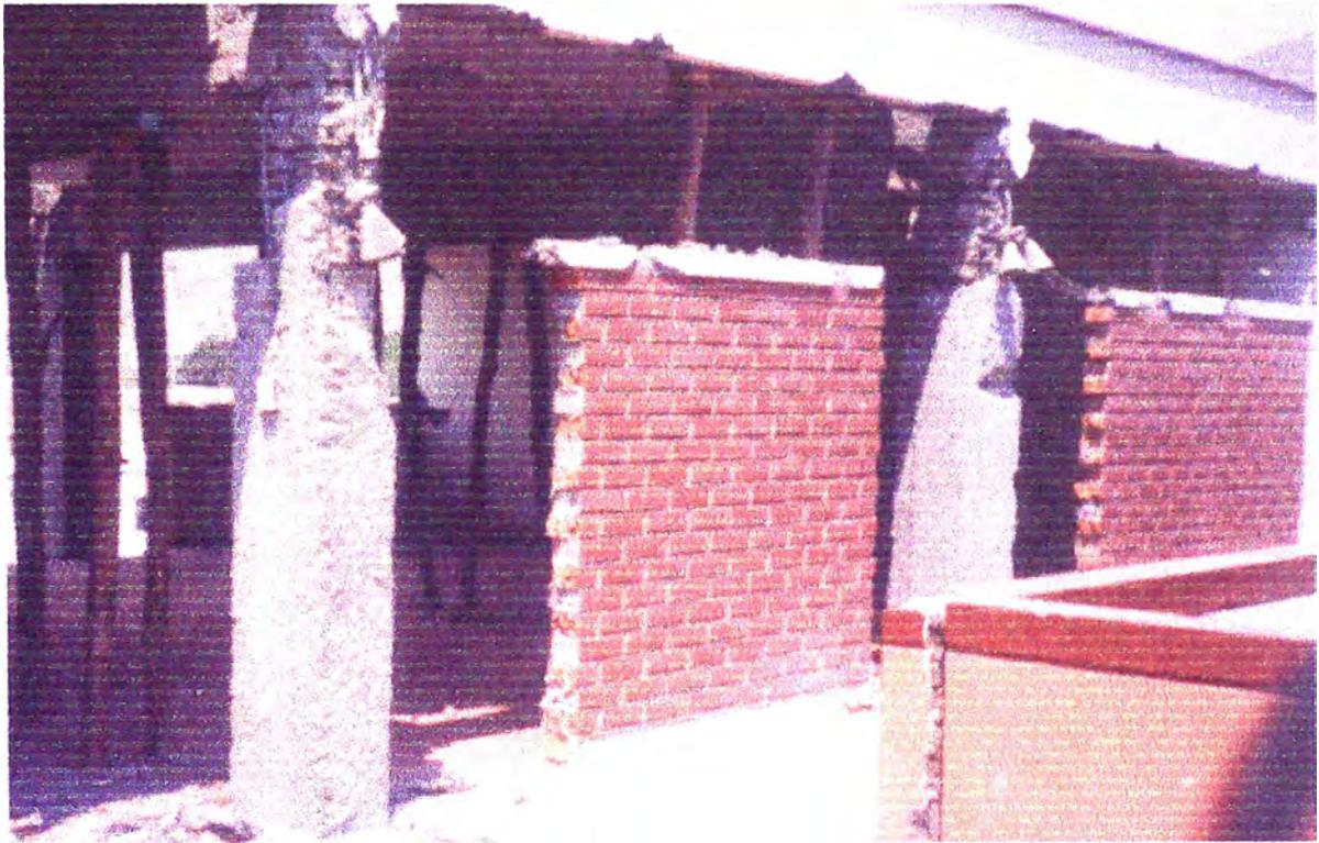
Se observa en la parte superior de las columnas falla por columna corta
