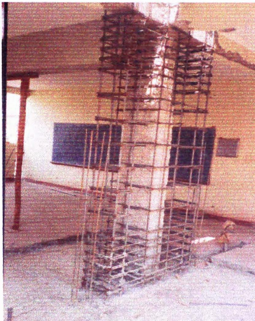
Vaciado de zapatas, colocación adecuada de acero en placas de reforzamiento y columnetas dejando el espaciamiento necesario para la construcción de juntas libres (sin relleno).
