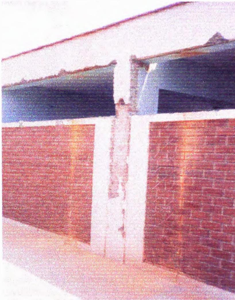
Desplazamiento de tarrajeo en columnas, por deficiencia en construcción de juntas.
