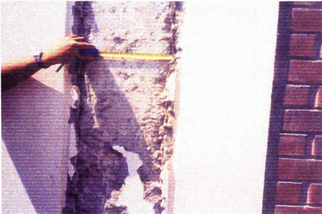
Desprendimiento de tarrajeo debido a falta de adherencia del acabado con el concreto y además juntas deficientes, se observa que se ha dejado bolsas de cemento entre elementos adyacentes debiendo ser una junta libre de 1.5".
