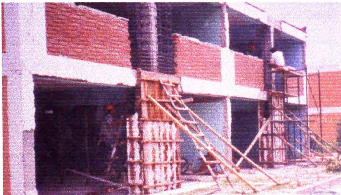
Encofrado de placas de reforzamiento. Se observa el sellado de la unión de la madera del encofrado para evitar la filtración de la lechada de cemento, así como también la ubicación de ventanas en el encofrado para realizar los vaciados a alturas convenientes y así evitar la segregación del concreto.
