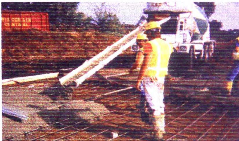
Fotos de colocación de concreto con cenizas, en una losa
