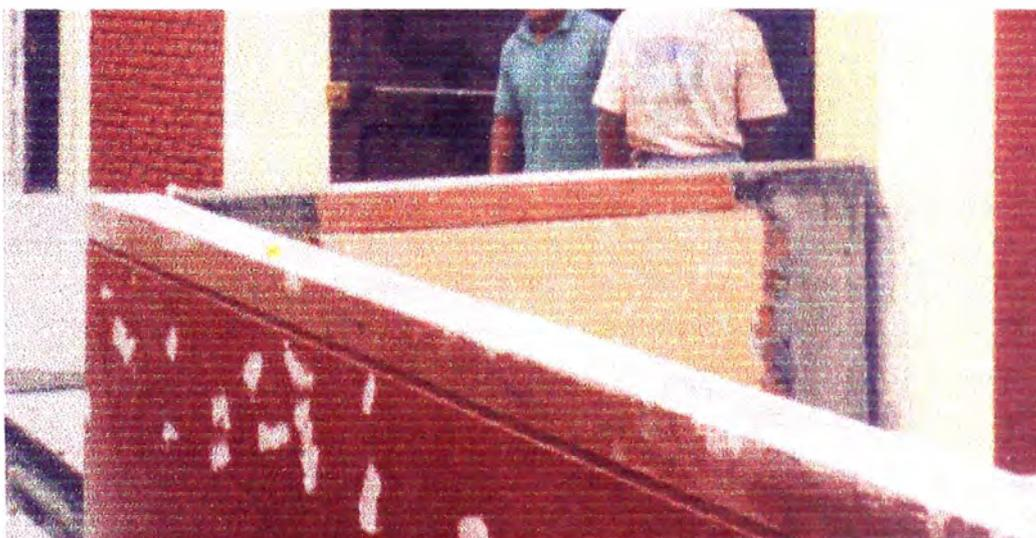
Reparación de columnas de parapeto considerando la existencia de la junta correspondiente
