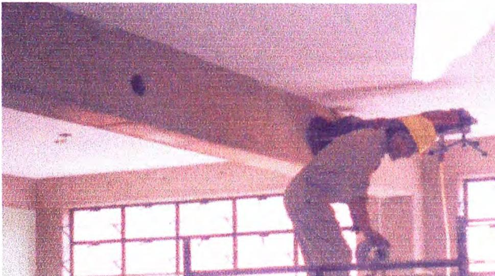
Se observa el procedimiento para la ubicación de lugar de donde se extraerán los testigos de concreto.
