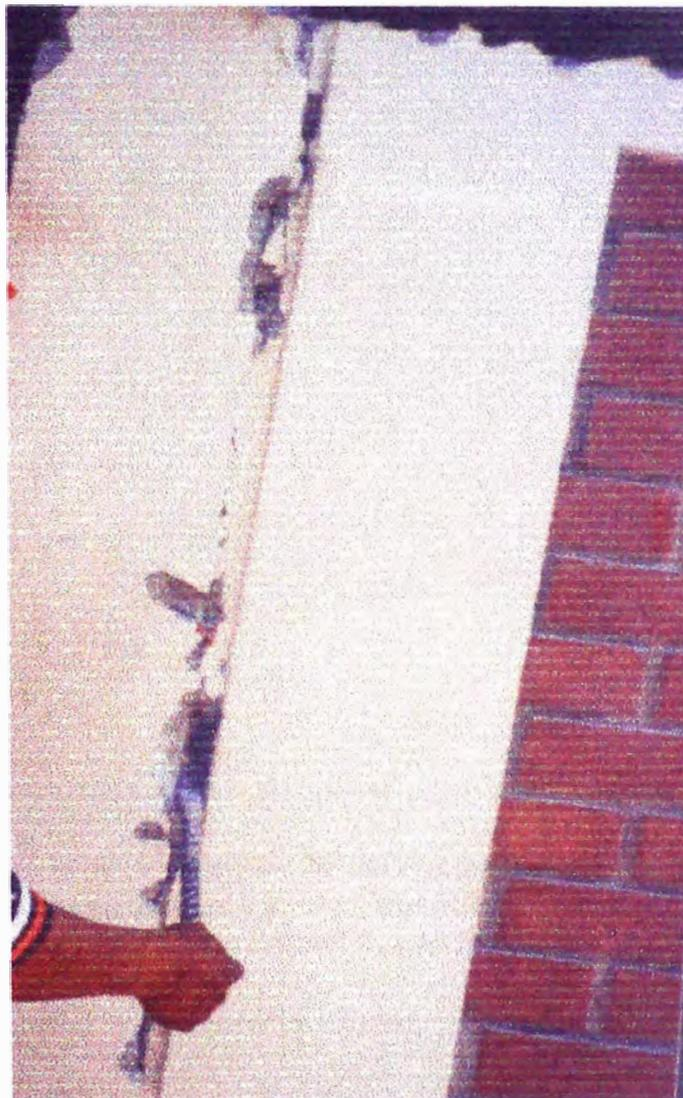
El proyecto contempla espaciamiento entre los elementos estructurales, sin embargo debido al proceso constructivo deficiente, el vaciado se ha llevado a cabo sin considerar el espacio para la junta, y en consecuencia el material que existe en ellas impide un buen desplazamiento de la columna durante un sismo.
