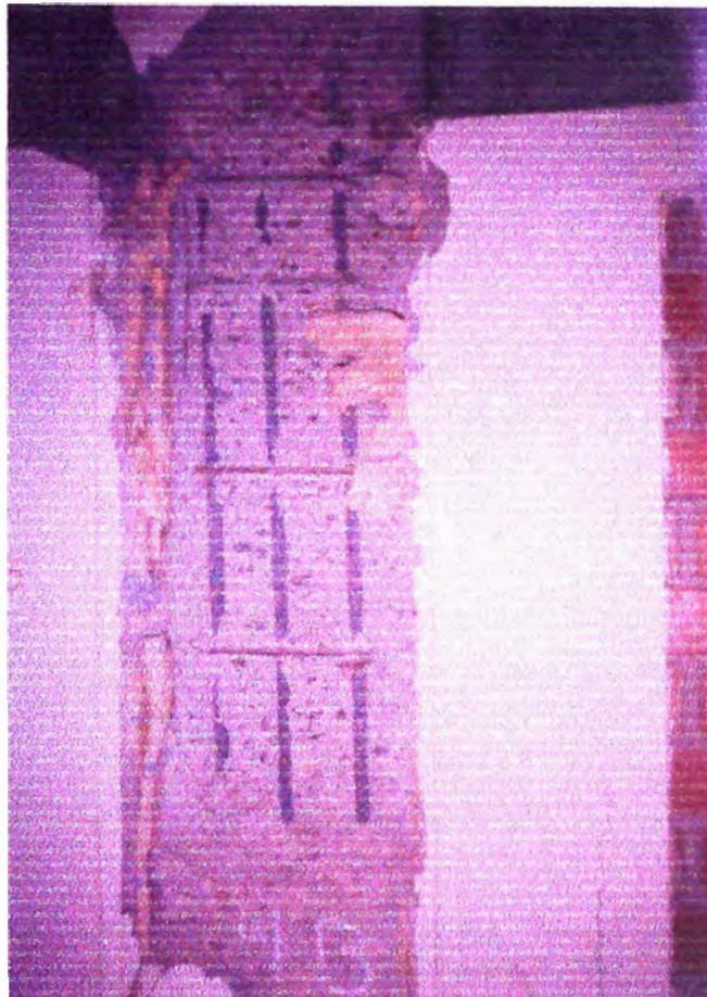
Desprendimiento de tarrajeo y recubrimiento del acero en columnas por deficiente comportamiento de ésta en caso de sismo al no poder desplazarse lateralmente por ausencia de juntas.
