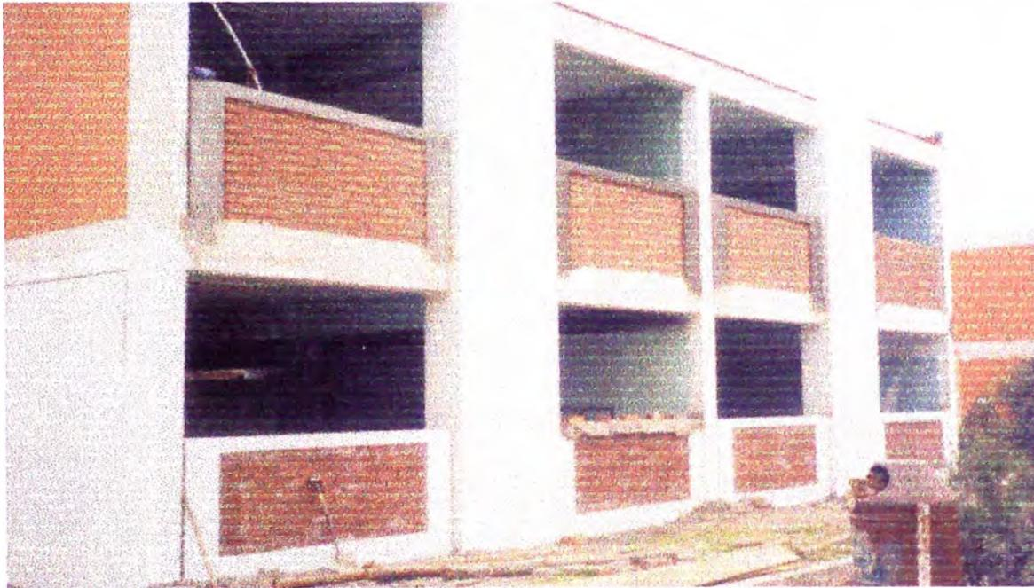
Placas de reforzamiento y columnetas concluidas con juntas para un adecuado comportamiento sísmico.
