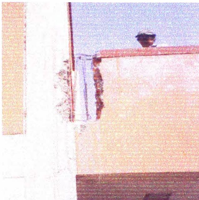
Proceso de reparación de junta deficientemente ejecutada ( picado de concreto de columna existente en parapeto).
