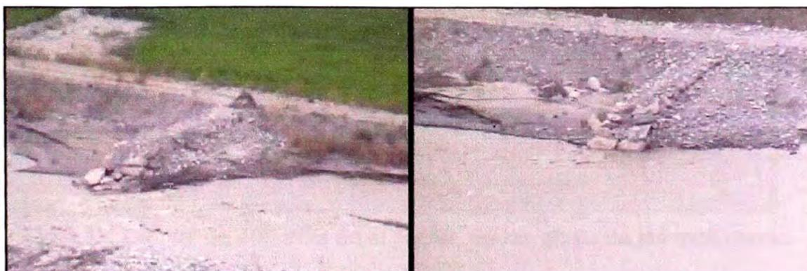
Fig 4.8. Desmoronamiento y colmatación de espigones (1er y 2do espigón)
