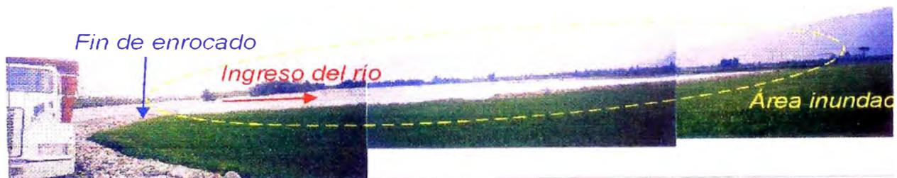
*Fig. 2.3. Inundación en cultivos de arroz - falta de continuación en el dique enrocado (Sector Sogiata) - fotografía en dirección aguas abajo margen derecha.*
