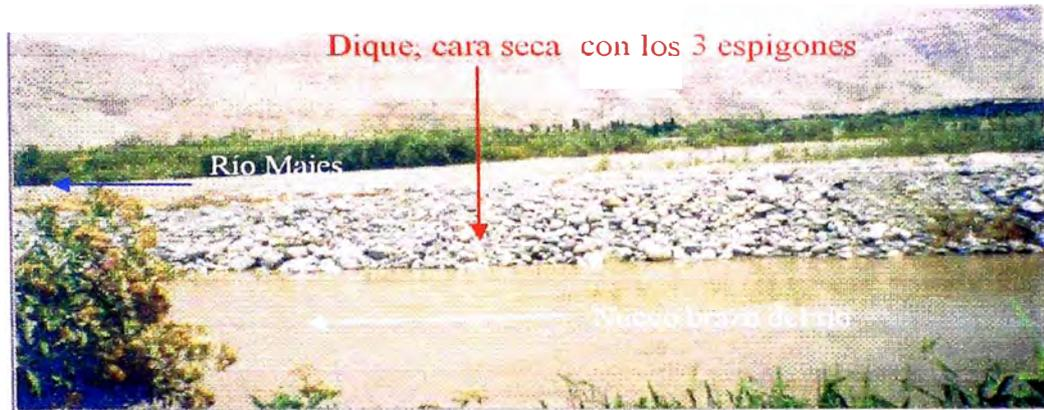
Fig. 2.17. Cara seca del Dique de Tomaca, espigones (3) en la parte posterior.
