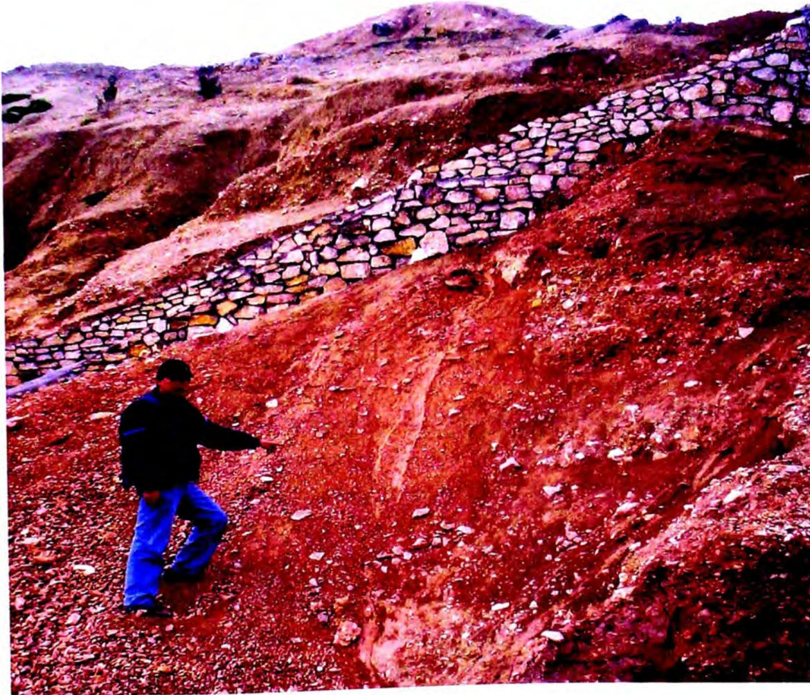
*Imagen N° 05.03: Deslizamiento ocurrido en el talud lateral del proyecto.*
