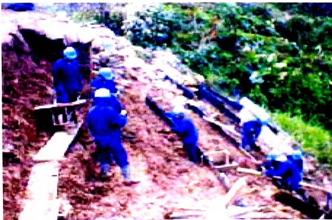
*Imagen N° 4.14: En el pozo San Martín 3, se realizaron trabajos de terrecerías y sembrado de plantas, como parte de la estabilización de taludes y protección contra la erosión.*
