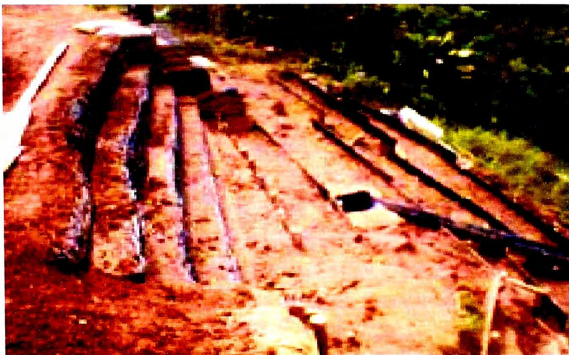
*Imagen N° 4.16: En el pozo San Martín 3, se ejecutaron trabajos de estabilización de taludes, mediante la construcción de terrecerías, con la finalidad de evitar la erosión y estabilizar el talud. Posteriormente se plantaron especies para aportar a la estabilidad del talud.*
