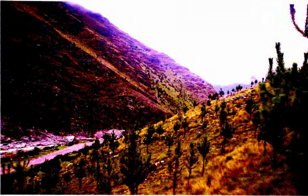
*Imagen N° 4.22: Vista lateral del Talud tratado mediante la reforestación.*
