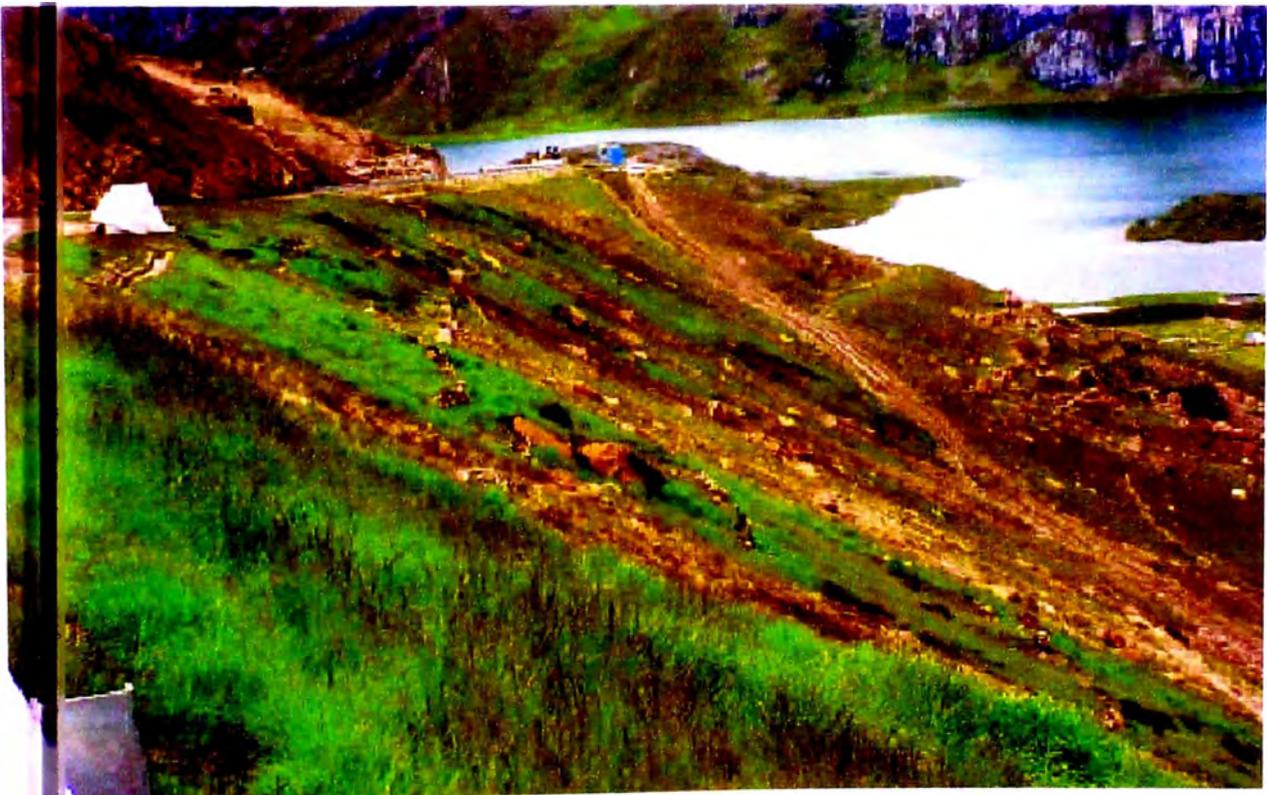
*Imagen N° 4.05: Resultado de crecimiento de pasturas en el talud de relleno (Km 94 + 000 carretera Conococha – Antamina)*
