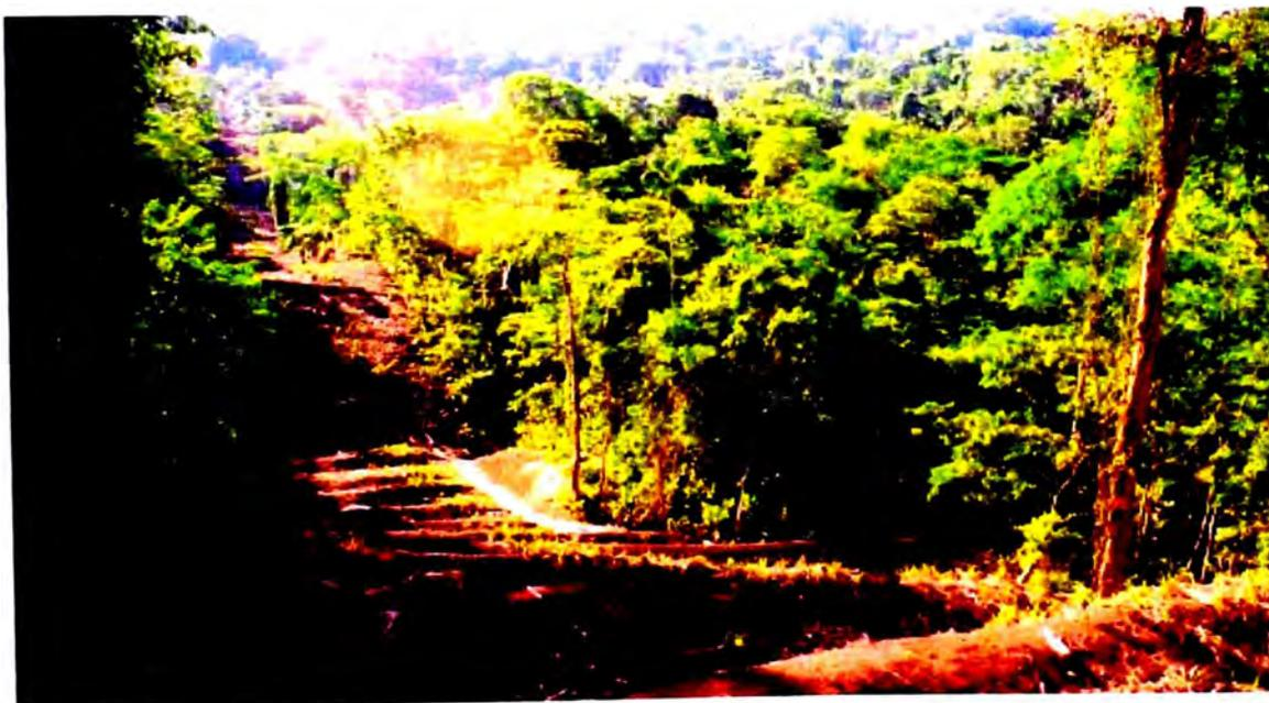
*Imagen N° 4.12: Entre los sectores SM1 y SM3, se construyeron andenes y se plantaron gramíneas "paja pichi" como control de la erosión e inestabilidad del talud.*
