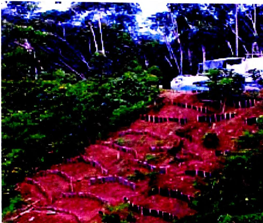
*Imagen N° 4.13: En el pozo San Martín 1, se realizaron trabajos de aterrazamiento y posterior ejecución de trincheras de contención por curva de nivel, direccionando el escunimiento hacia canales protegidos, lo cual generó estabilidad a los taludes.*
