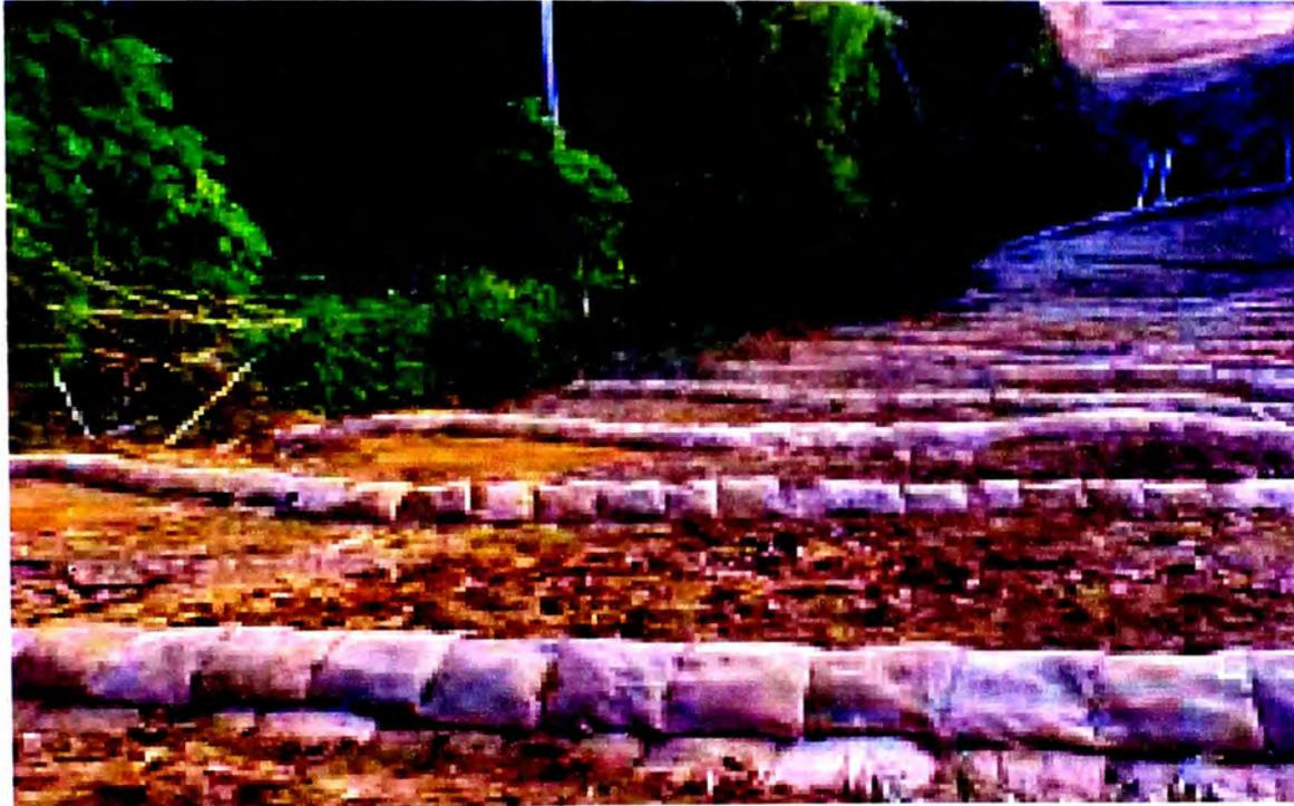
*Imagen N° 4.11: En la Progresiva Km3 +000, se realizaron trabajos de terracerías para el control de la erosión.*
