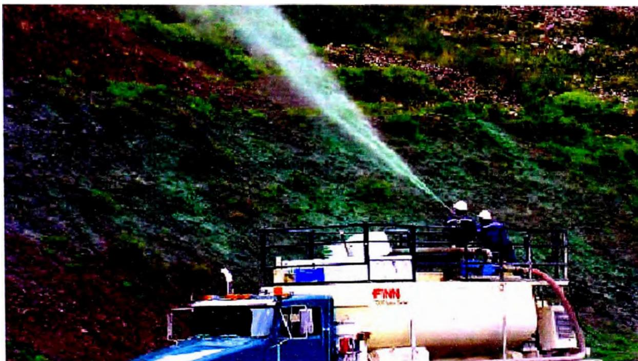
*Imagen N° 4.03: Hidrosiembra en Talud de Corte (Km 18 +800 carretera Conococha – Antamina)*
