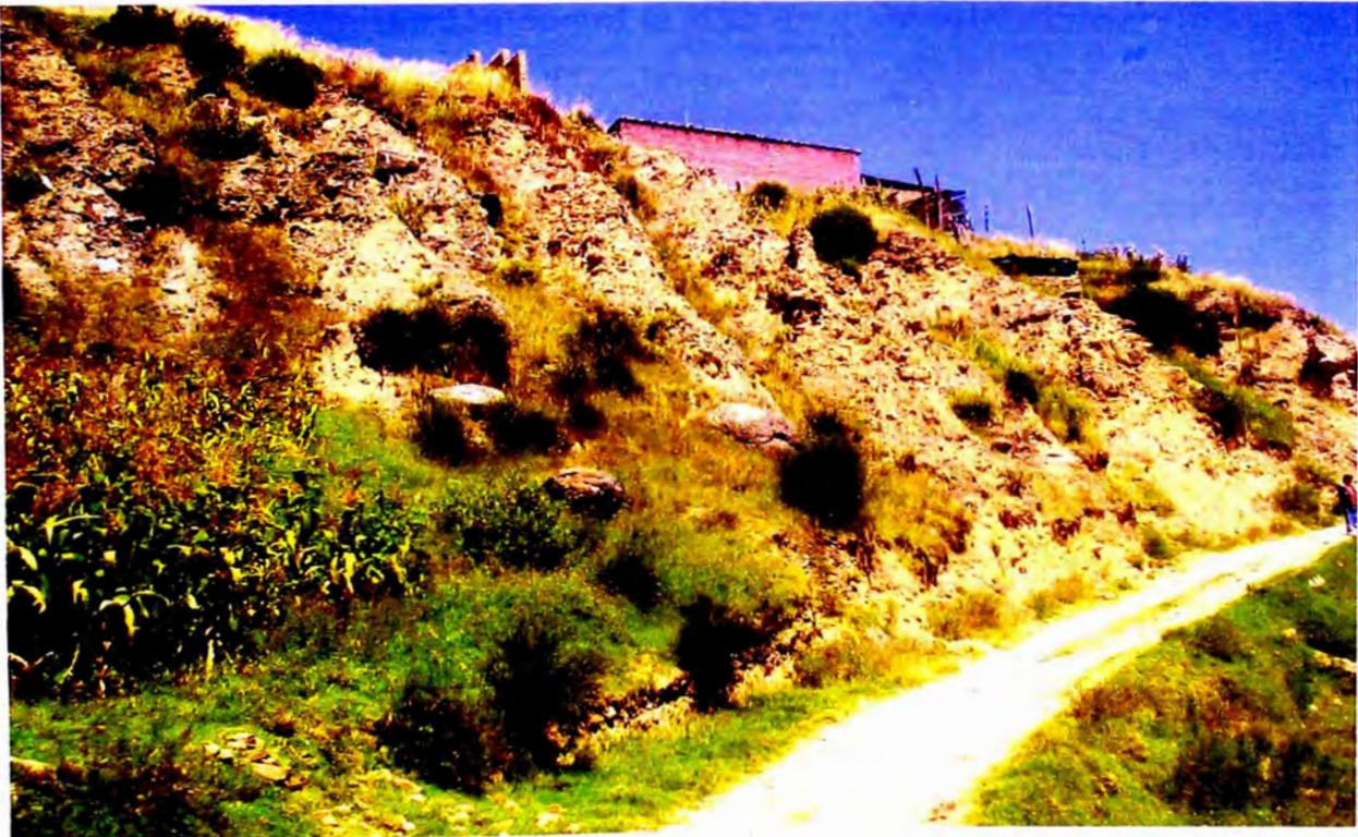
*Imagen N° 4.26: Sector cercano a "Torre Torre", se puede apreciar que el paso de las aguas pluviales han formado surcos en el terreno, que hacen que el talud sea inestable, poniendo en riesgo a las construcciones en la cima del talud.*
