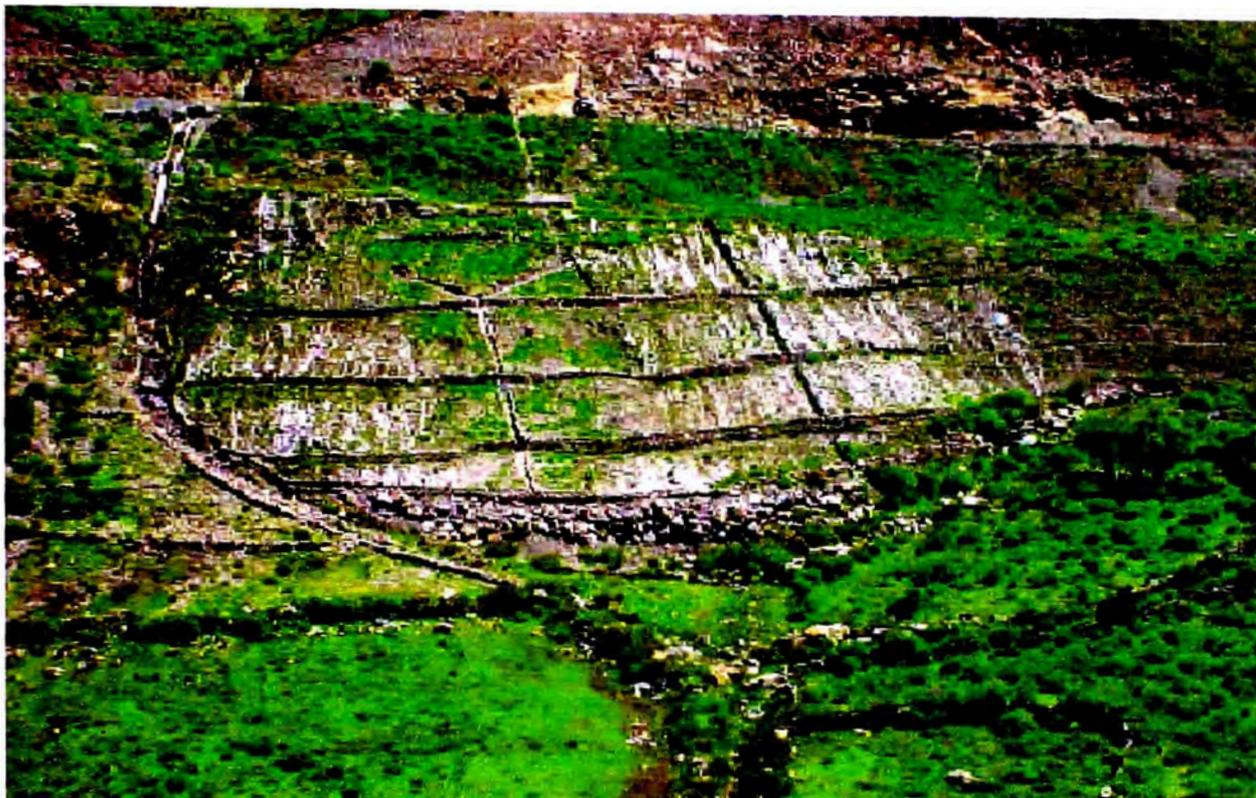
*Imagen N° 4.02: Siembra de especies forrajeras con trabajos de conformación de suelos y drenaje (Km 20 +000 carretera Conococha – Antamina)*
