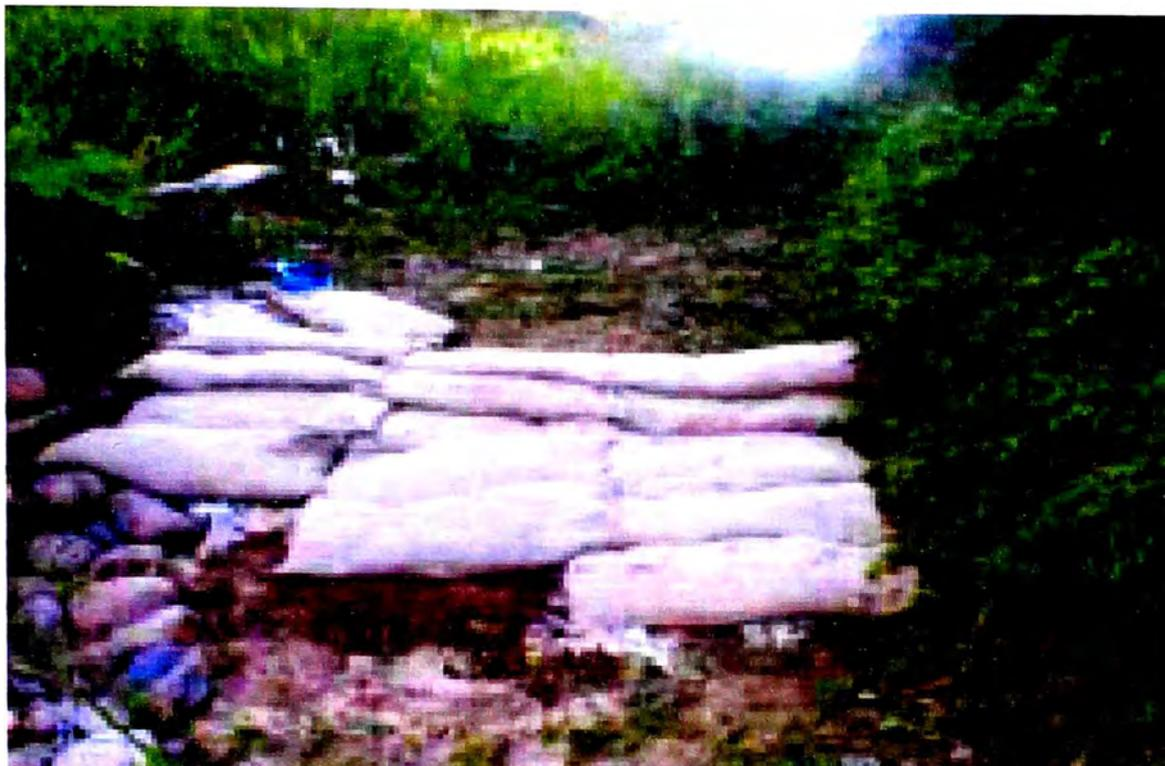
*Imagen N° 4.15: En la progresiva Km. 0 + 900 del sector Las Malvinas – San Martín 01, se realizaron trabajos de reparación de cárcavas con sacos de yute y esquejes. Con la finalidad de proteger el terreno donde está el gasoducto y el dieselducto.*
