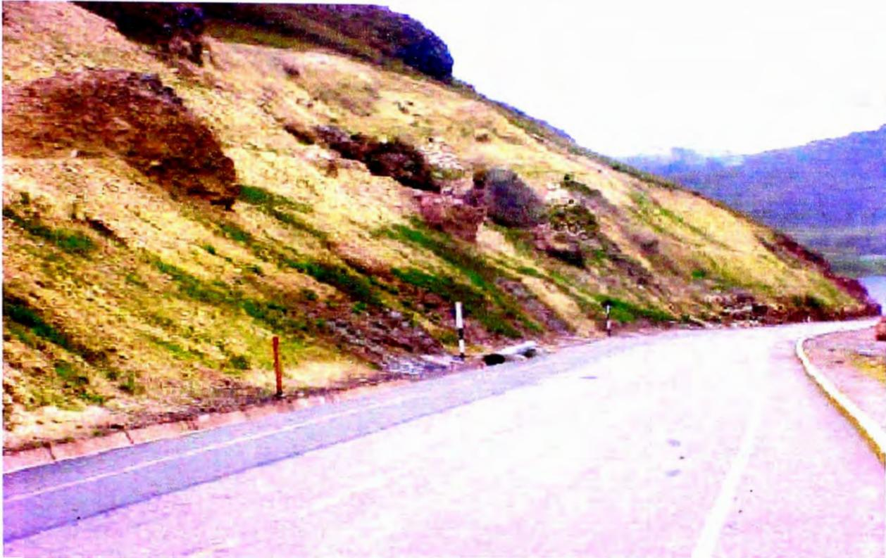
*Imagen N° 4.06: Resultado de Hidrosiembra en el talud de corte (Km 18 + 500 carretera Conococha – Antamina)*
