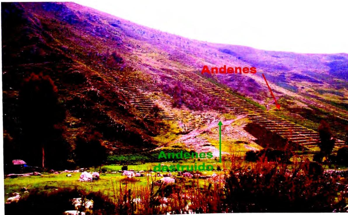
Imagen N° 4.24: Estabilización de taludes mediante la construcción de andenes.
