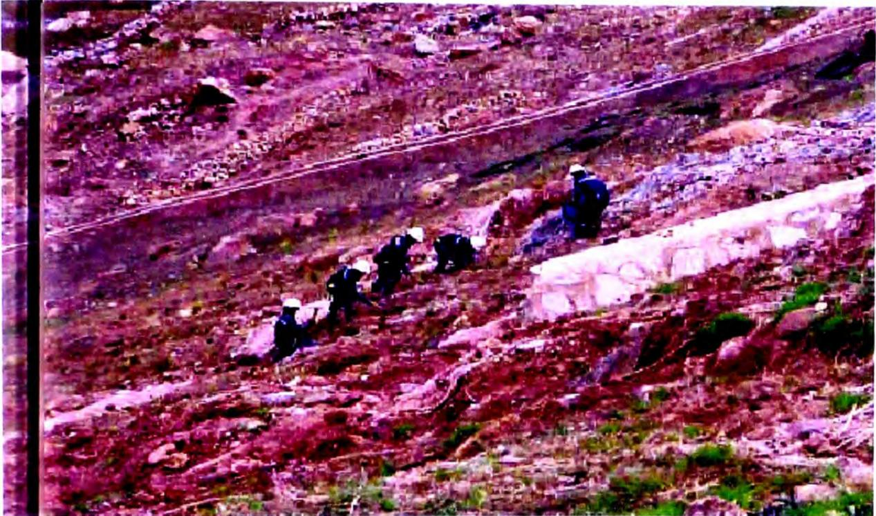
*Imagen N° 4.04: Trabajos de revegetación y plantación de Polylepis spp. con pasturas en talud de relleno*
