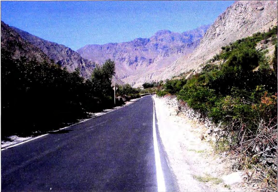
**Foto N°09: Tratamiento con Slurry Seal km 100+500 –km101+000**
