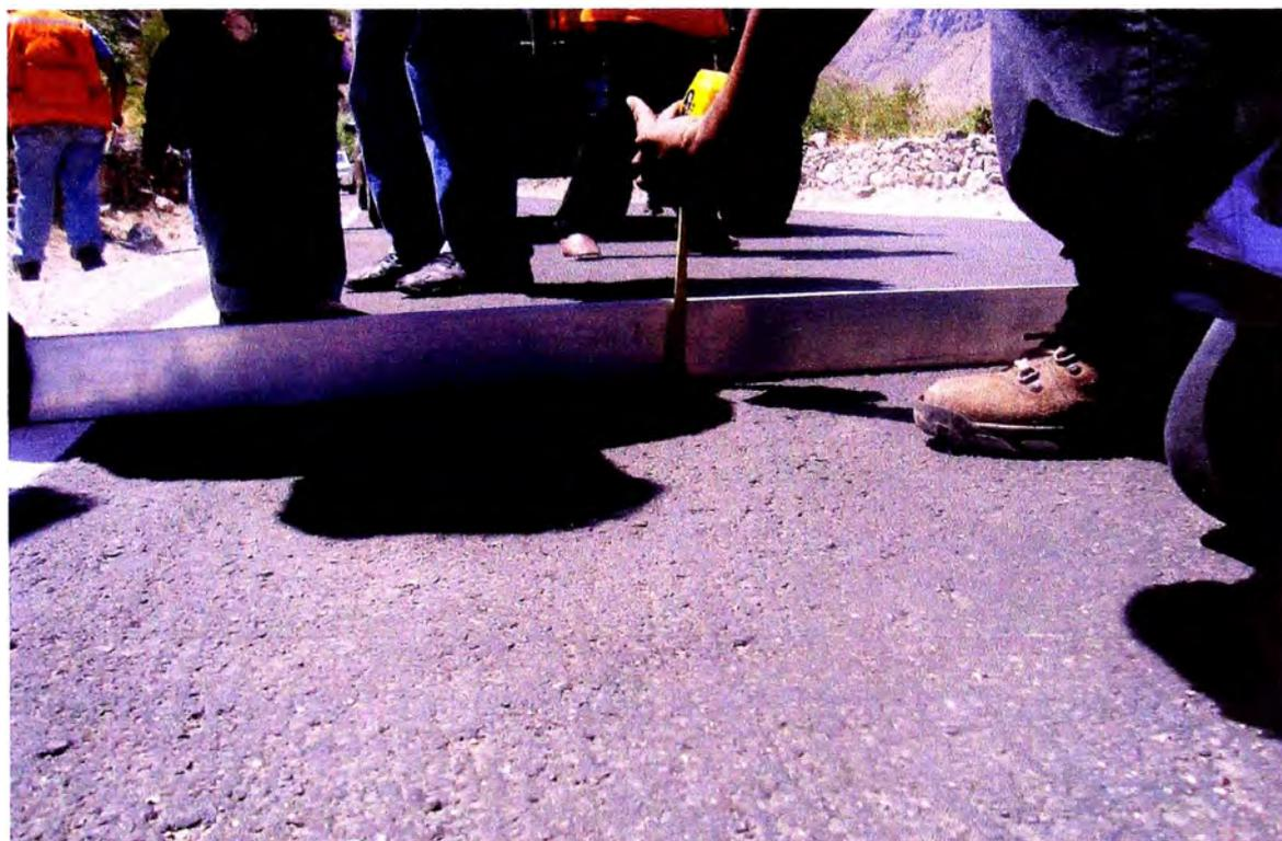
**Foto N°04: Medición del ahuellamiento**
