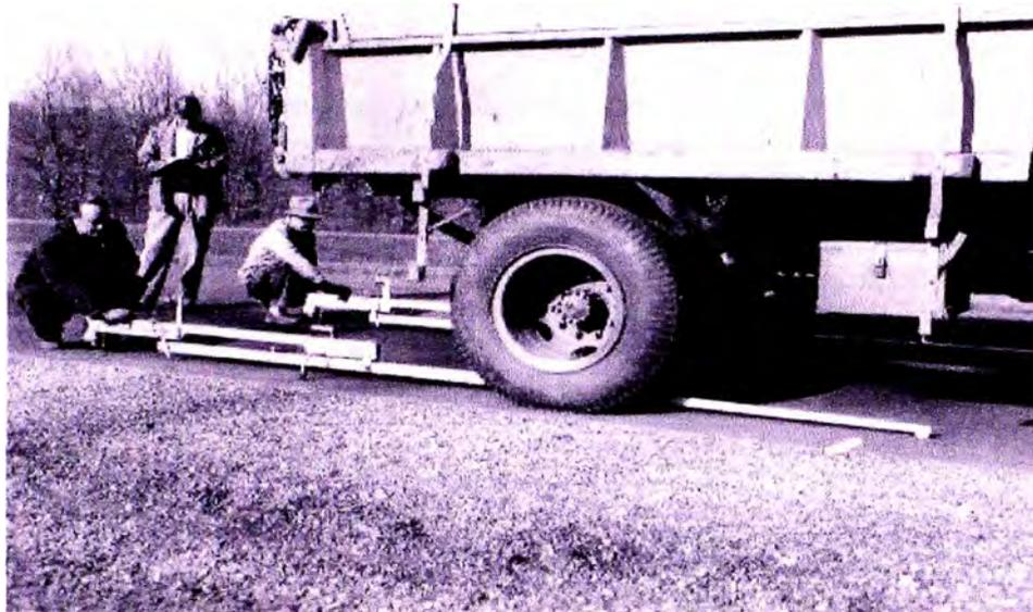
**Figura N° 2.01. Pruebas con Viga Benkelman (1952)**
