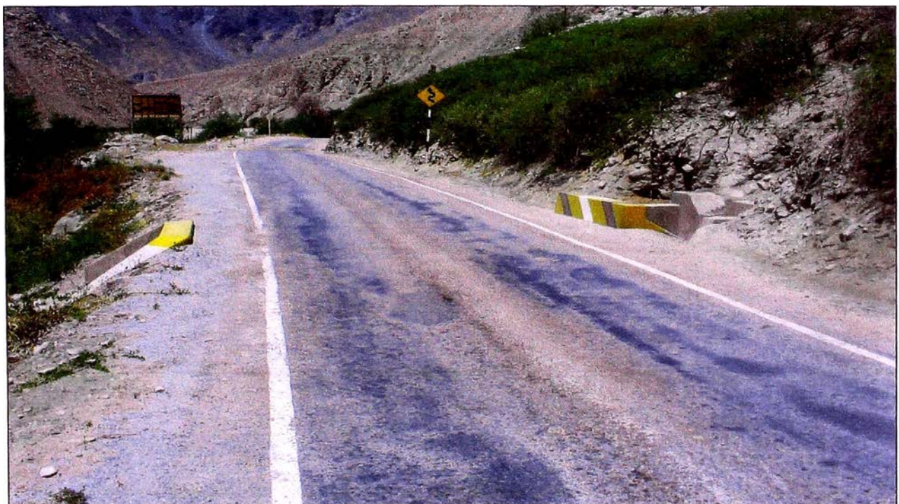
Fotografía N ° 10 Alcantarillas de concreto
