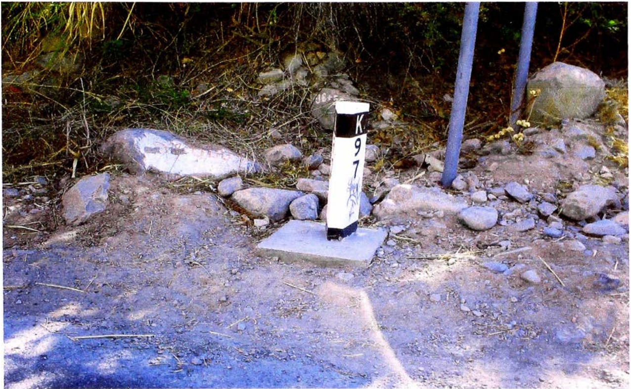
Fotografía N ° 13 Hito km. 97
