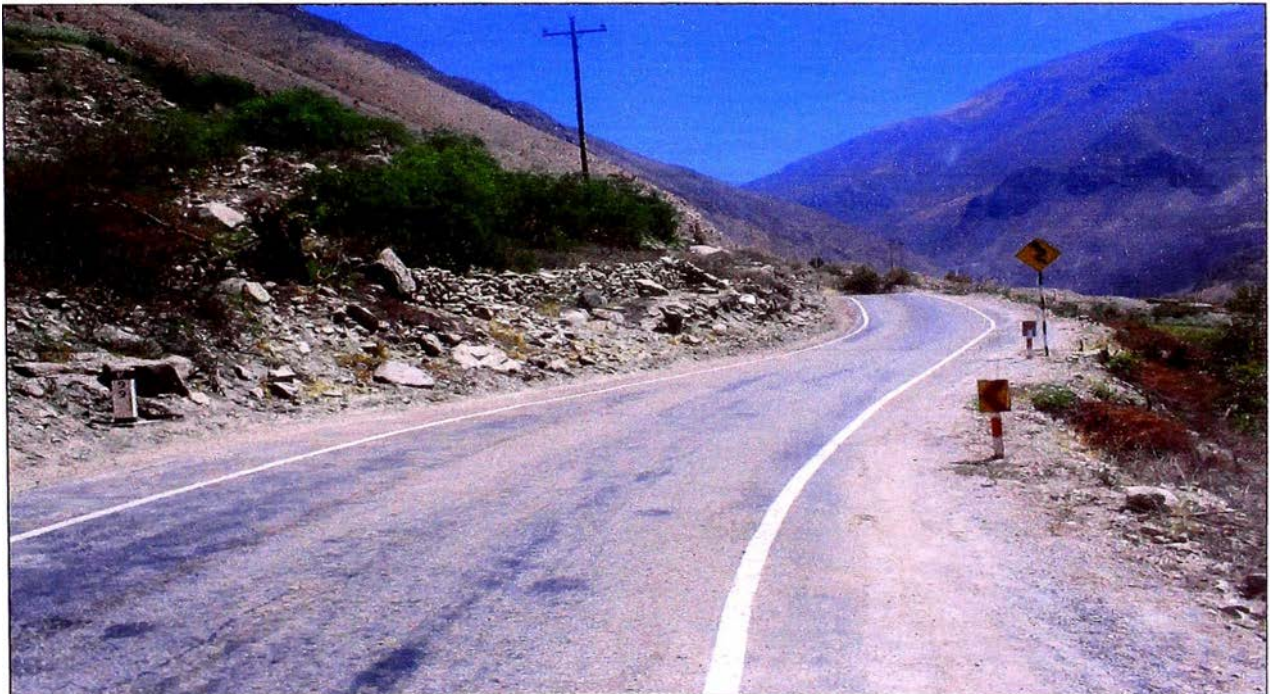
Fotografía N ° 04 Tramo con ancho de vía variable
