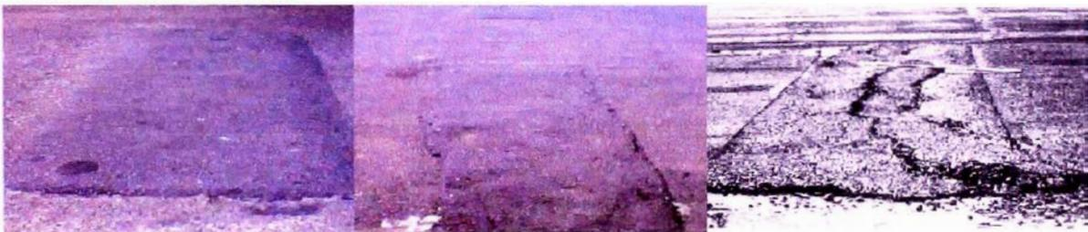
Figura N° 3-20: Niveles de severidad en Falla por hinchamiento
