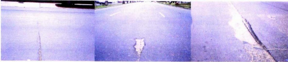
Figura N° 3-10: Niveles de severidad en Falla por Reflexión de Junta
