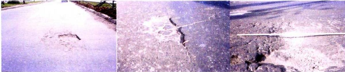
Figura N° 3-15: Niveles de severidad en Falla por Huecos
