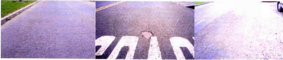
Figura N° 3-14: Niveles de severidad en Falla por Pulimiento de Agregados
