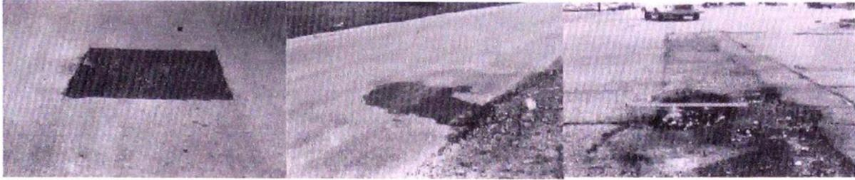
Figura N° 3-13: Niveles de severidad en Falla por Parcheo
