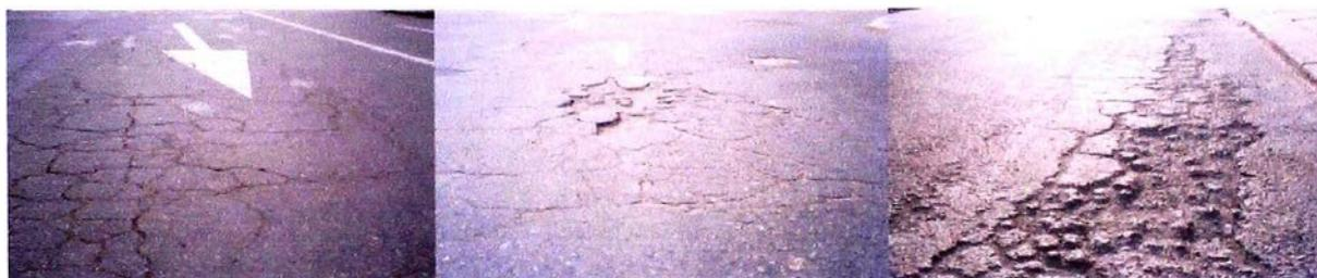
Figura N° 3-03: Niveles de severidad en Falla de Piel de Cocodrilo
