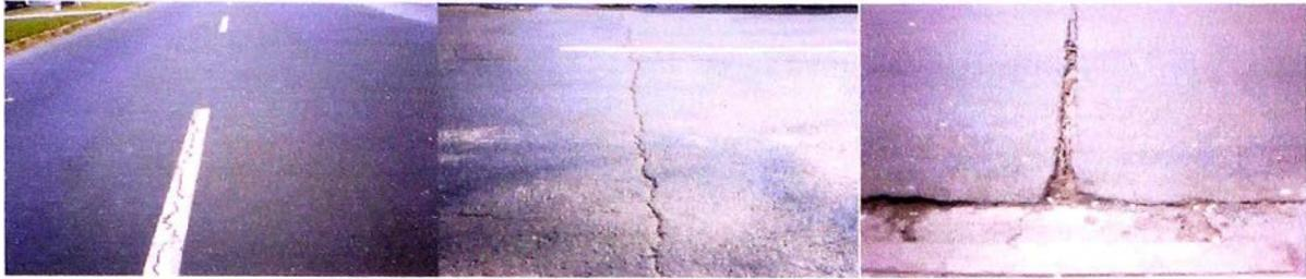
**Figura N° 3-12:** Niveles de severidad en Falla por Grietas Longitudinales y Transversales
