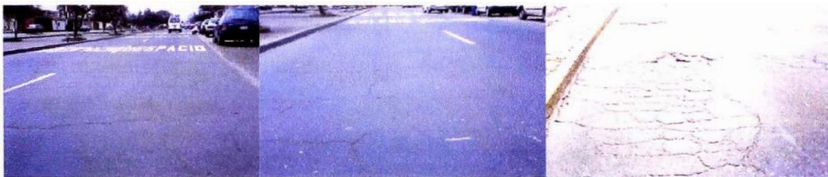
Figura N° 3-05: Niveles de severidad en Falla por Agrietamiento en Bloque
