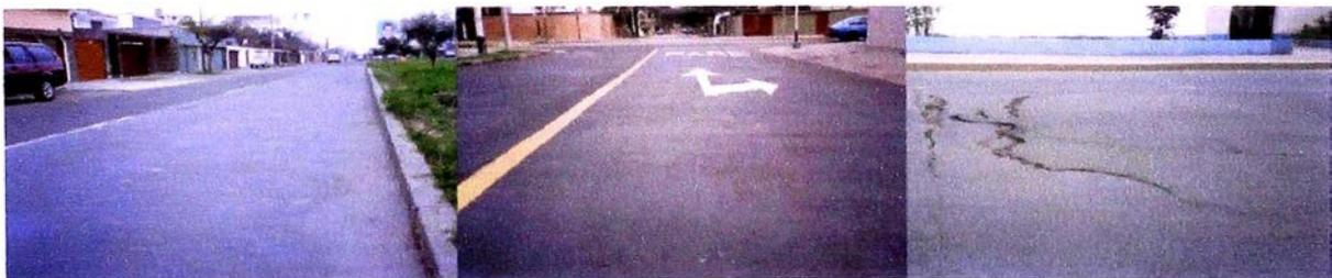
Figura N° 3-18: Niveles de severidad en Falla por Desplazamiento
