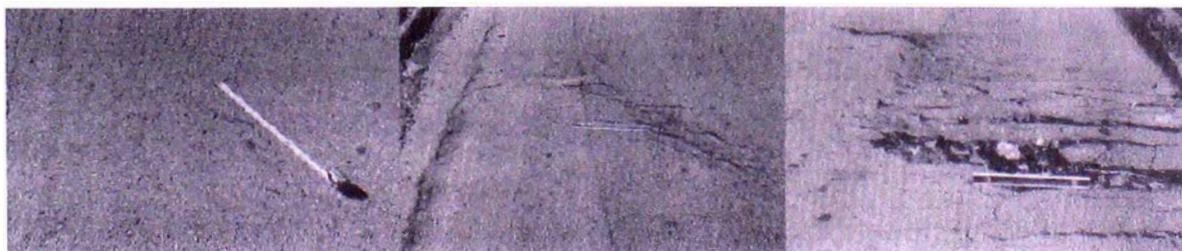
Figura N° 3-19: Niveles de severidad en Falla por Deslizamiento
