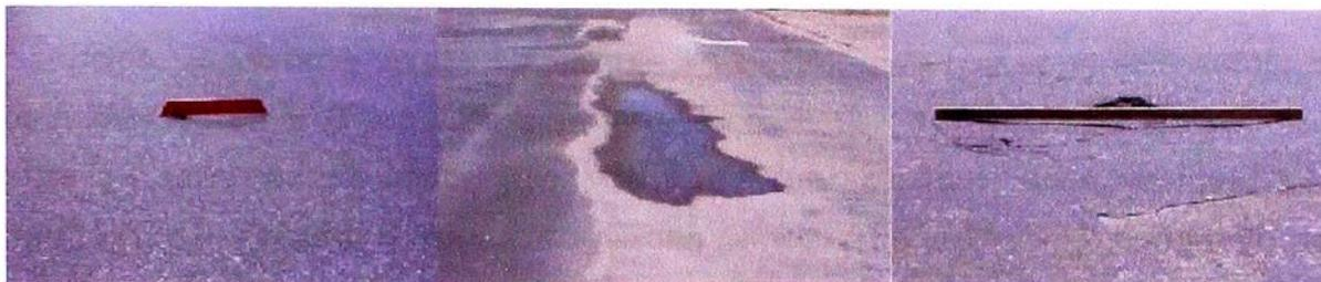
**Figura N° 3-08:** Niveles de severidad en Falla por Depresión
