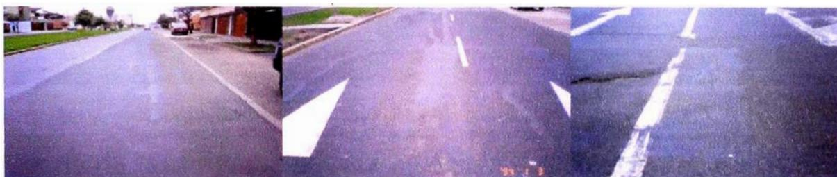
Figura N° 3-04: Niveles de severidad en Falla por Exudación
