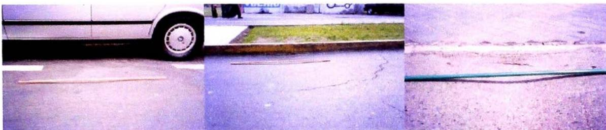
Figura N° 3-06: Niveles de severidad en Falla por Elevaciones y Hundimientos
