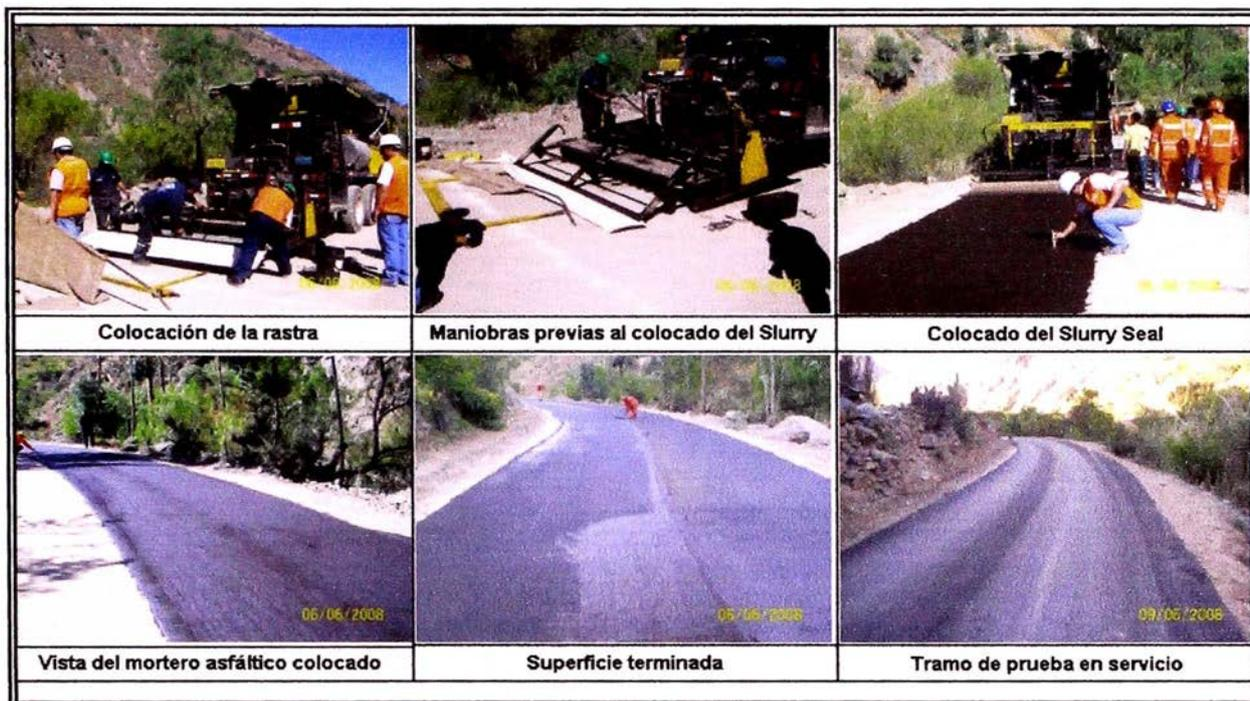
**Figura N° 1-05: Aplicaciones del Slurry Seal**
