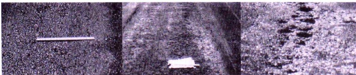
Figura N° 3-21: Niveles de severidad en Falla por Disgregación y Desintegración de Agregados
