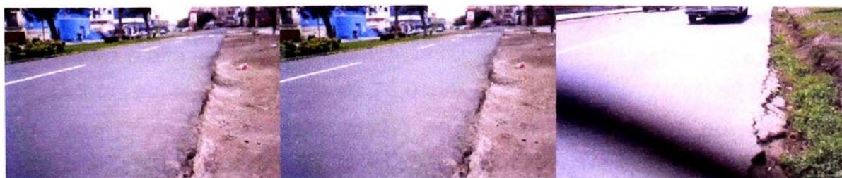
**Figura N° 3-09:** Niveles de severidad en Falla por Grieta de Borde
