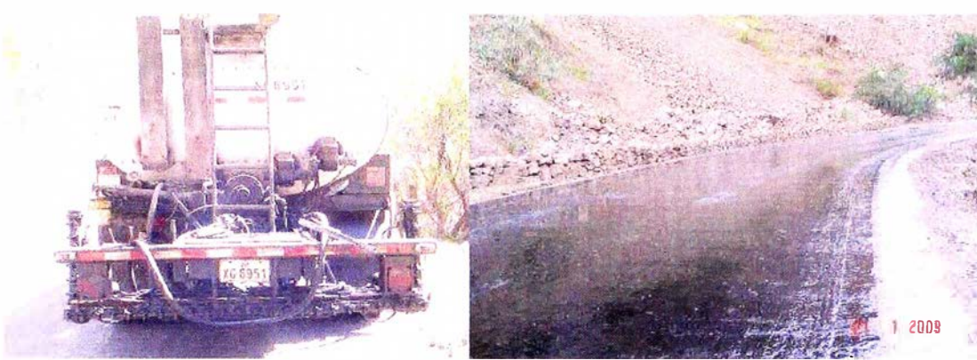
Fotografía 4.- Riego de RC-250 sobre la superficie estabilizada
