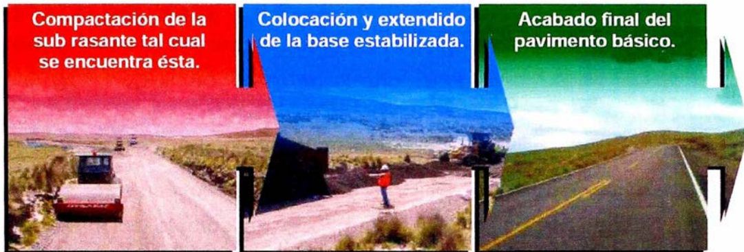
Figura N° 1.10: Proceso de ejecución de pavimentos básicos
