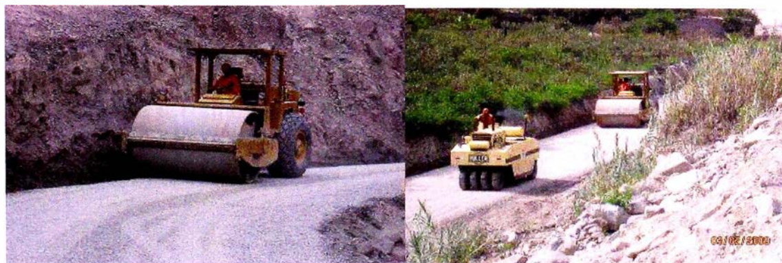
Fotografía 6.- Trabajos de compactado
