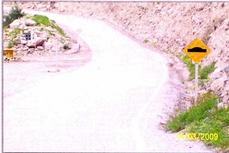
Fotografía 7.- Trabajo terminado a la fecha de marzo del 2009 Fuente: Supervisión Proyecto Perú, panel fotográfico Marzo 2009
