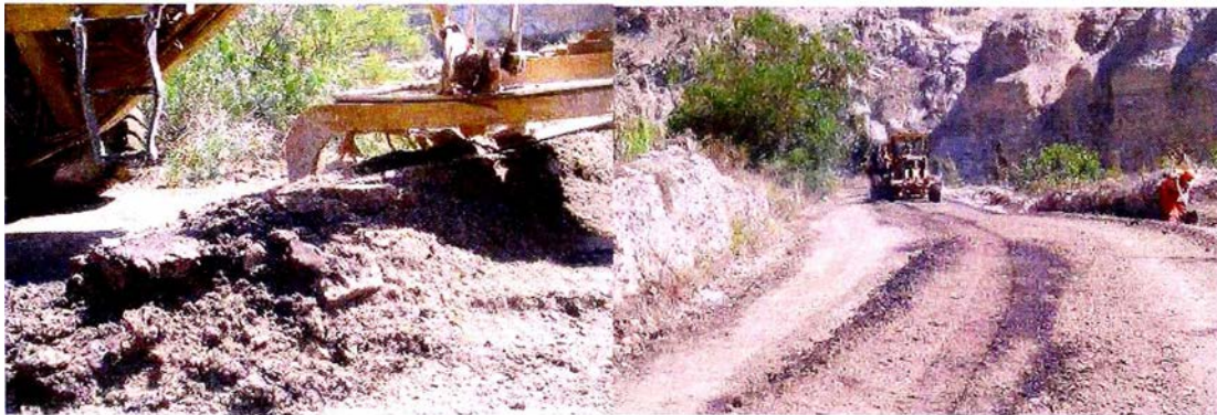
Fotografía 2.- Estabilización de afirmado Km. 94+000
