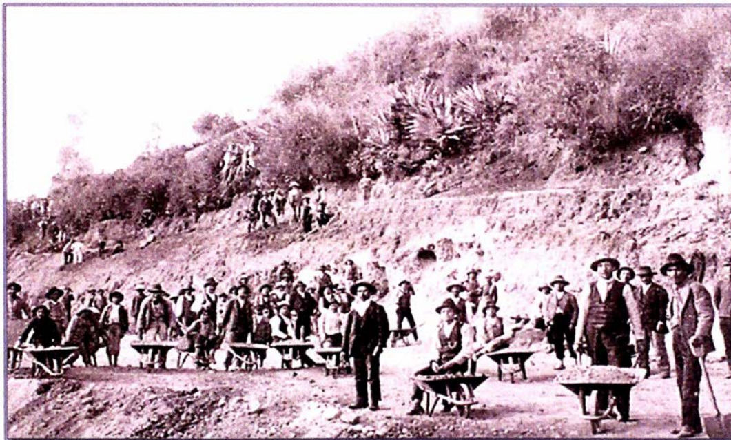
Figura N° 1.01: Trabajos durante la Ley de Conscripción Vial
