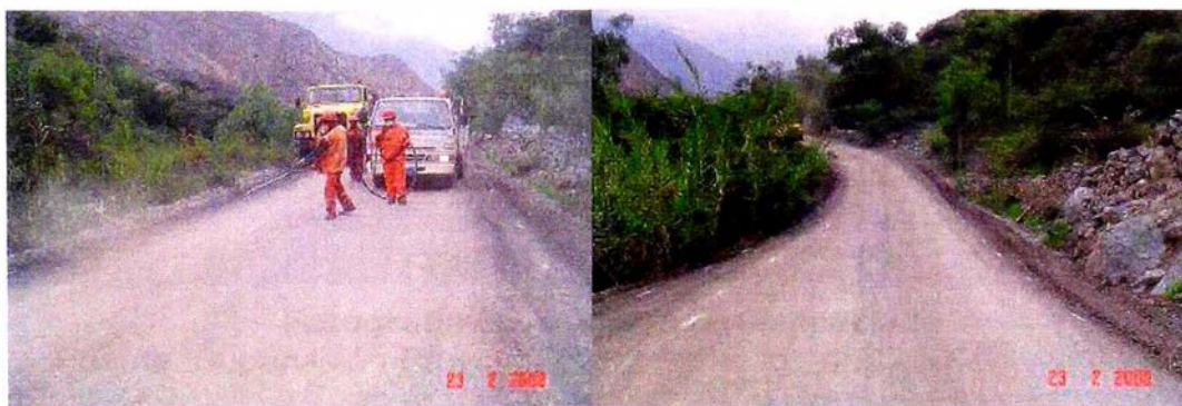
Fotografía 3.- Limpieza de superficie estabilizada Km. 90+000
