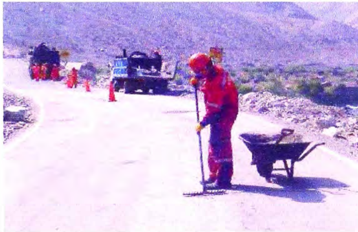
Fotografía 5.1 Trabajo de parchado superficial, km 71+000
