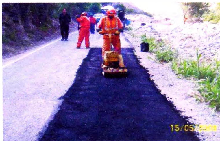
Fotografía 5.2 Trabajo de parchado profundo, km 88+700
