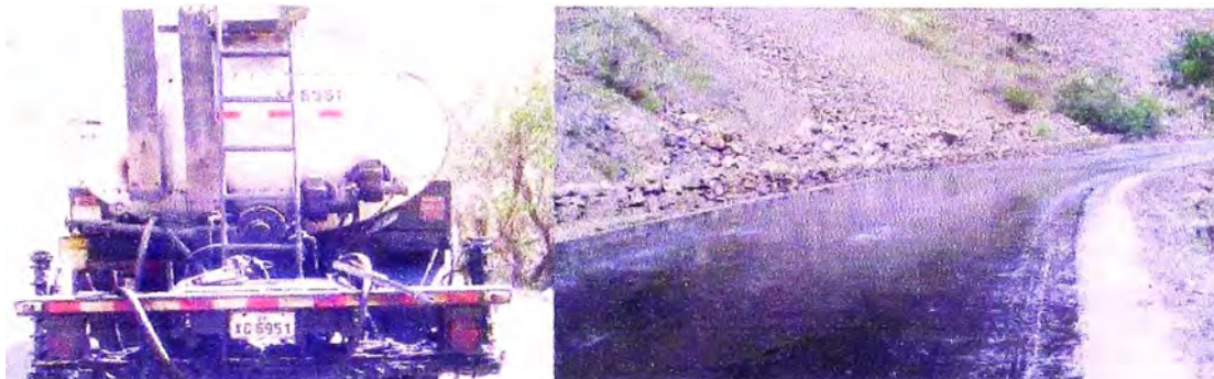
Fotografía 1.4 Riego de RC-250 sobre la superficie estabilizada
