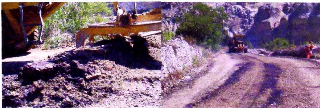
Fotografía 1.2 Estabilización de afirmado Km. 94+000
