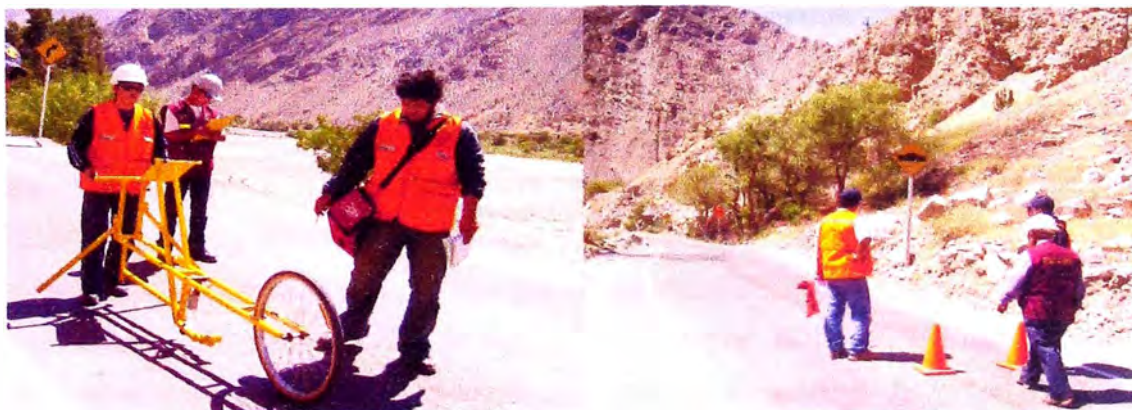
Fotografía 4.5 Obtención de datos y medidas de seguridad adoptadas Fuente: Visita de campo al tramo de prueba, 2 de octubre del 2009
