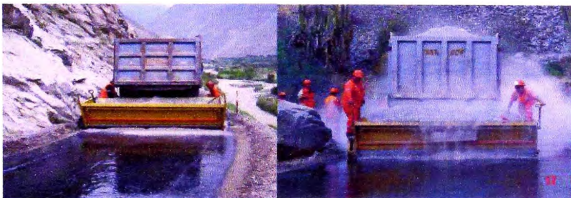
Fotografía 1.5 Esparcido de gravilla sobre el RC-250
