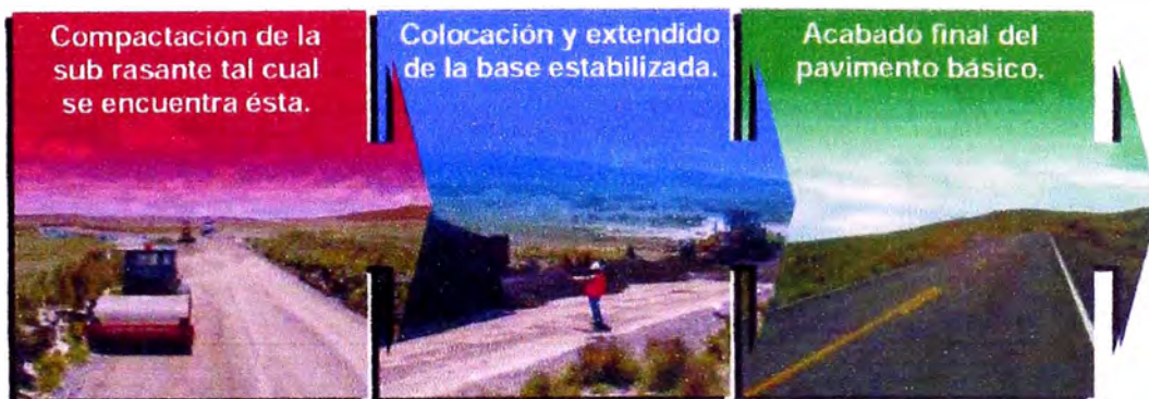
Figura 1.11 Proceso de ejecución de pavimentos básicos
