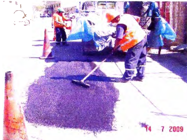
Fotografía 5.3 Trabajo de parchado superficial, km 83+000 Fuente: Supervisión Proyecto Perú, panel fotográfico julio de 2009
