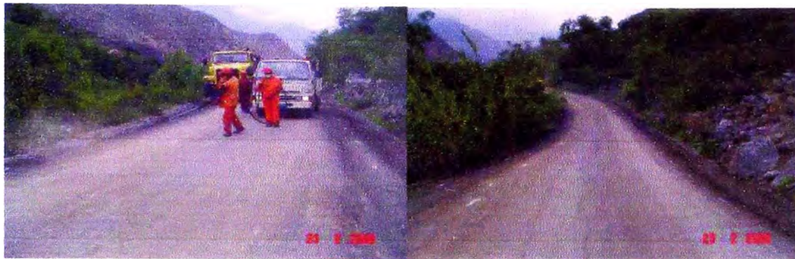
Fotografía 1.3 Limpieza de superficie estabilizada Km. 90+000
