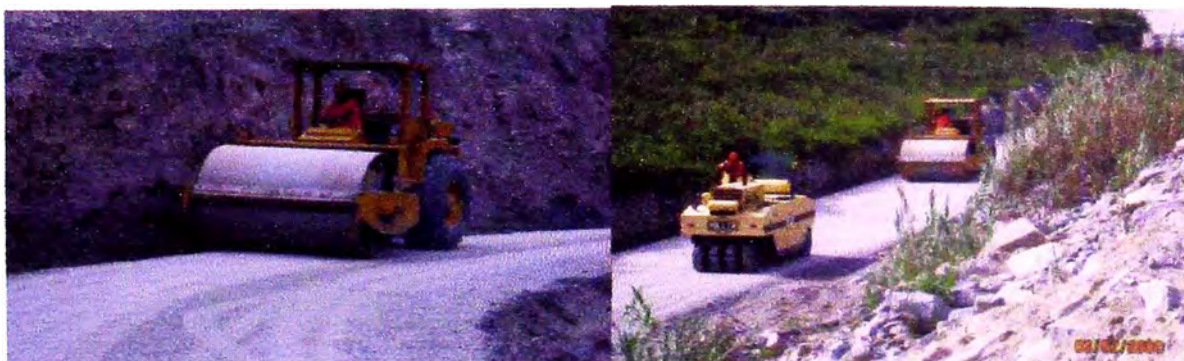
Fotografía 1.6 Trabajos de compactado
