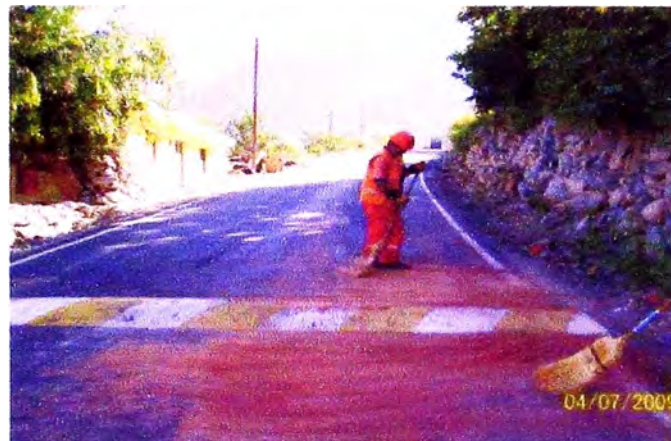
Fotografía 5.4 Limpieza de calzada, km 78+400 Fuente: Supervisión Proyecto Perú, panel fotográfico julio de 2009
