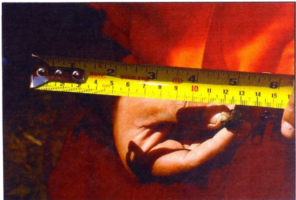
Foto 8: Medición del espesor de la carpeta de rodadura en el punto de ensayo, con wincha.
