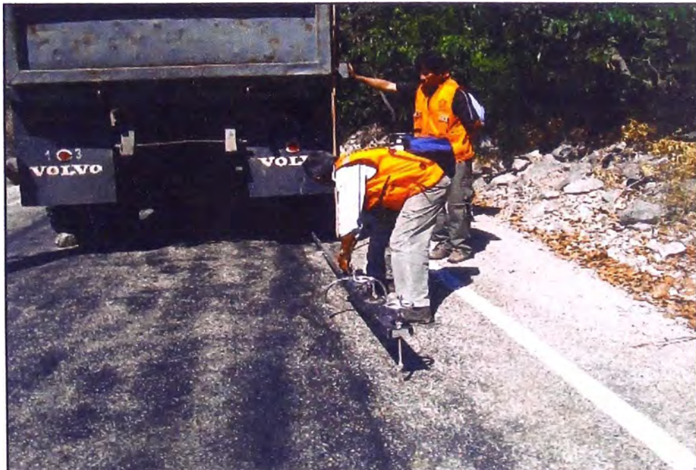
Foto 2: Preparación de la Viga Benkelman en el punto de ensayo para realizar las mediciones.
