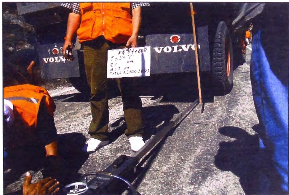
Foto 4: Proceso de medición de lecturas en el dial de deformación, en el Km. 84+800 de la carretera en estudio.
