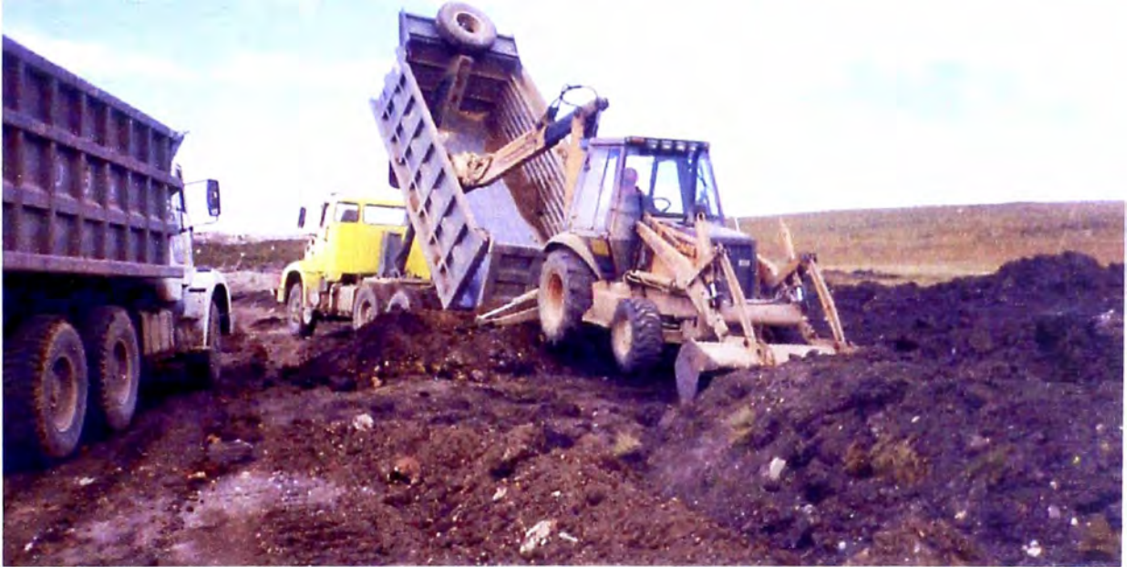
Limpieza de tolva de volquete con carga retroexcavadora en botadero de top oil
