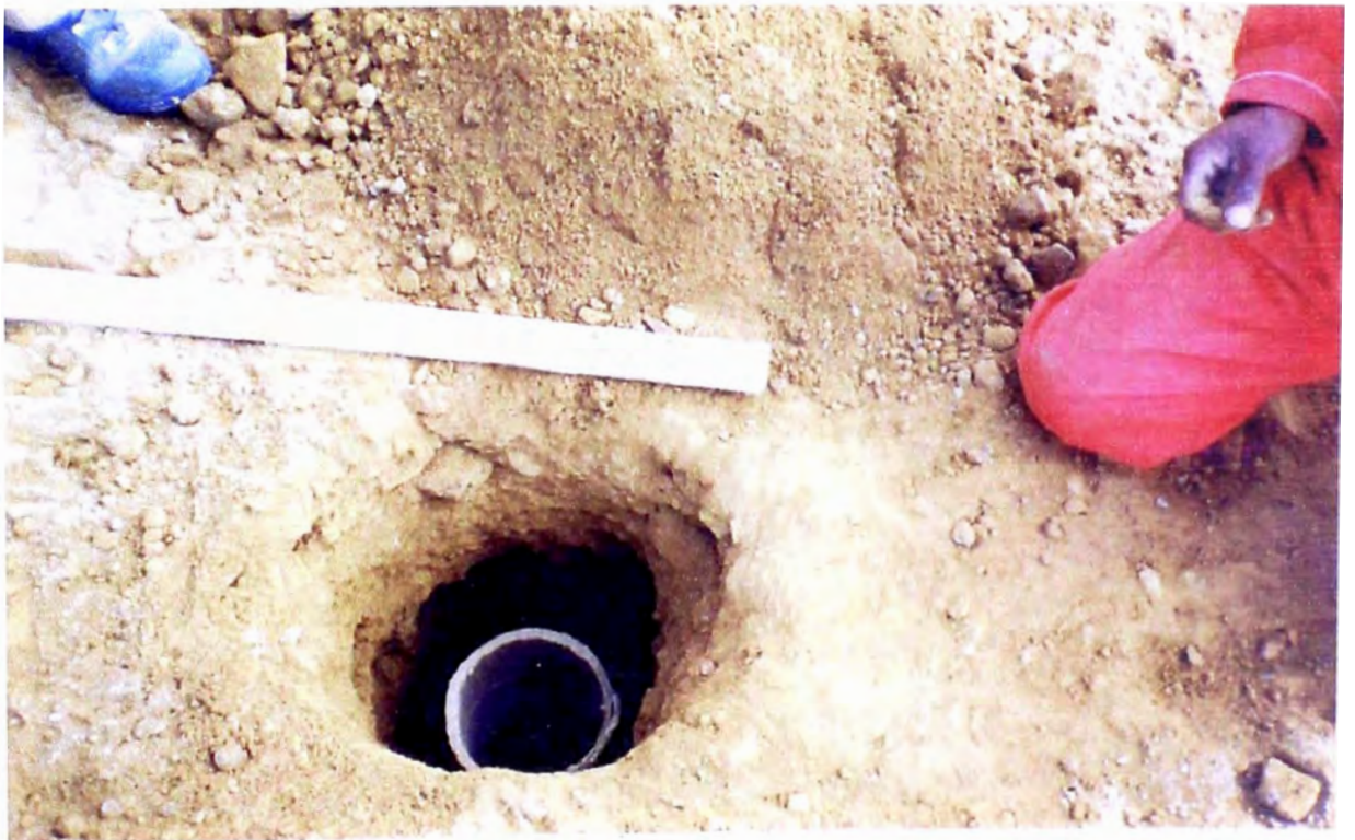
Comprobación de la altura de PDL colocado
