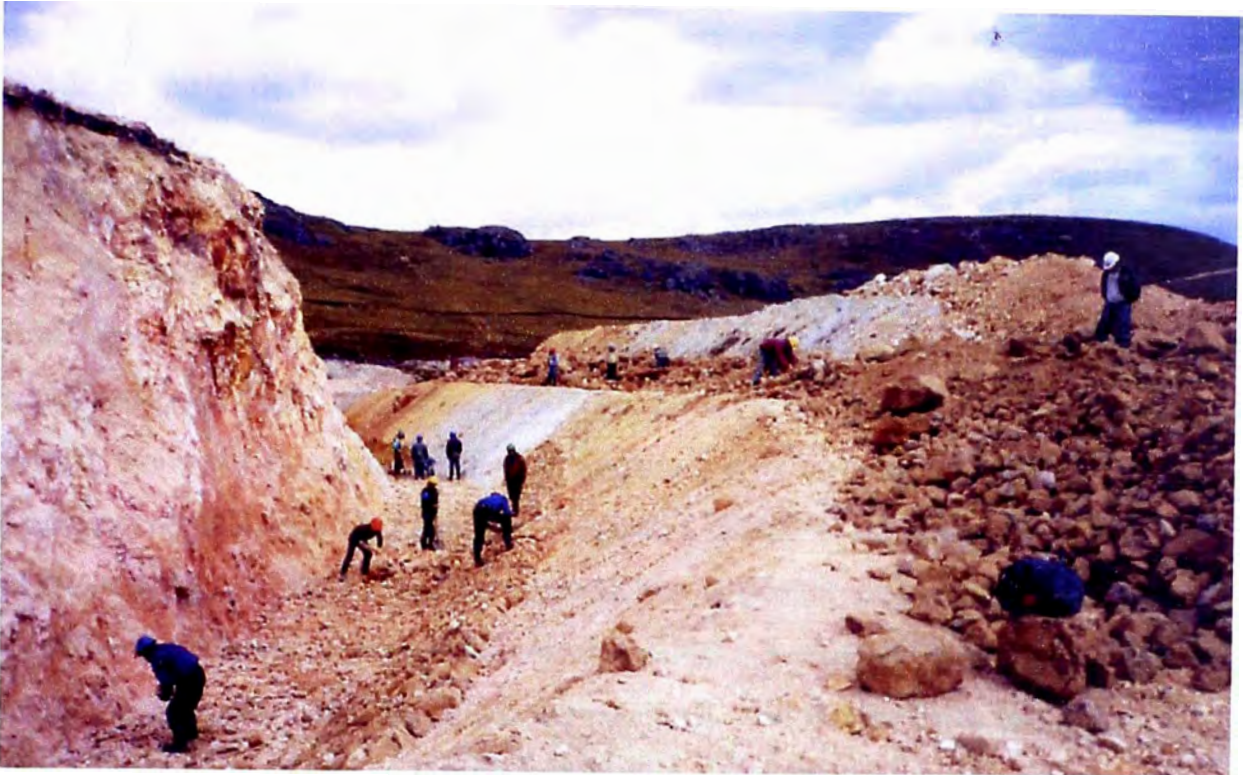
Figura 3.1.15-1.- Colocación de rip rap en canal
