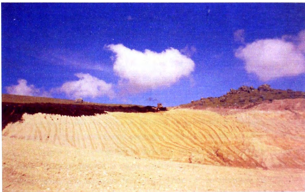
Figura 3.1.1-2.- Tractor cortando top soil en Maqui Maqui
