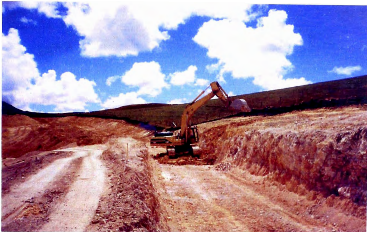
Figura 3.1.14-1.- Excavación de caja de canal Este de Maqui Maqui
