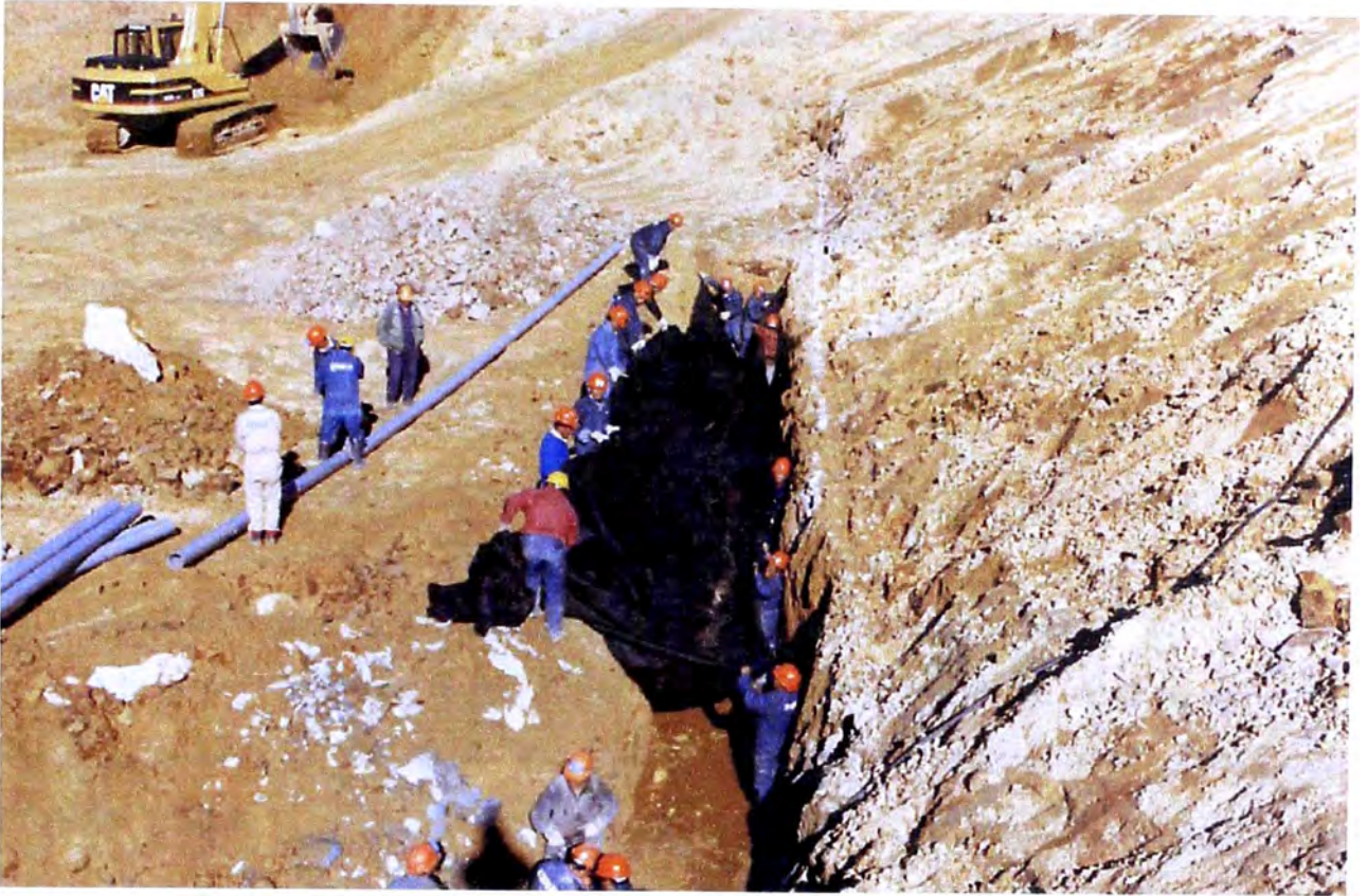
Figura 3.1.5-2.- Colocación de geotextil en underdrain
