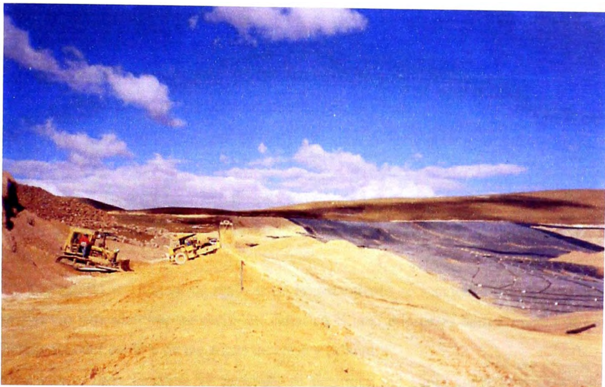
Figura 3.1.12-1.- Construcción de berma en Maqui Maqui 2
