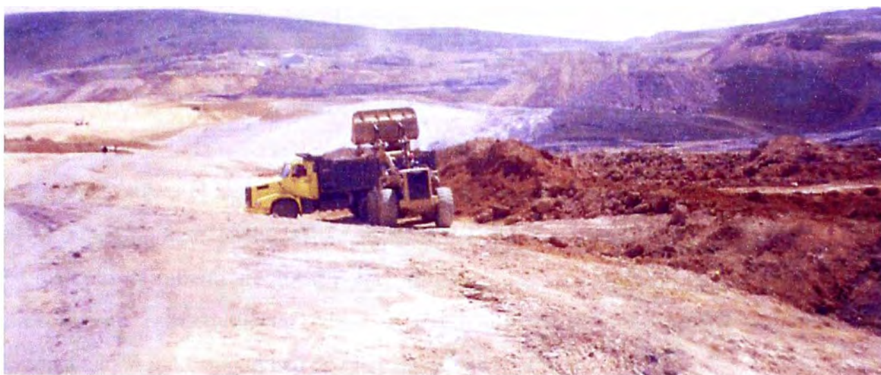
Figura 3.1.4-2.- Carguío de material para relleno producto de corte de terreno para nivelación de pad
