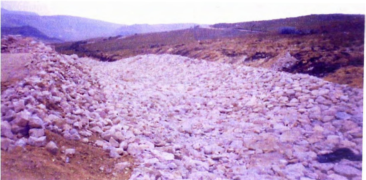
Figura 3.1.15-2.- Rip rap colocado en canal
