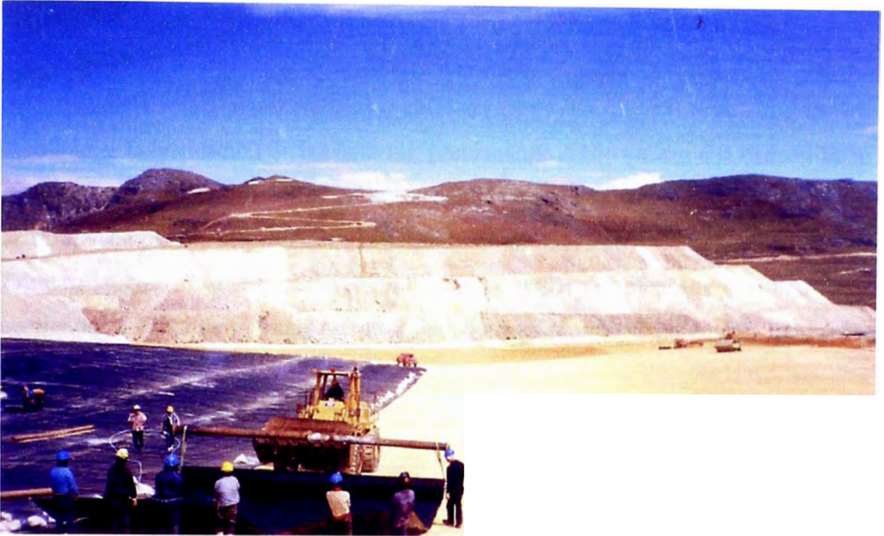
Figura 3.1.8-5.- Colocación de liner con ayuda de cargador frontal y obreros
