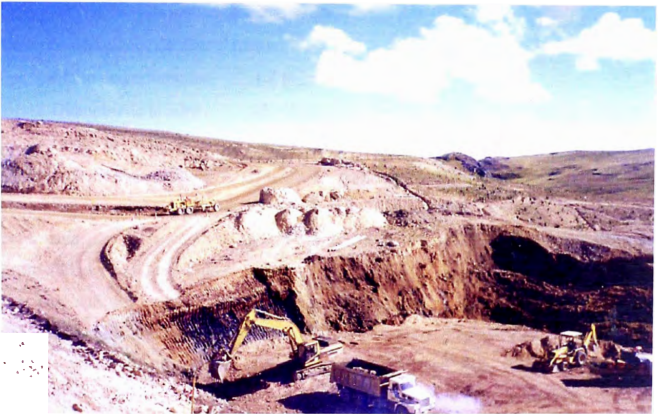
Figura 3.1.3-1.- Relleno compactado en zona de peat
