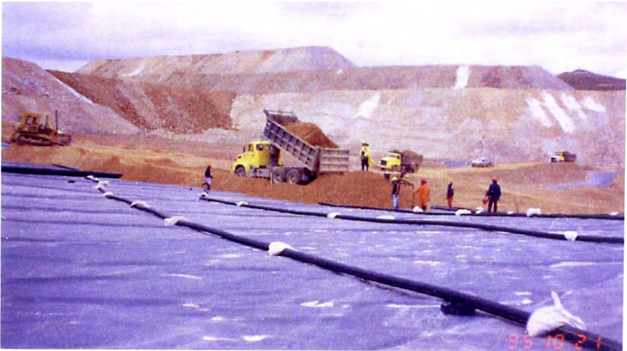
Figura 3.1.10-3.- Construcción de acceso con PDI, para su colocación sobre el pad
