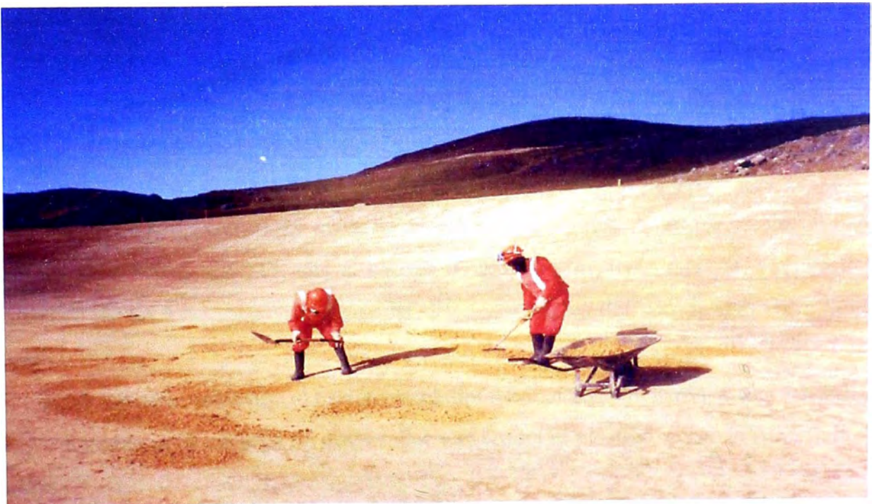
Figura 3.1.6-2.- Resane de superficie de soil liner
