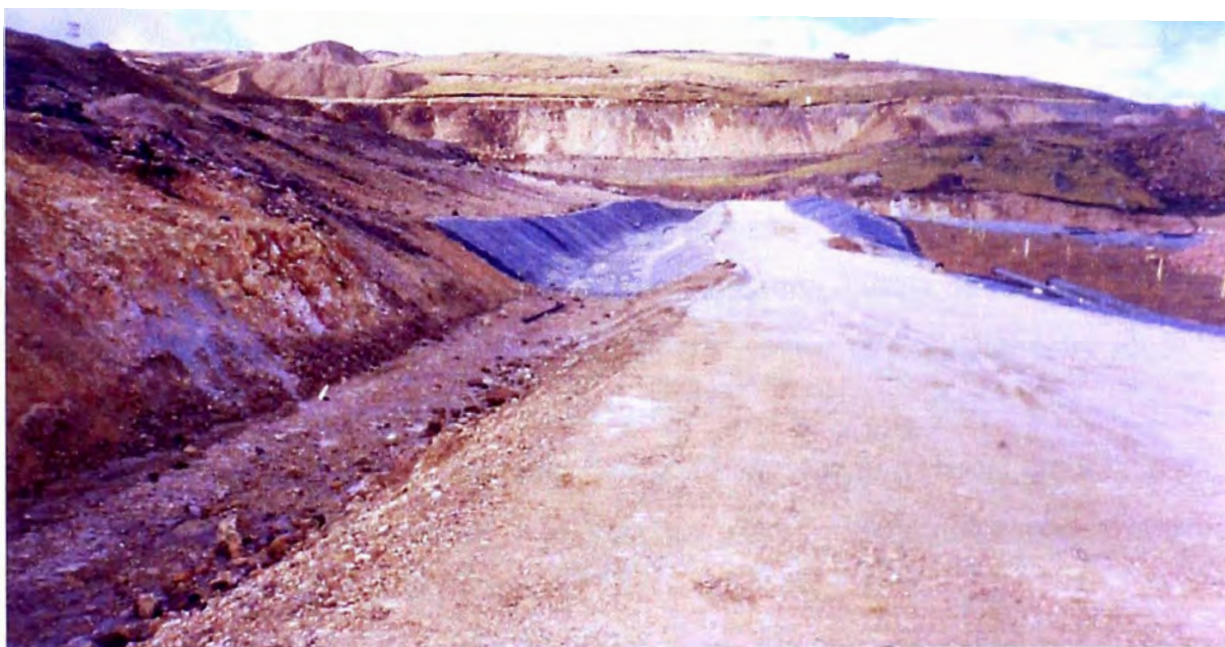
Figura 3.1.14-2 - Vista del canal oeste de Maqui Maqui con parte de suelo duro (roca) y blando (cubierto con liner)
