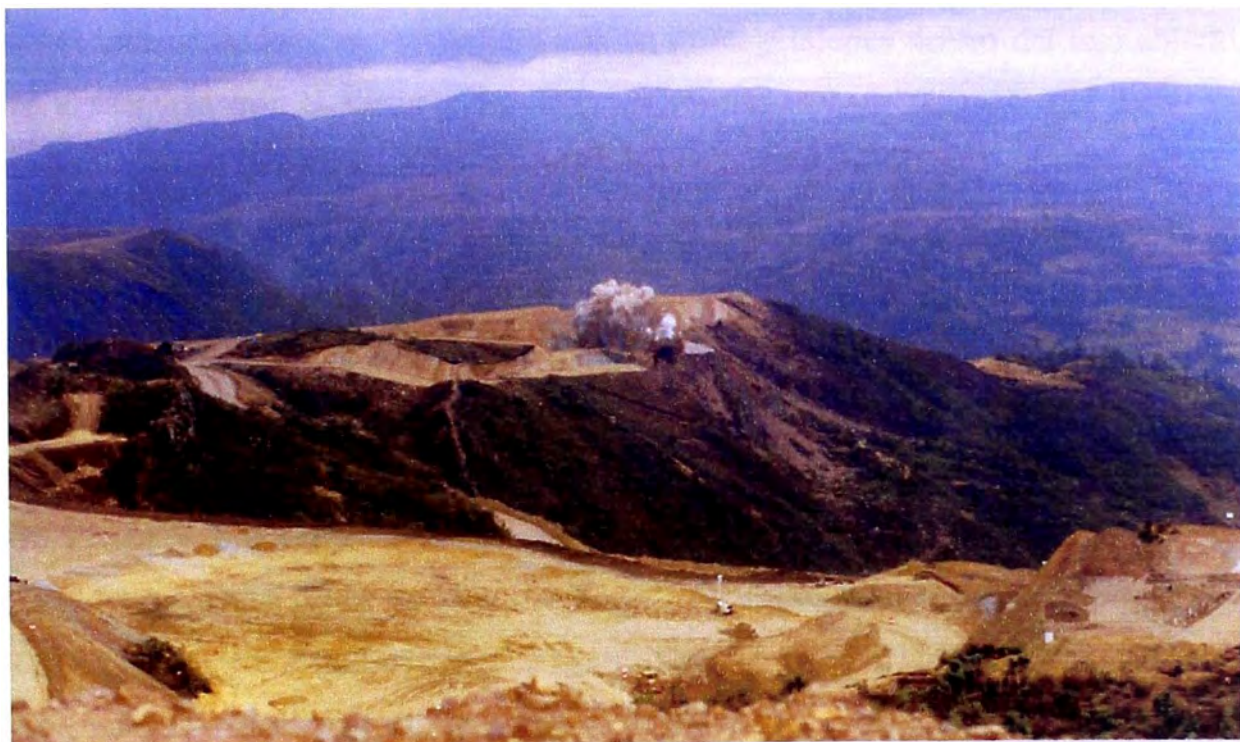
Figura 3.2.2-1 y 2.- secuencia de voladura primaria en cerro Ojos
