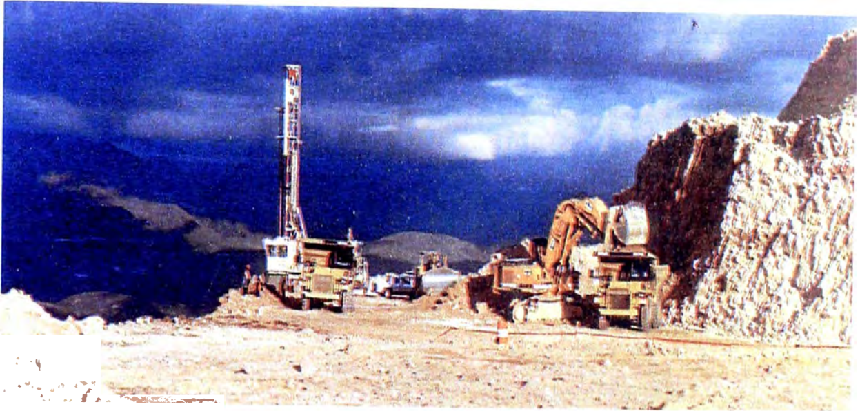
Figura 3.2.1-1.- Vista de Perforación y carguío
