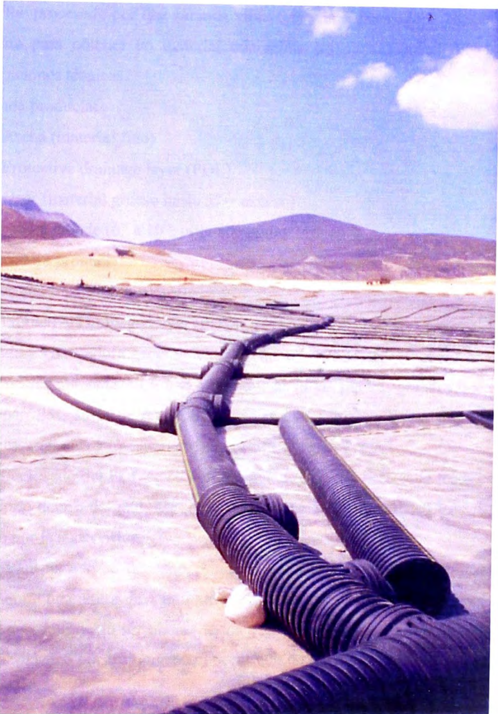
Figura 3.1.9.-2.- Detalle de conexión de tuberías
