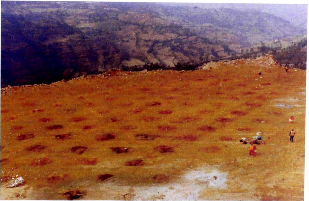
Figura 3.2.1-2.- Vista de malla perforada
