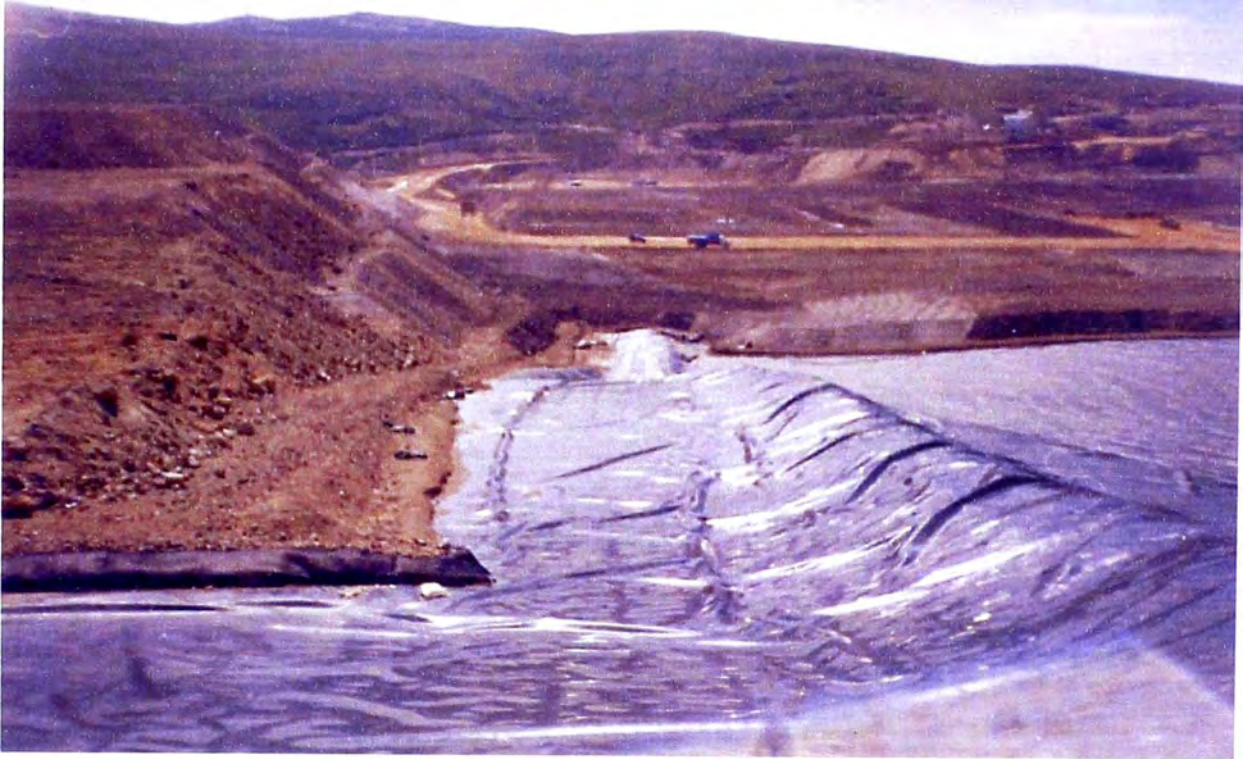
Figura 3.1.11-1.- Vista del tie in entre Maqui Maqui 1 y 2
