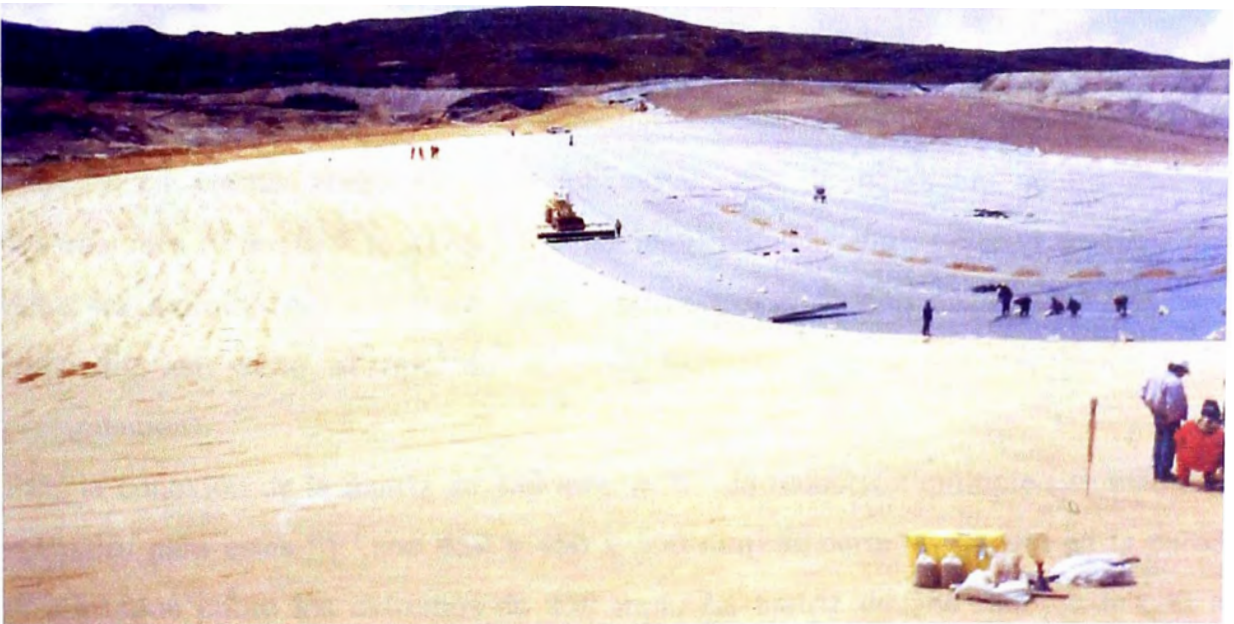
Figura 3.1.8-6.- Colocación de liner
