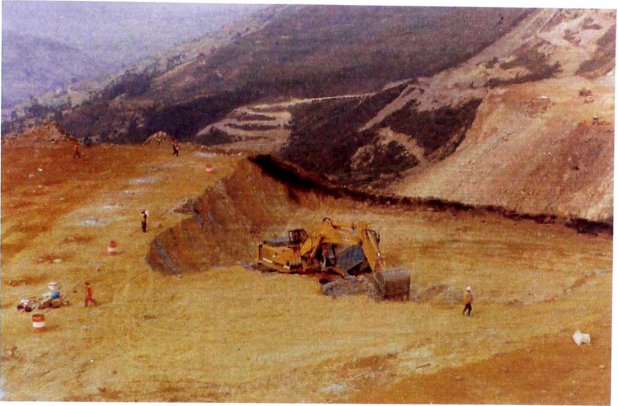
Figura 3.2.4-2.- Excavación con excavadora Liebherr 964, al costado se puede ver malla perforada
