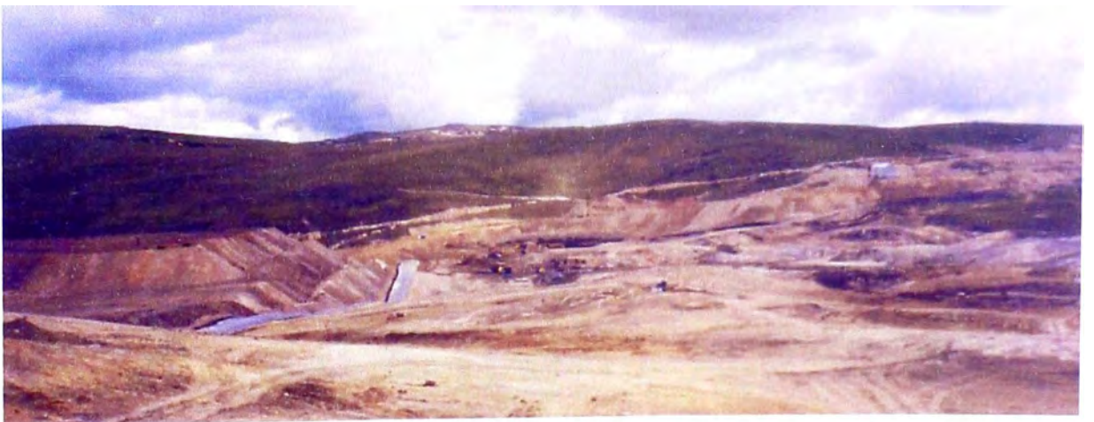
Vista del Pad de Maqui Maqui después de habersele retirado la capa de top soil
