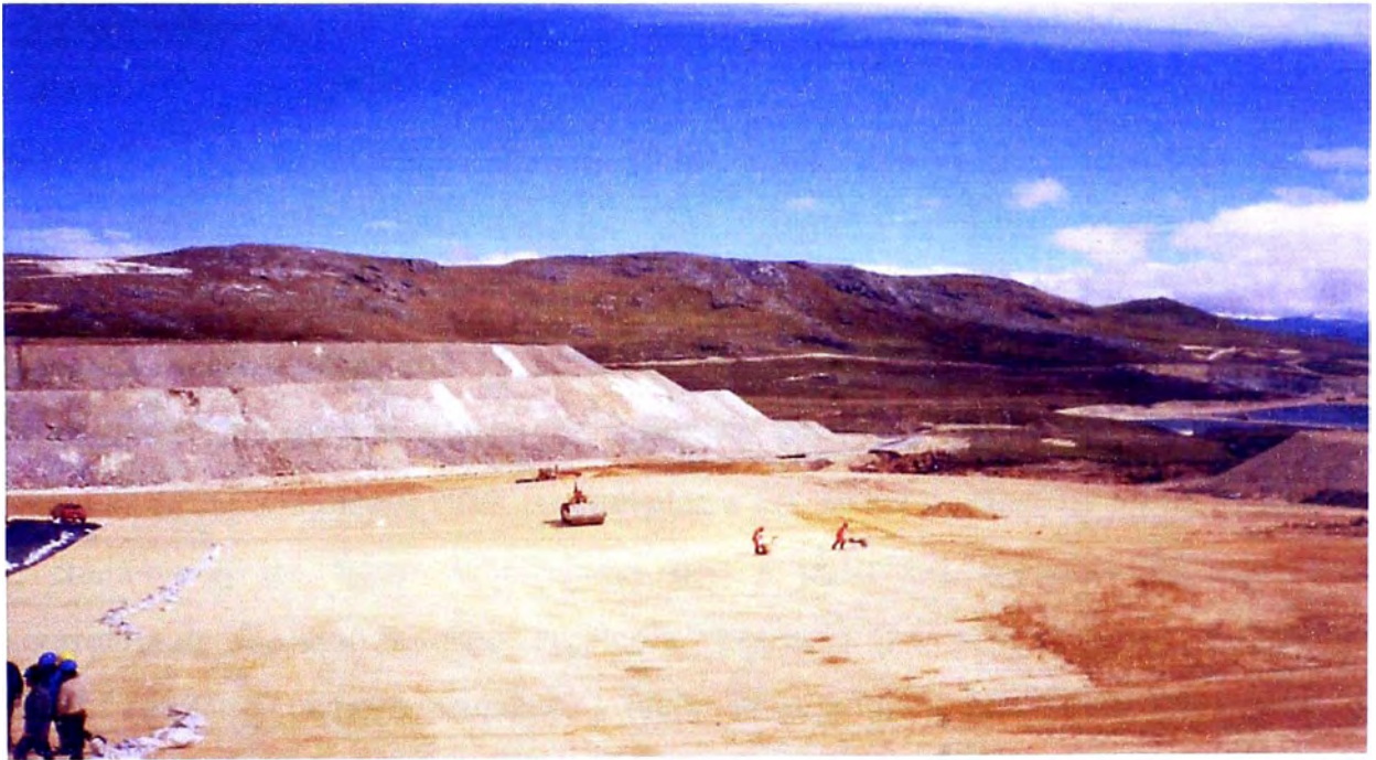
Figura 3.1.6-1.- Compactación de soil liner
