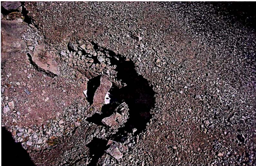
Km 84+620 Alcantarilla Artesanal
