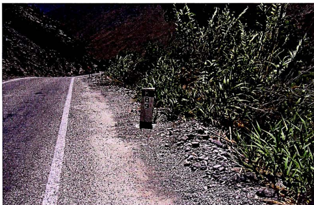
Km 89+00 Fin de tramo en buen estado
