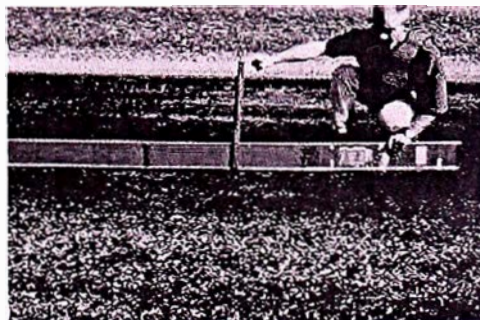
Fig. N°18 Corrugaciones severidad Alta
