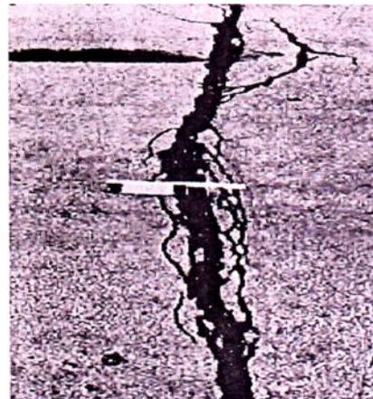
Fig. N°23 Grieta de reflexión de junta severidad media y alta
