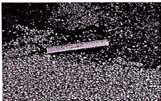
Fig. N°31 Hueco de severidad baja y severidad media
