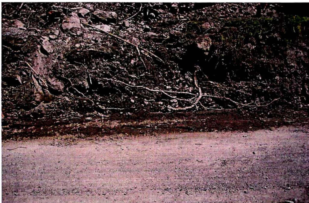
Km 86+200 Derrumbe por colapso de canal de regadío
