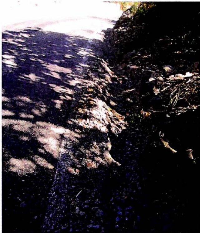
Km 84+600 Cuneta de tierra utilizado como canal de regadío
