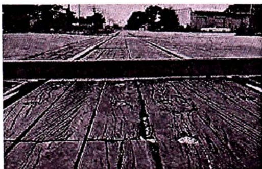
Fig. N°33 Acceso y salidas a líneas férreas severidad baja y severidad media
