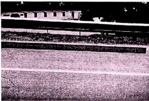
Fig. N°13 Corrugaciones severidad baja
