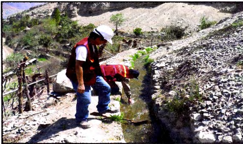
FOTO 5: Ubicación de la fuente de agua canal en el Km 78+300
