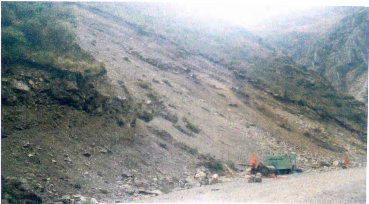
FOTO 12: Se aprecia el deslizamiento de materiales que irrumpen la plataforma del camino.
