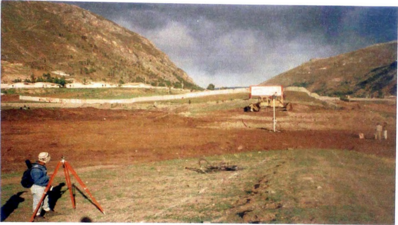
FOTO 3: Se observa el control topográfico en la etapa constructiva.
