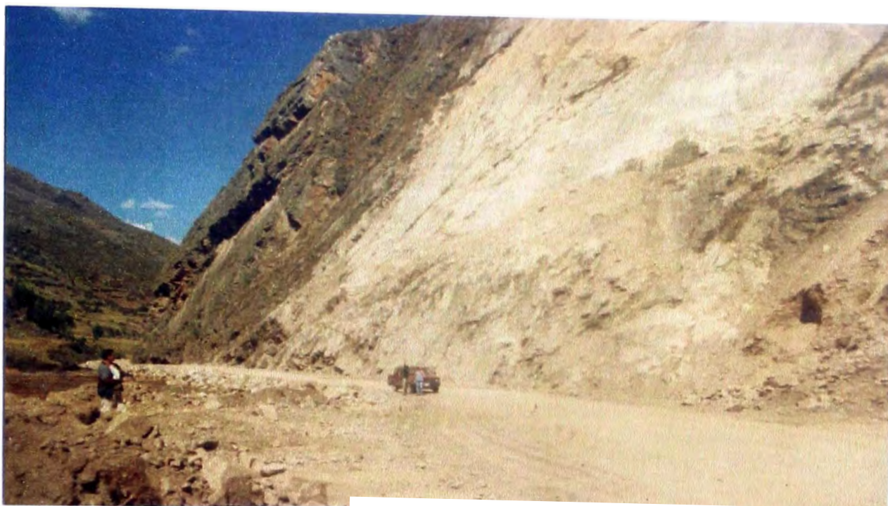
FOTO 13: En la vista se aprecia el desprendimiento de continuo de grandes bloques de rocas.
