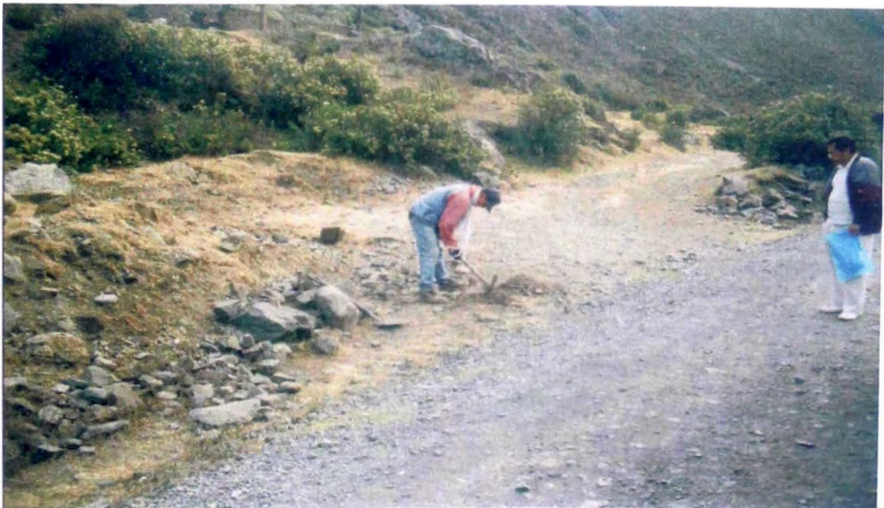
FOTO 4: Se observa el muestreo del terreno con la ejecución de calicatas.
