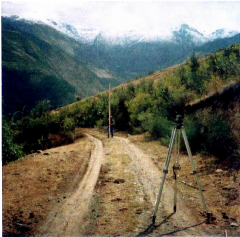
FOTO 1: Se aprecia el estacado del eje.
