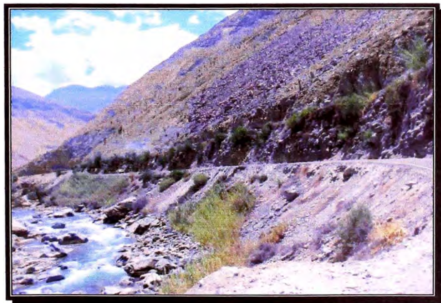
Carretera Media Ladera
