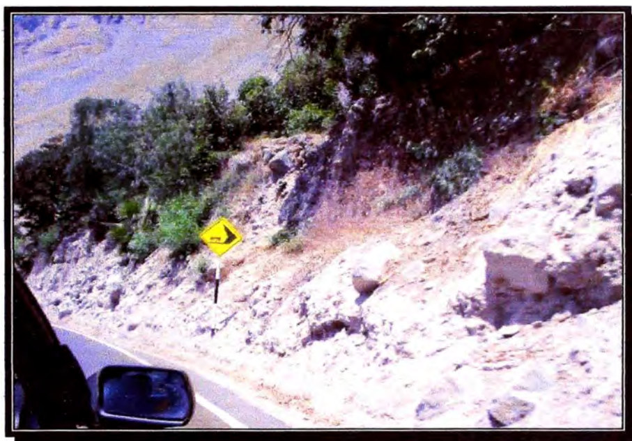
Señal indicando zona de derrumbes
