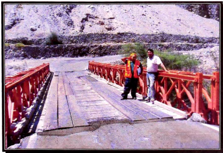
Vista de Puente de madera dentro del tramo
