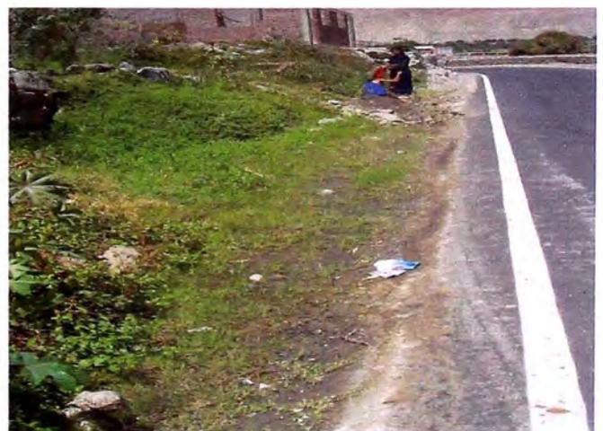
Foto N° 17: Km 67+000 al Km 67+270 Necesidad de 05 alcantarillas de D=12", tajeas, para derrame agua de terrenos de cultivo.
