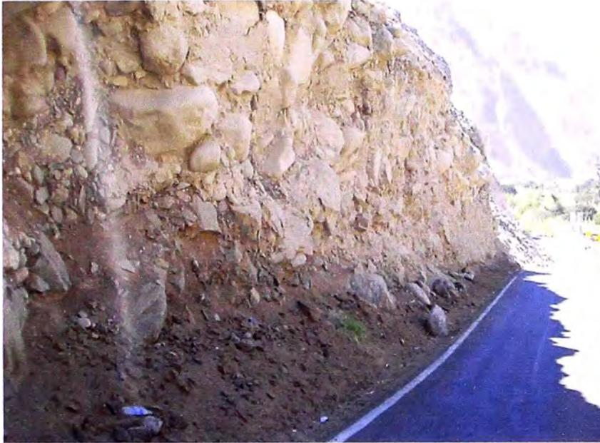
Foto N° 36: KM 68+100: Depósitos aluviales cortados casi verticalmente con presencia de filtraciones, debido a un canal en la parte superior. Se aprecia las banquetas, con la cual se reduce el potencial de derrumbe.
