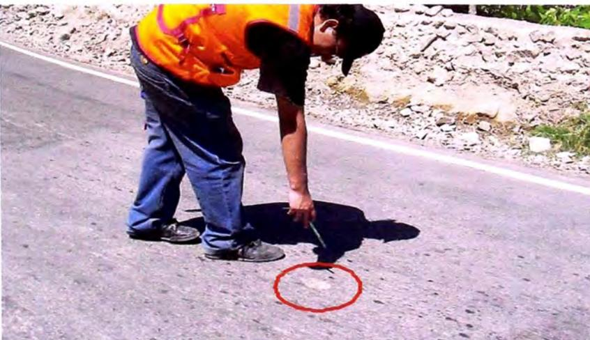
Foto N° 21: Km 66+900 se encuentra deterioro en el pavimento, debido a que hay un hueco en el slurry,
