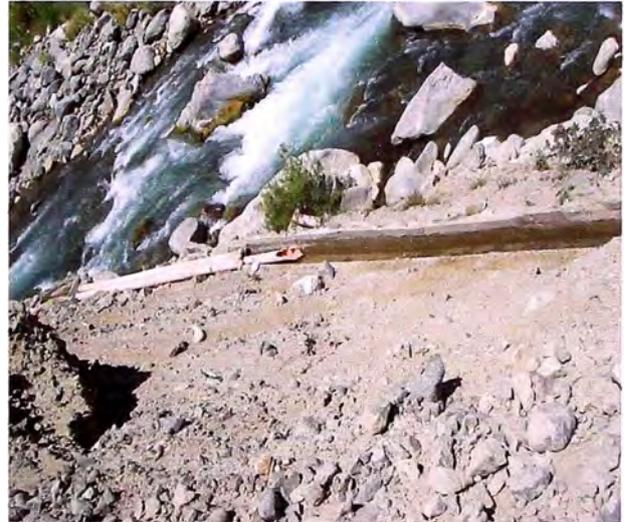
Foto N° 9: Km 68+200: Canal de riego y empalme con tubería de PVC, este canal esta afectado por los deslizamientos de boloneria.
