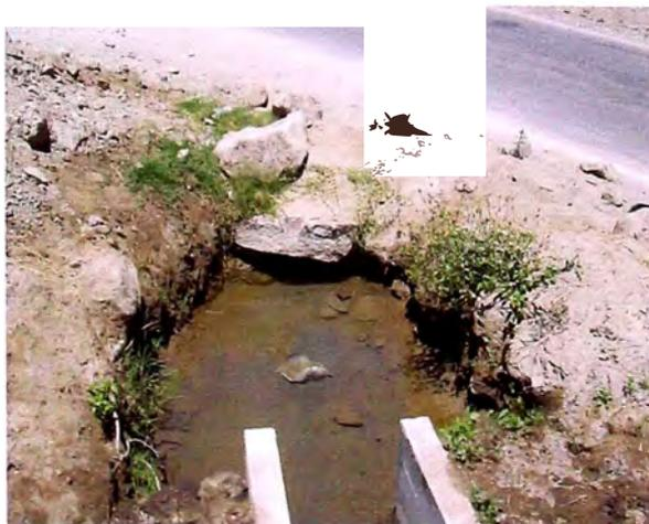
Foto N° 12: Km 68+000: Aguas arriba canal de riego. Necesidad de diseño de emboquillado.
