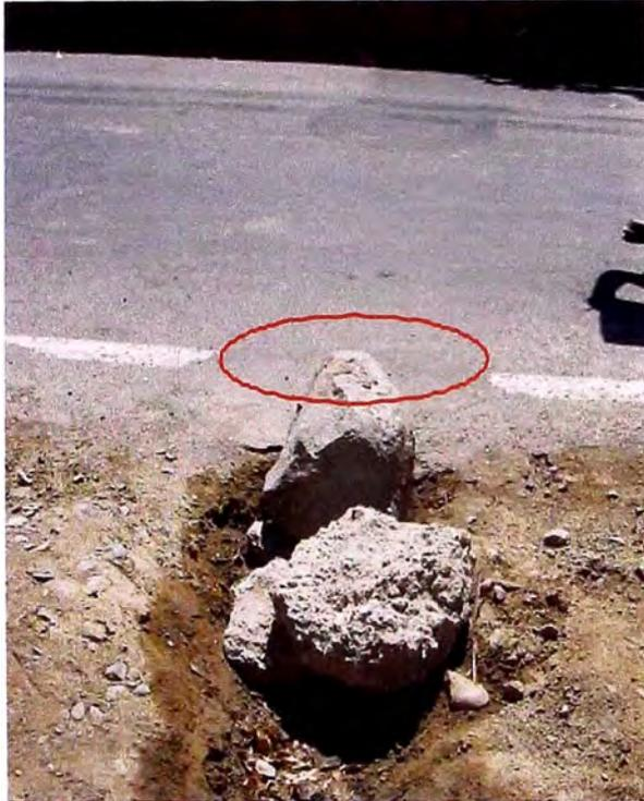
Foto N° 22: Km 66+500 se encuentra deterioro en el pavimento, debido a que hay un infiltración por debajo de este tramo, la línea continua de la carretera también se está borrando.
