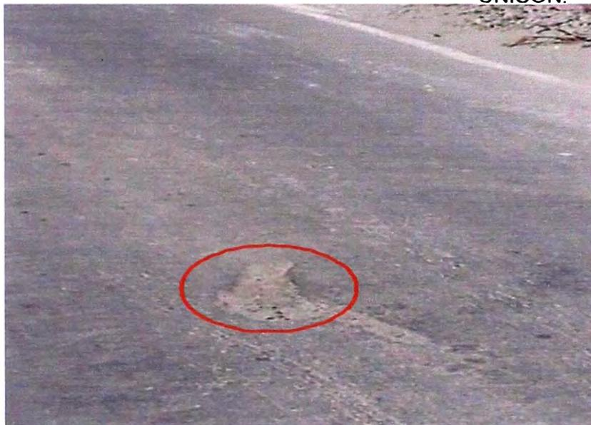
Foto N° 28: Km 65+150 se encuentra deterioro en el pavimento en la carretera, se ha generado un pequeño bache, esto puede ser debido a que pasan vehículos de grandes cargas.
