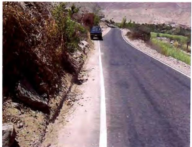
Foto N° 13: Km 67+000 al 68+000: Necesidad de alcantarillas, por derrame de agua de terrenos de cultivo adyacente a la carretera.
