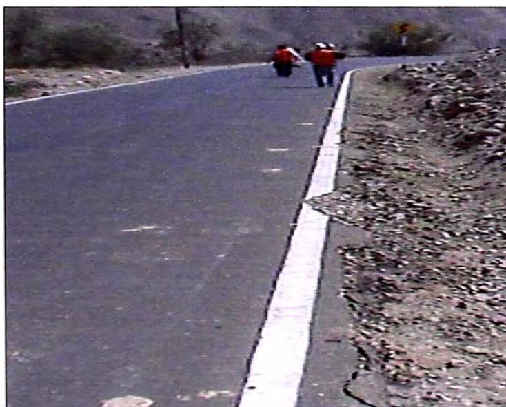
Foto N° 33: Km 64+400 se encuentra deterioro en el pavimento en los lados de la carretera, debido a que falta mejorar la vía realizando pendientes a los lados de esta, para una mejor estabilización de los contornos de la carretera
