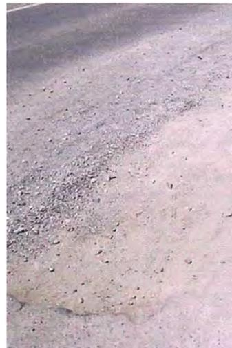
Foto N° 25: Km 66+000 se encuentra deterioro en el pavimento en la carretera, debido a que se ha creado una vía de acceso para el campamento de la C.H. El Platanal.
