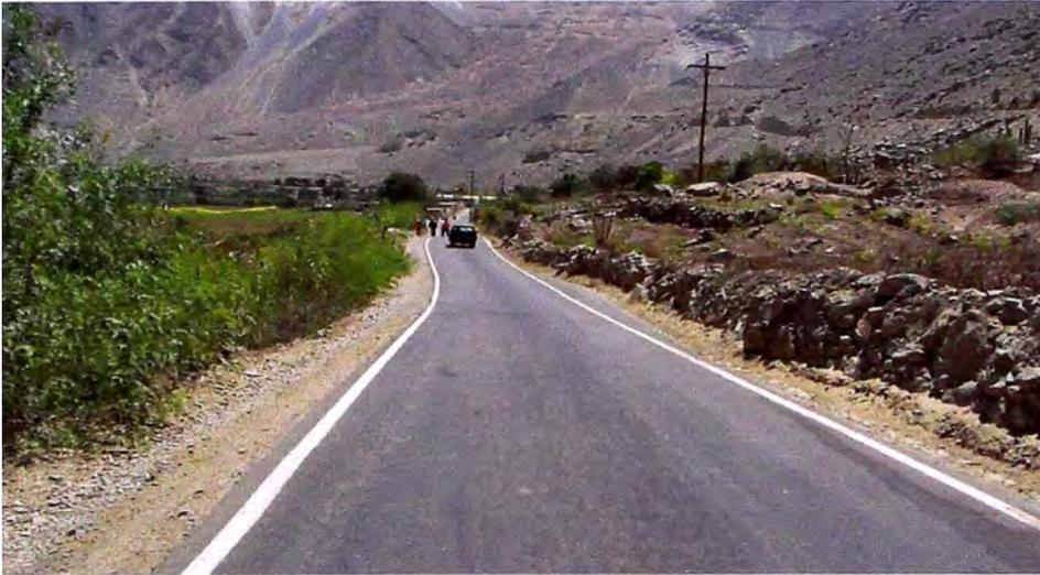
Foto N° 14: Km 67+900 al Km 68+000, Cunetas en mal estado.
