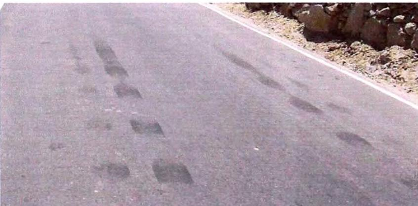
Foto N° 20: Km 66+980 se encuentra marcas en el pavimento por las llantas producto del esfuerzo de frenado que generan los vehículos,
