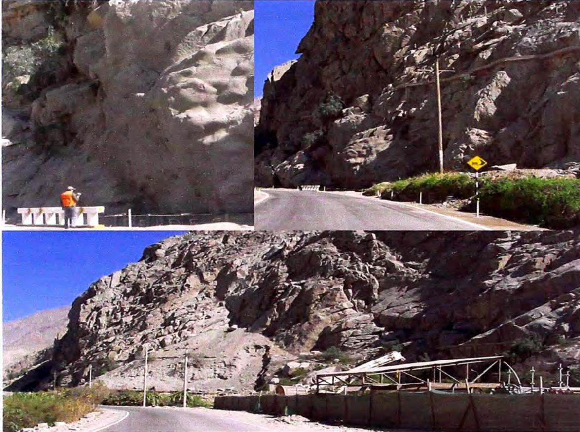
Fotos N° 39, 40 y 41: KM 65+200: Túnel de la Central Hidroeléctrica El Platanal, la parte inferior del talud está recubierto de concreto lanzado y sostenido con anclajes, el cual presenta fisuras. La dirección de las caras de fractura no es favorable por la dirección de la vía en la zona del túnel. Existe el peligro de caída de rocas, tal como lo previene la señalización de la vía.
