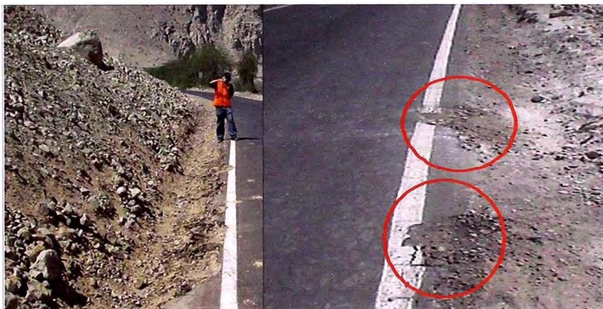
Foto N° 32: Km 64+600 se encuentra deterioro en el pavimento en los lados de la carretera, debido a que falta mejorar la vía realizando pendientes a los lados de esta, para una mejor estabilización de los contornos de la carretera.
