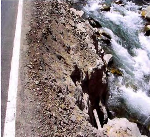
Foto N°8: Km 68+300: Necesidad de muro de sostenimiento
