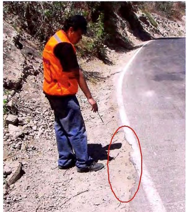
Foto N° 19: Km 67+050 se encuentra deterioro de la carretera, debido a que falta mejorar la vía realizando pendientes a los lados de esta, como se puede ver en la imagen no solo afecta al slurry también se deteriora el pintado de la señalización.
