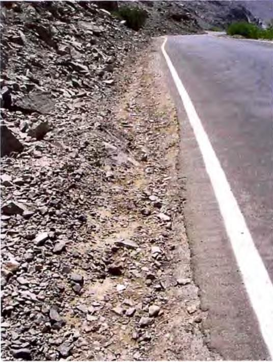
Foto N°4: Km 68+700 Cunetas de tierra en mal estado
