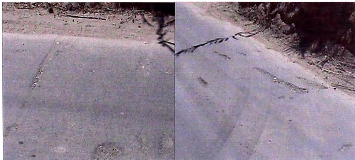
Foto N° 29 - 30: Km 65+100 se encuentra deterioro en el pavimento en la carretera, se ha generado huecos, debido al frenado y/o carga de los vehículos.
