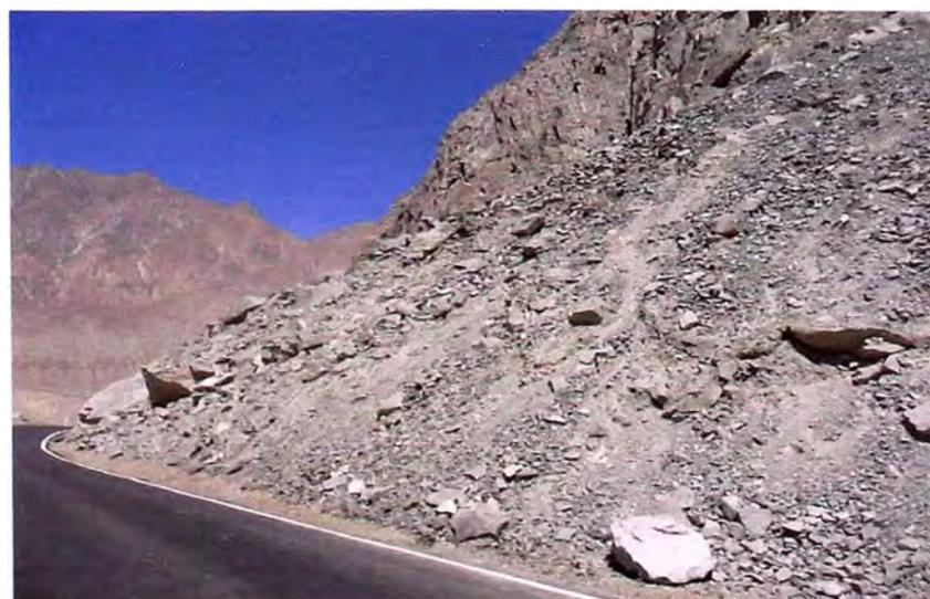
Foto N° 38: KM 69+000: Erosión de talud inferior, ocasionado por la curvatura del río, en esta zona el ancho de la vía se reduce.
