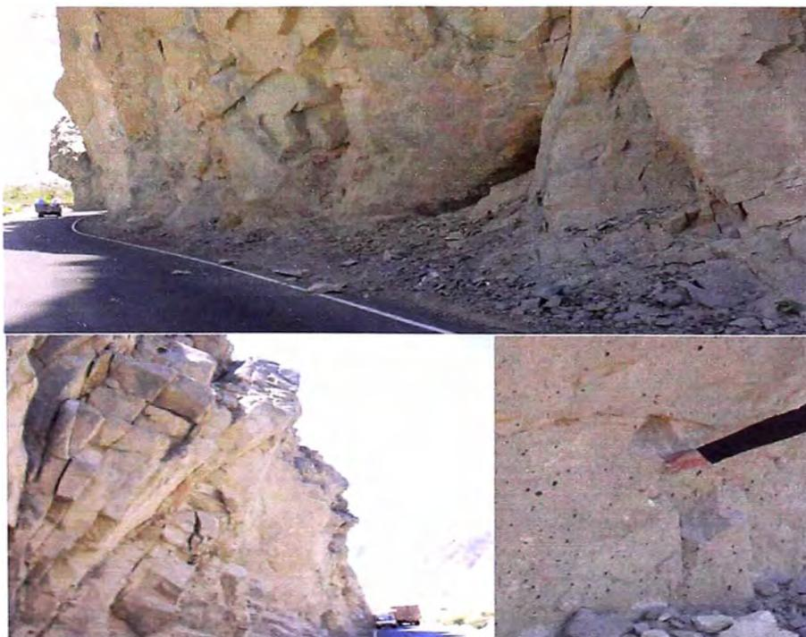
Fotos N° 42, 43 y 44: KM 68+600 al KM 68+700: Desprendimiento superficial de rocas fuertemente meteorizada con presencia de finos en las fisuras.
