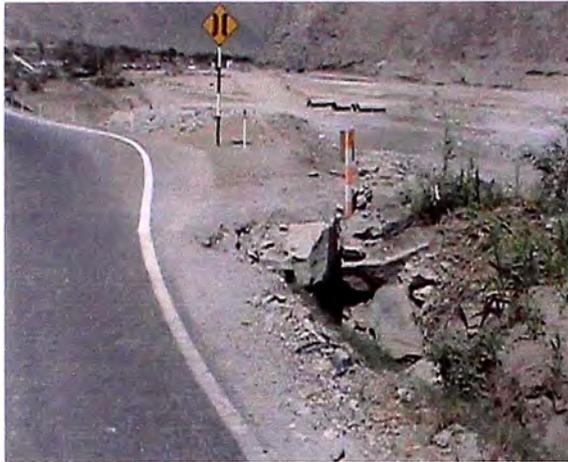
Foto N° 26: Km 65+300 se encuentra deterioro en el pavimento en la carretera, debido al canal de riego que pasa por esta zona.
