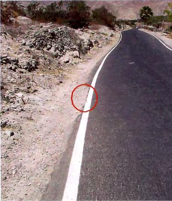
Foto N° 18: Km 67+100 deterioro de la carretera, debido a que falta mejorar la vía realizando pendientes a los lados de esta, con dirección a la cuneta de tierra.
