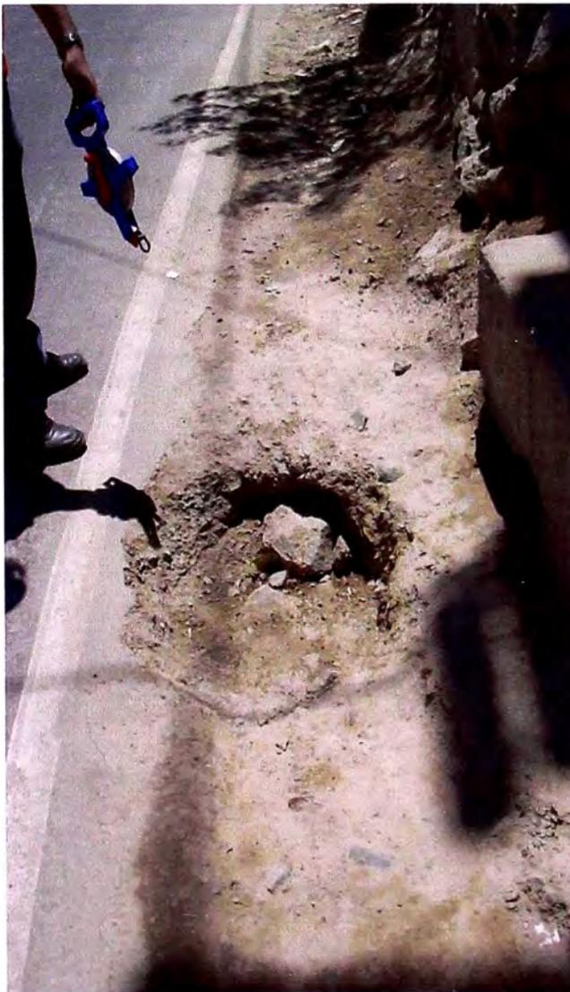
Foto N° 15: Km 67+590 Necesidad de alcantarillas, para evitar filtraciones y derrame de agua por los terrenos de cultivo adyacentes.
