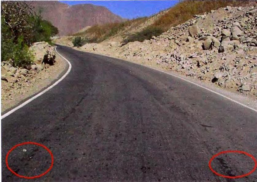
Foto N° 34: Km 64+700 en la imagen se ve que unos de los grandes problemas por lo cual el pavimento se deteriora rápidamente en muchas partes del Perú es por el aceite que los vehículos dejan cuando estos circulan por la vía, esto deteriora a la vía con el tiempo.
