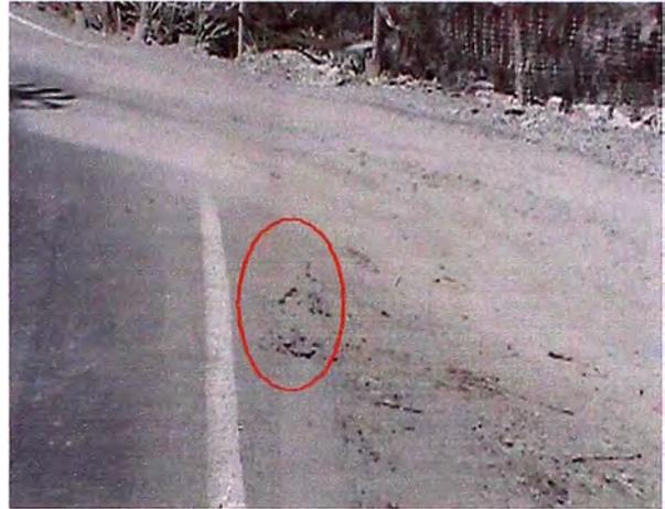
Foto N° 27: Km 65+200 se encuentra deterioro en el pavimento en la carretera, debido a que se ha creado una vía de acceso para la concretera UNICON.
