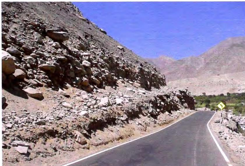
Foto N° 37: KM 68+900: Depósito aluvial poco consolidado que contamina constantemente la cuneta provisional.
