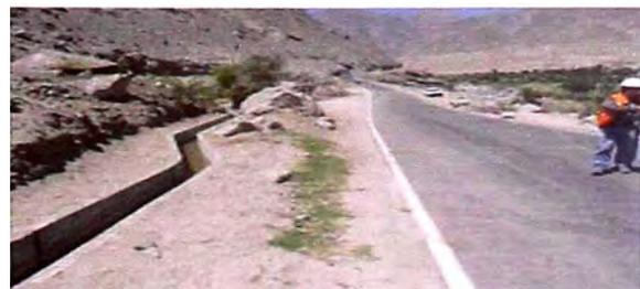
**SALPICONES DE CONCRETO EN LOS BORDES LATERALES DE LA VIA:** Se encuentra en los tramos donde a habido tratamiento artificial de talud (capas de mezclas cementantes).
