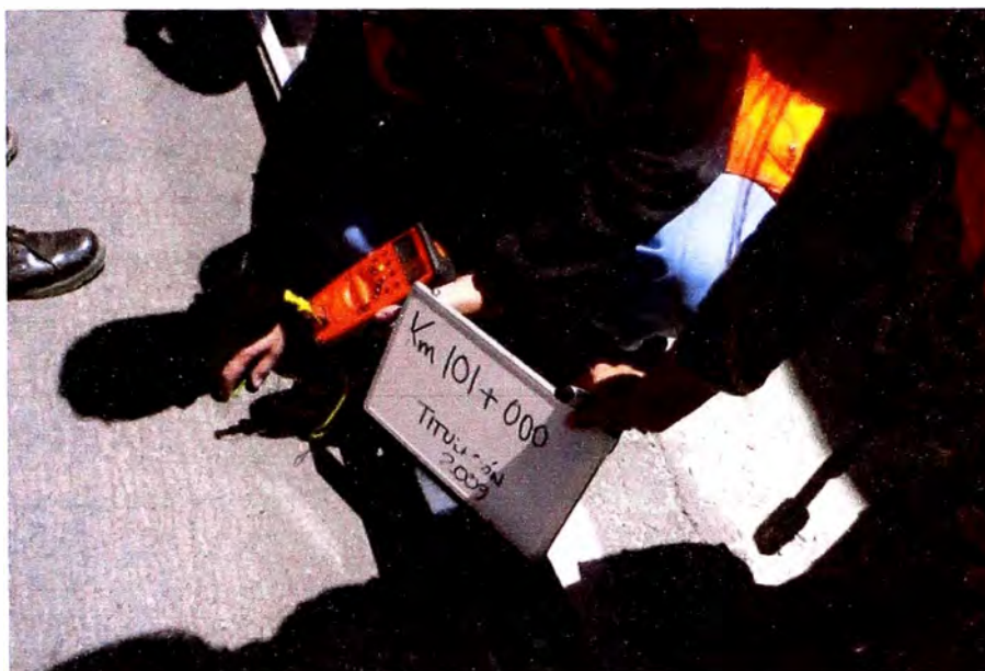
Figura N°4.3 Medida de temperatura del asfalto
