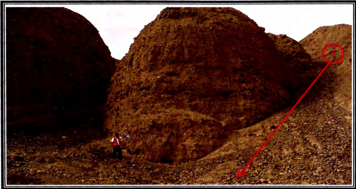
Foto Nro. 3.03 Se observa el talud que presenta una topografía accidentada, disectada por la quebrada con fuerte pendiente 2H:1V (Ver Flecha Nro. 1). El talud contiene roca meteorizada sobre su superficie, con tamaño máximo de 5”.
