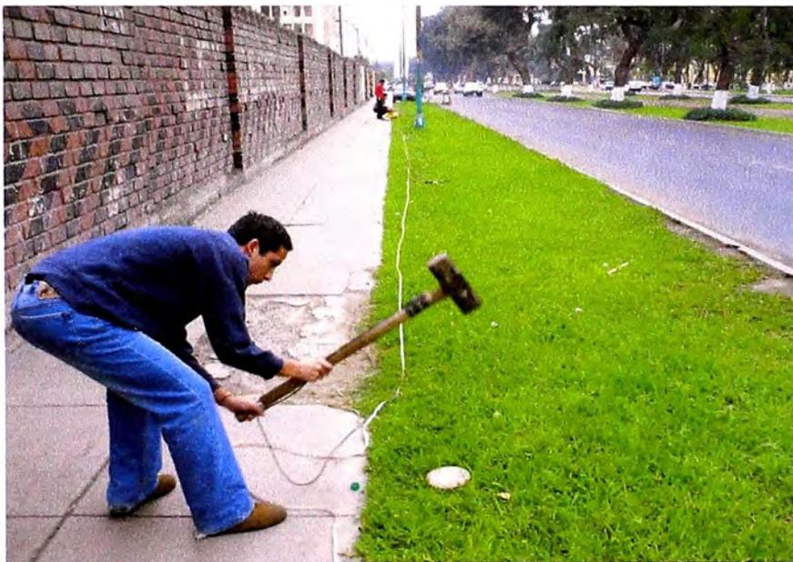
Foto 08: En la vista se aprecia el instante en el cual se golpea el plato para generar las ondas. En el ensayo MASW:
