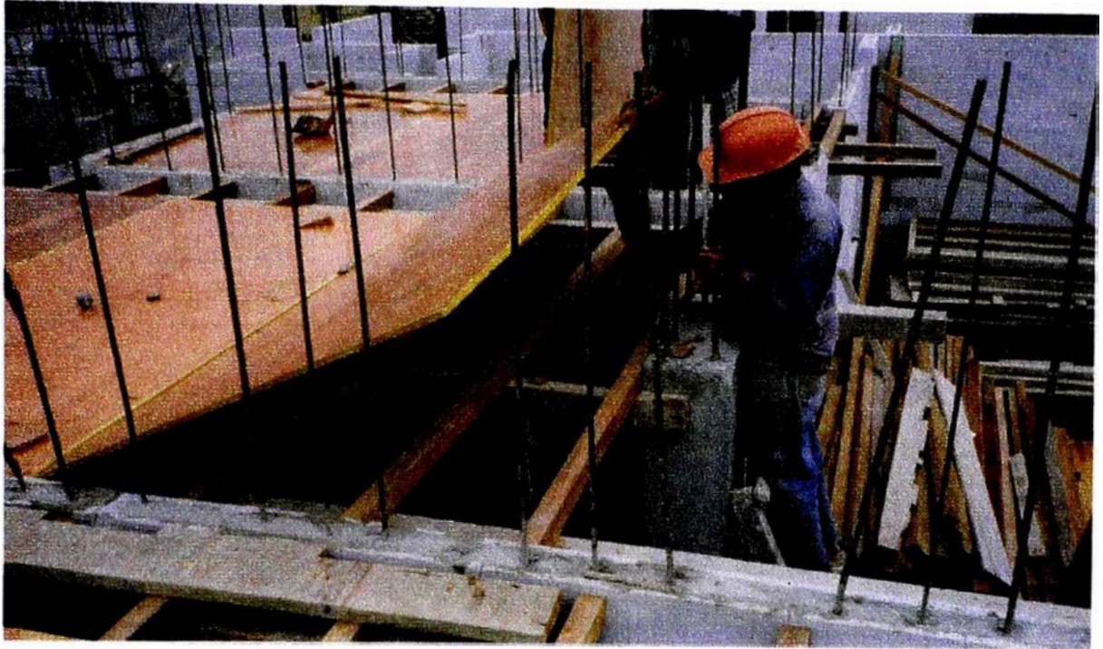
Foto 10: Encofrado de los techos con paneles detriplay 19mm.
