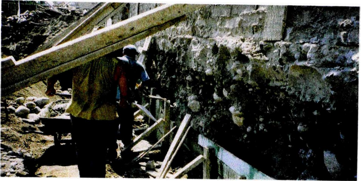
Foto 3: Encofrado de los piques de las calzaduras
