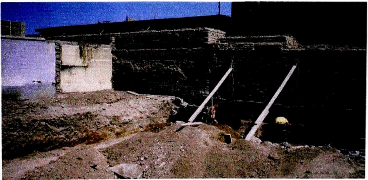
Foto 2: Calzadura de muros de adobe con cimiento de concreto de muros colindantes
