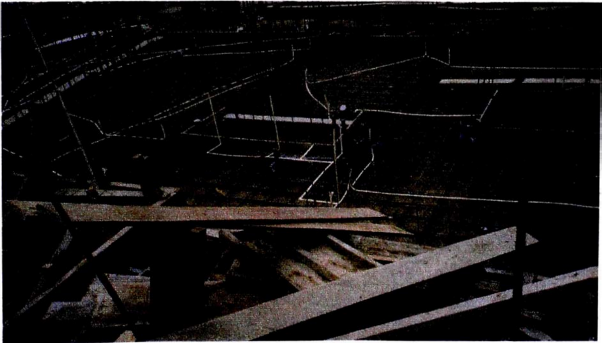
Foto 6: Refuerzos verticales y horizontales en la losa de cimentación
