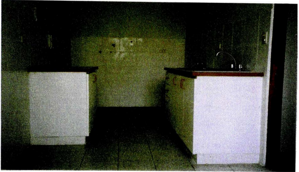
Foto 12: Pisos, zócalos de cerámico Celima y muebles bajos en cocina
