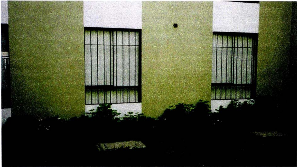
Foto 19: Rejas metálicas en ventanas del primer piso en la zona de estacionamientos
