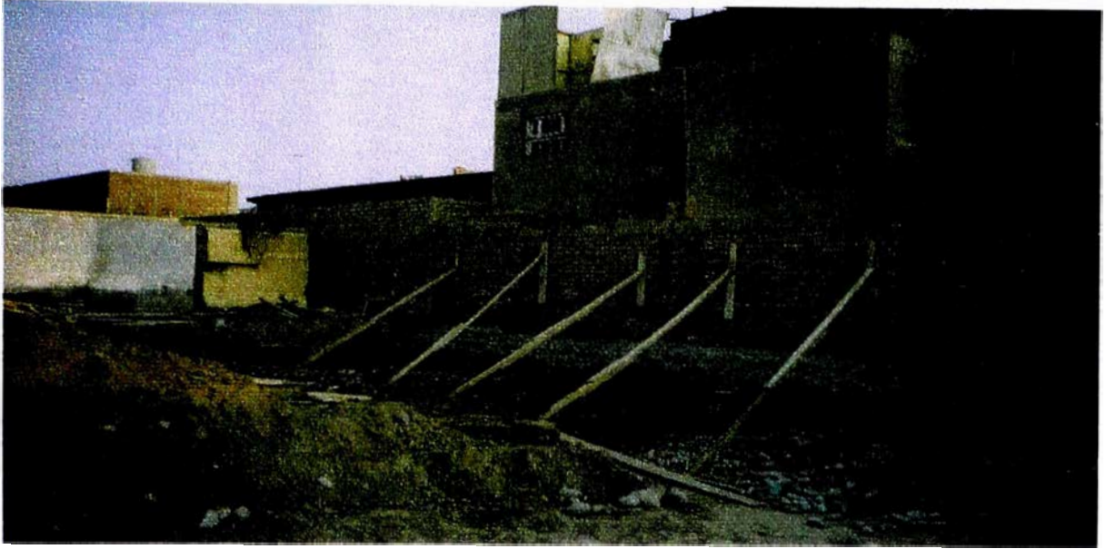
Foto 5: Relleno del área de la losa de cimentación
