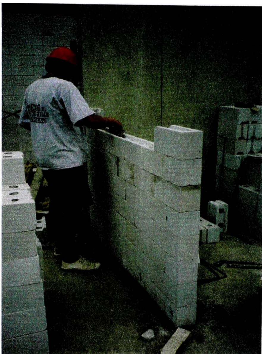
Foto 8: Apilado de los muros con ladrillo silicocalcareos
