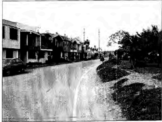
6 - 6 Ca. 10; Vista hacia el Este
