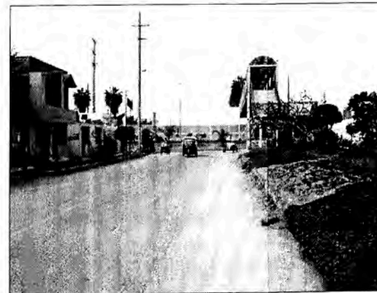
7 - 7 Ca. 10; Vista hacia el Este
