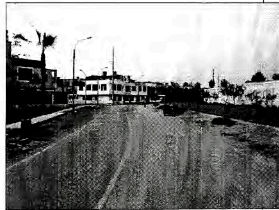
5 - 5 Ca. 10; Vista hacia el Este
