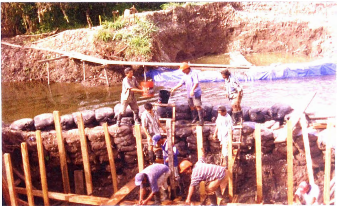
FOTO N° 08: Encofrado del solado de la zapata del Estribo del puente.
