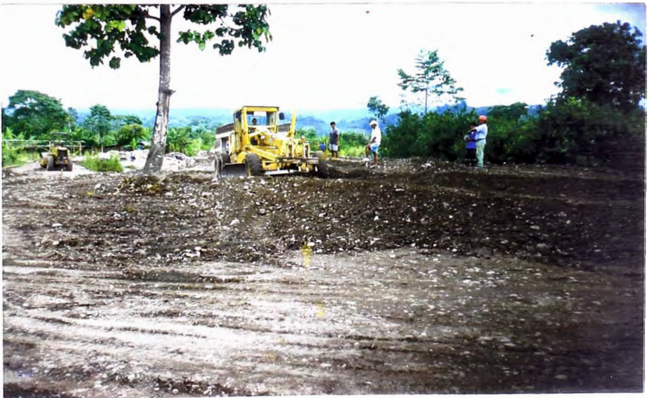
FOTO N° 48: Trabajos de la motoniveladora en el acceso al puente.
