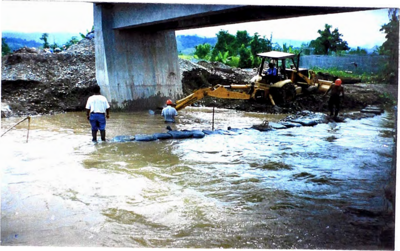
FOTO N° 31: Excavación bajo agua para la colocación de los Gaviones.
