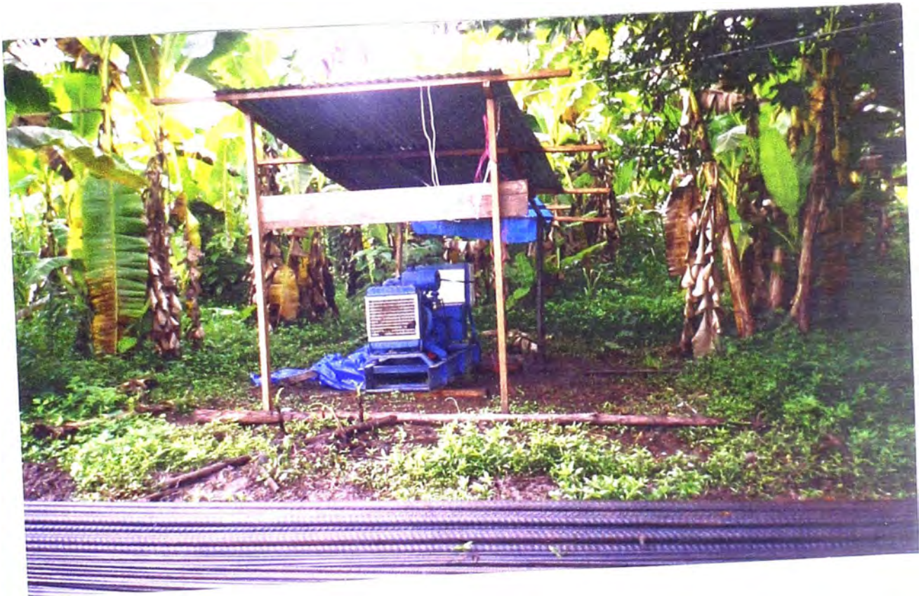
FOTO N° 26: Grupo electrógeno para facilitar los trabajos nocturnos.
