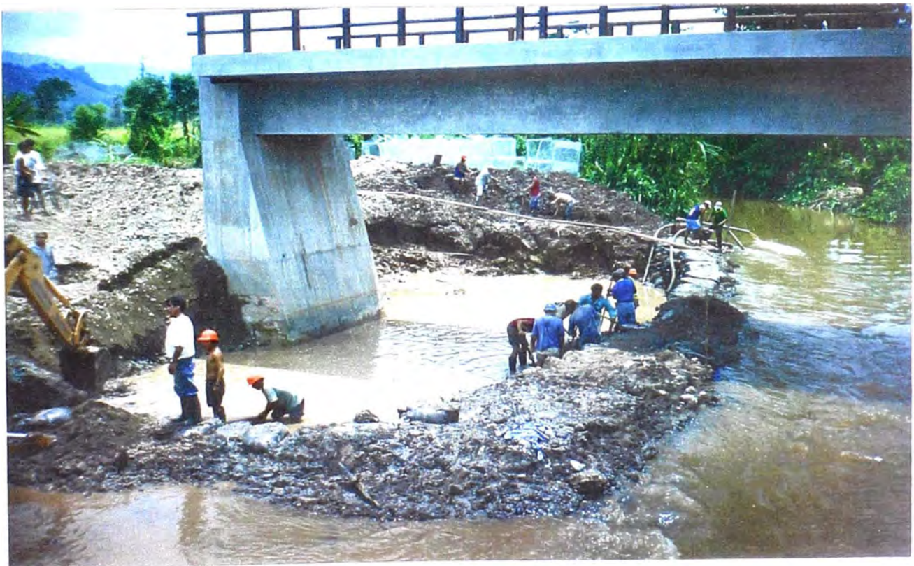
FOTO N° 34: Excavación para la colocación del colchón de Gaviones.
