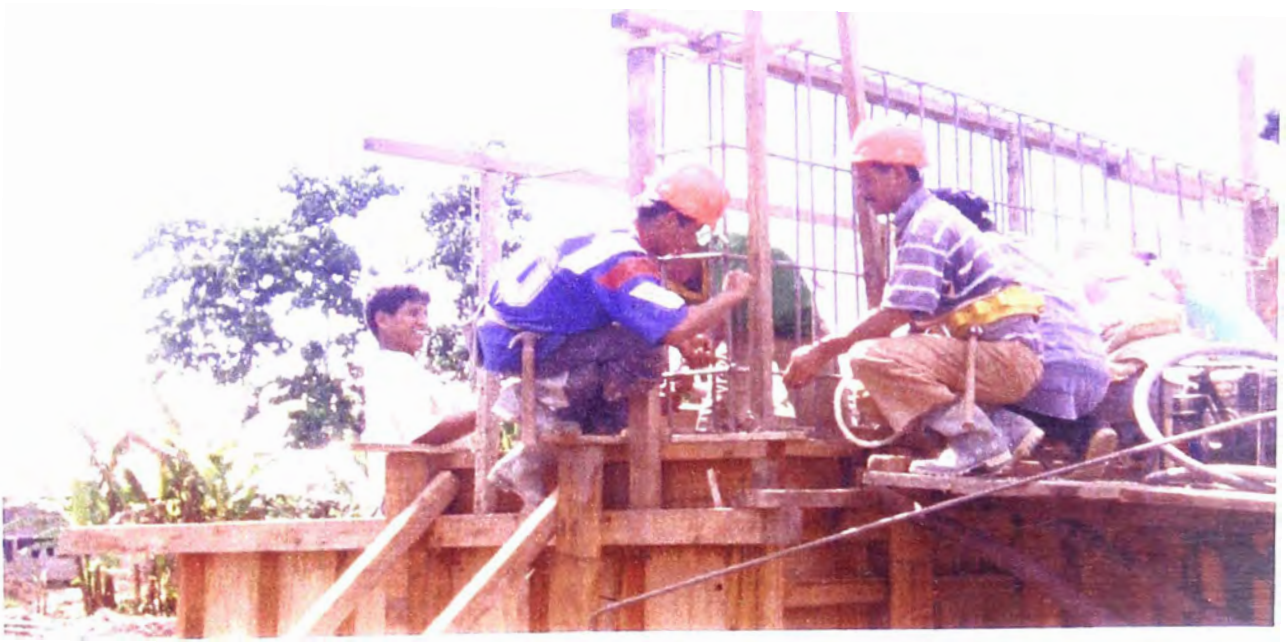
FOTO N° 16: Colocación del acero en la cajuela del Estribo del puente.
