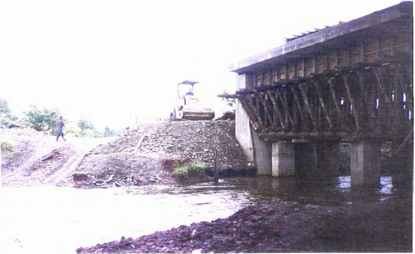
FOTO N° 43: Se observa los trabajos de compactación en el puente.
