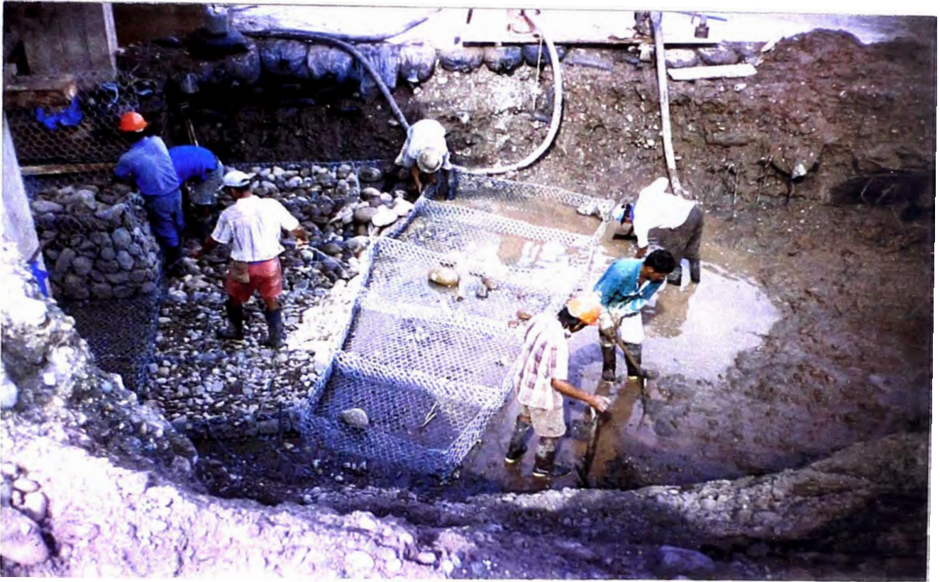
FOTO N° 37: Se observa el llenado del colchón de los Gaviones.
