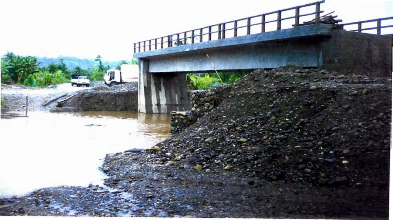
FOTO N° 49: Se observa el puente casi terminado.
