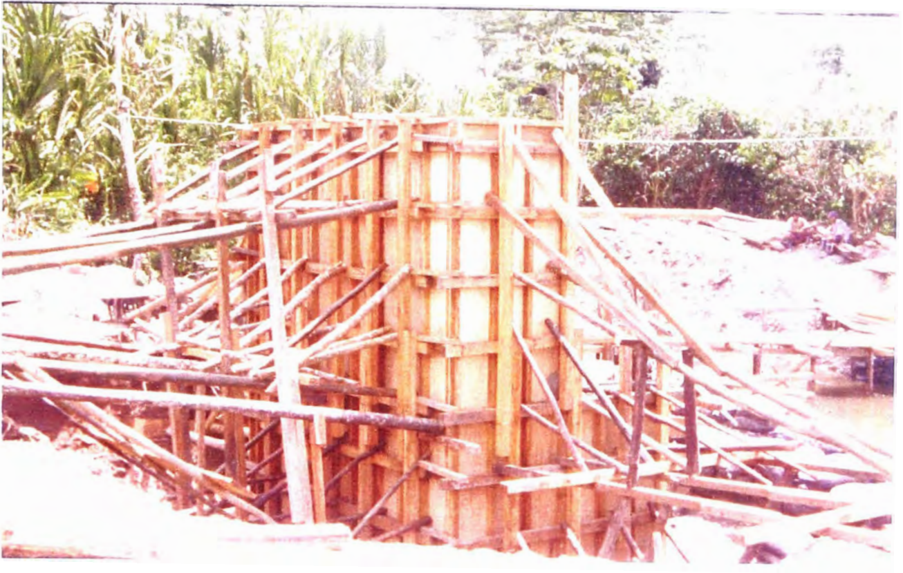
FOTO N° 13: Encofrado del cuerpo del Estribo del puente.
