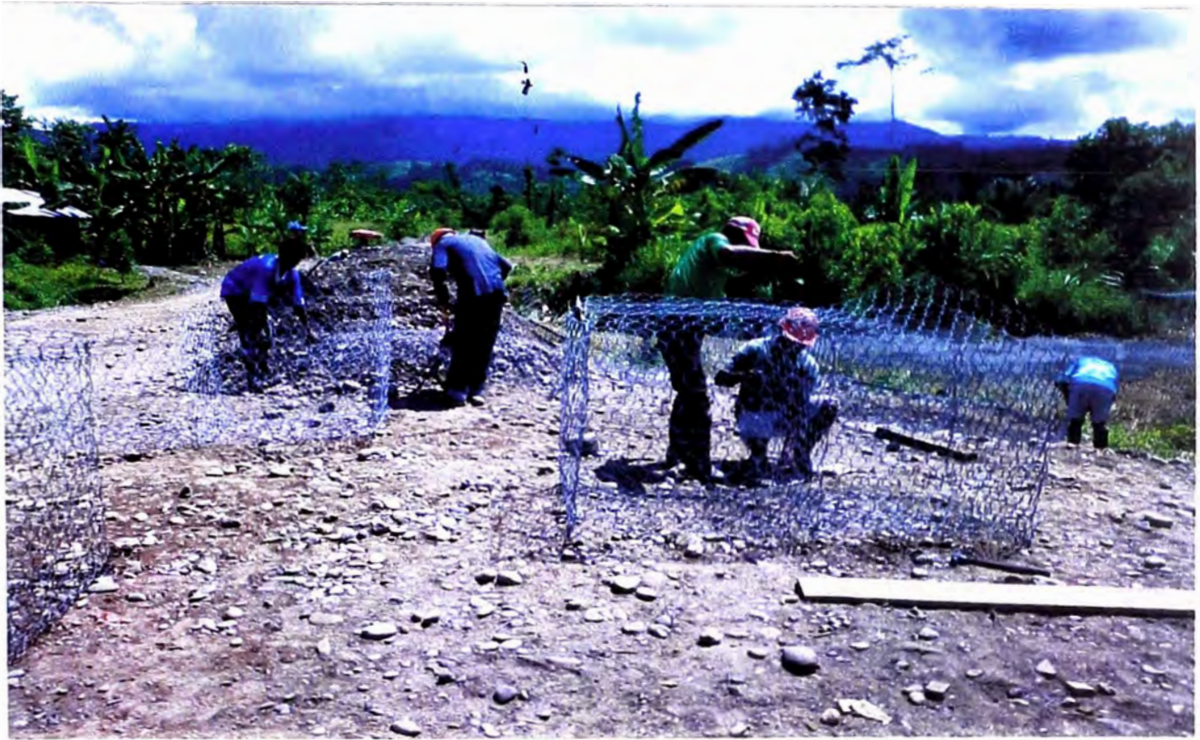
FOTO N° 35: Se observa los Gaviones que se usaran para las obras de defensas.
