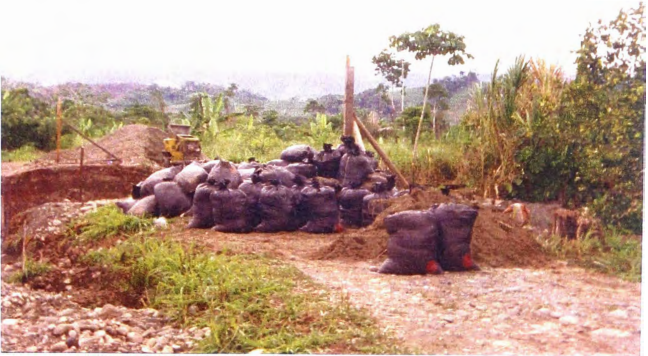
FOTO N° 05: Sacos llenos de arenas que servirá para protección en la excavación.
