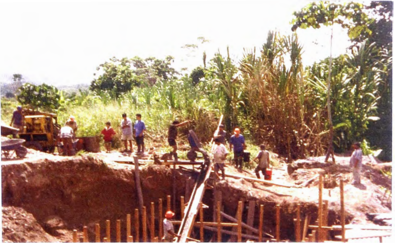
FOTO N° 09: Vaciado de concreto en la zapata del estribo izquierdo del puente.
