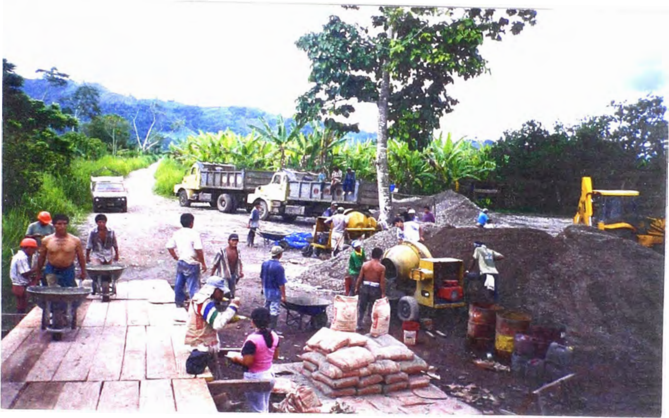
FOTO N° 29: Fabricación del concreto en obra con 02 trompos de 9p3.
