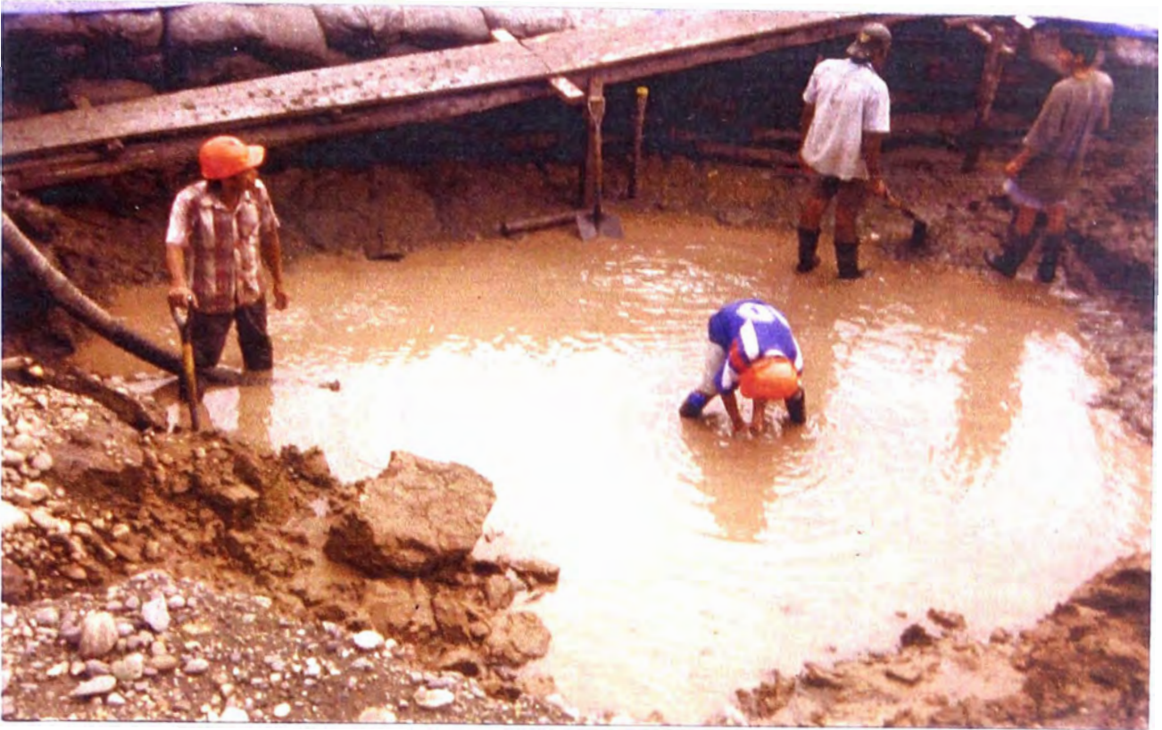
FOTO N° 03: Excavación bajo agua en el Estribo Izquierdo.
