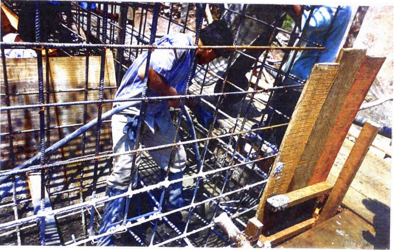
FOTO N° 11: Se observa el vibrado de concreto en la estructura del puente.
