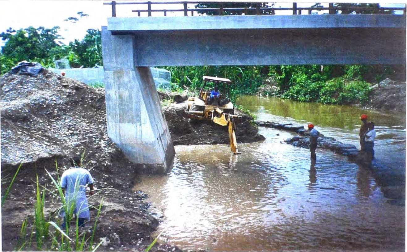
FOTO N° 33: Excavación bajo agua con Retroexcavadora para la colocación del colchón de Gaviones.
