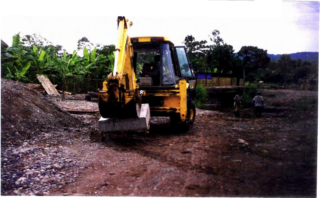
FOTO N° 23: Traslado del dado de concreto para reforzar el falso puente.
