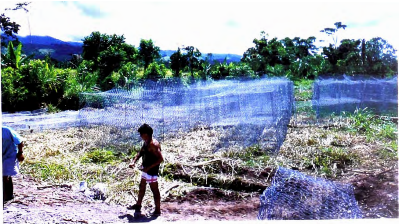
FOTO N° 36: Se observa los Gaviones que se usaran para las obras de defensas.
