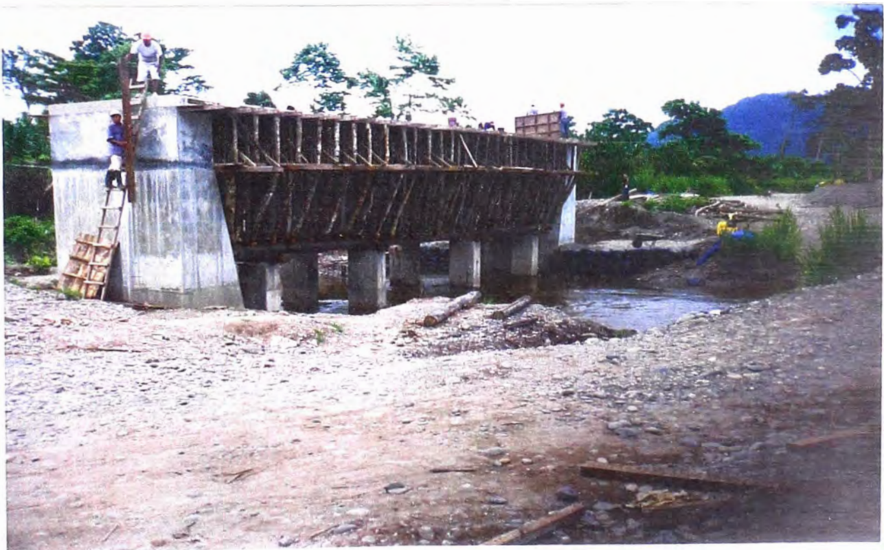
FOTO N° 22: Se observa el encofrado de la viga y la losa del puente.
