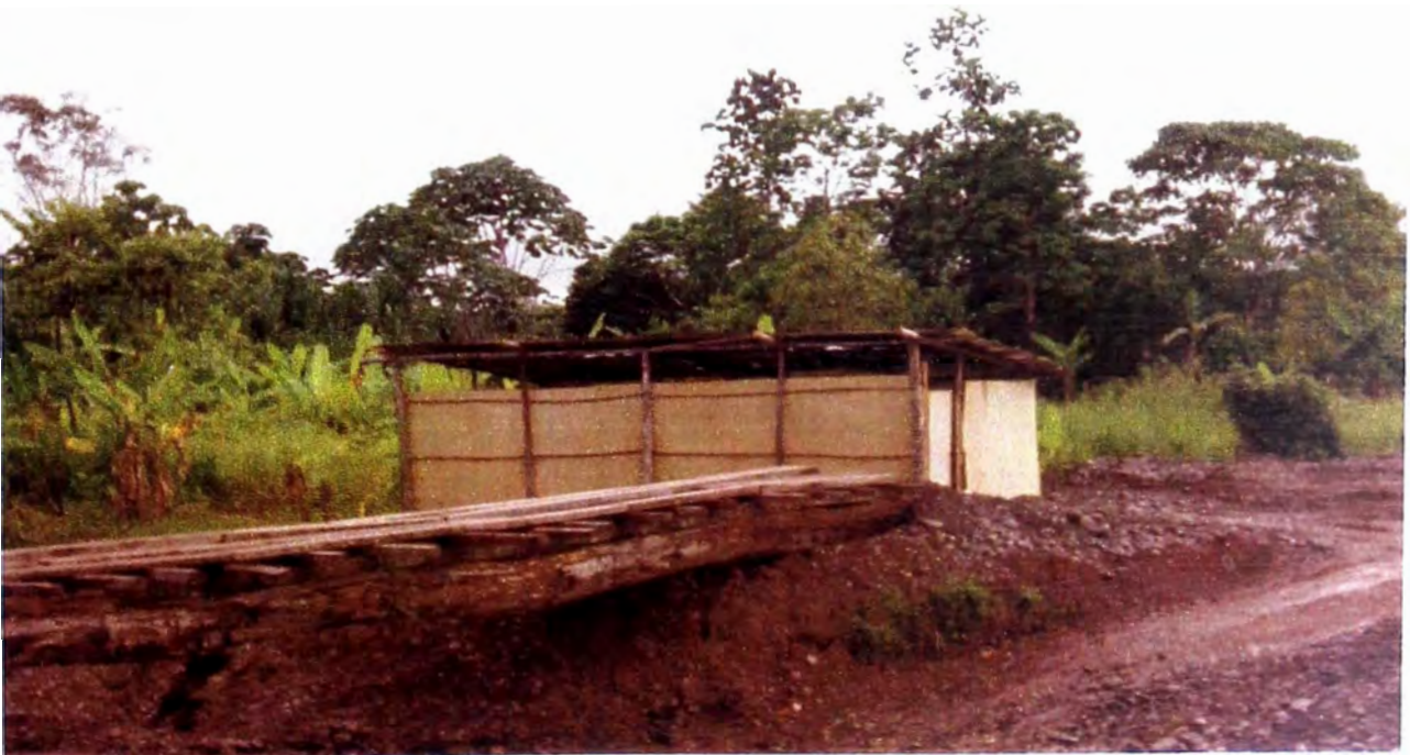
FOTO N° 02: Puente peatonal provisional
