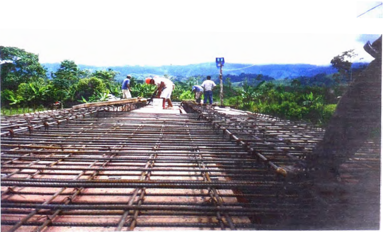
FOTO N° 28: Colocación de la armadura en la losa del puente.
