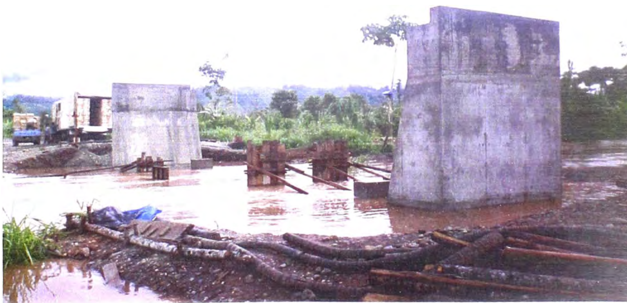
FOTO N° 18: Se observa los dados de concreto para construir el falso puente.
