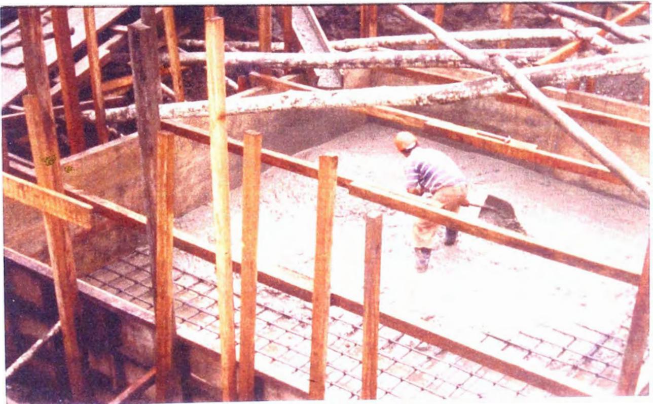
FOTO N° 10: Vaciado de concreto en la zapata del estribo derecho.
