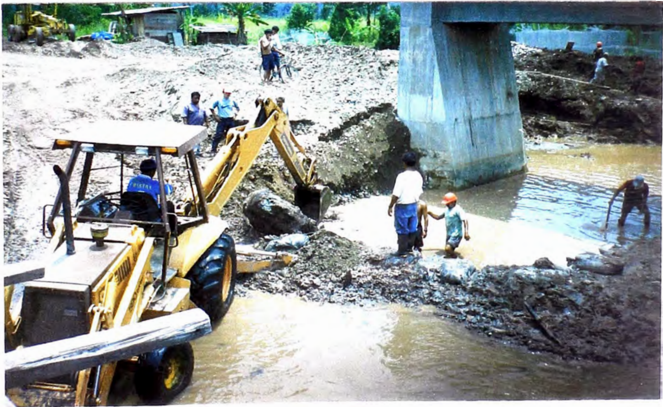
FOTO N° 32: Excavación para la colocación de los Gaviones con la Retroexcavadora.
