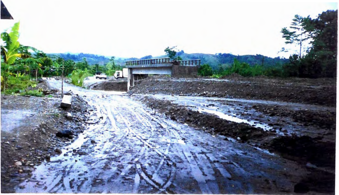
FOTO N° 47: Se observa el relleno y compactado de los accesos del puente.
