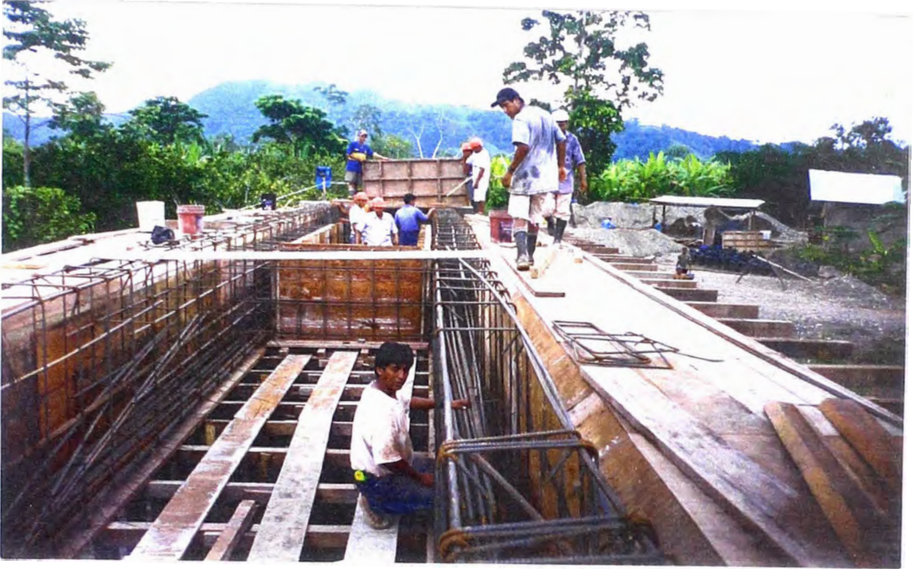
FOTO N° 27: Colocación de la armadura en la viga del puente.
