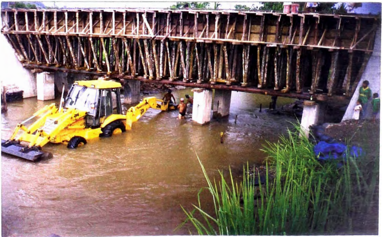
FOTO N° 24: Colocación de los dados de concreto con el apoyo de la Retroexcavadora.
