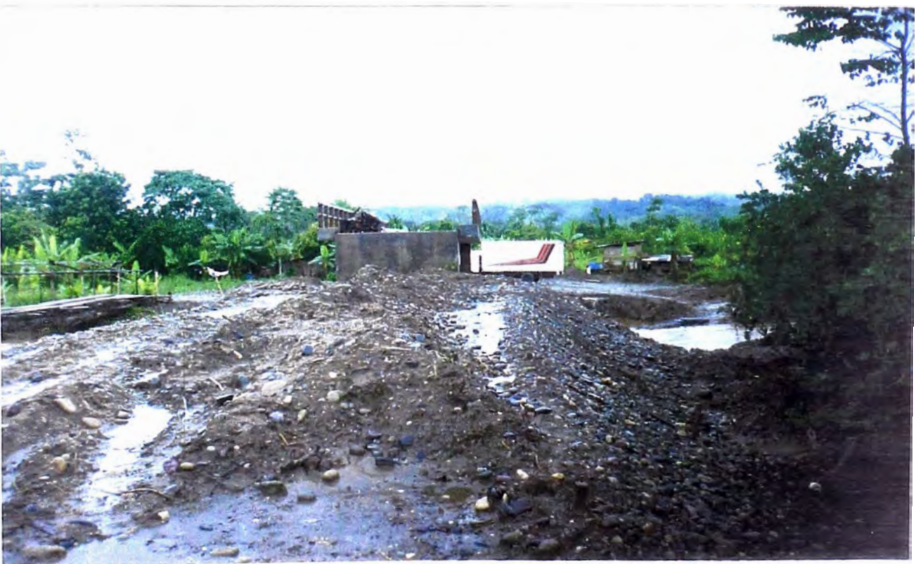
FOTO N° 46: Se observa el relleno en los accesos del puente.
