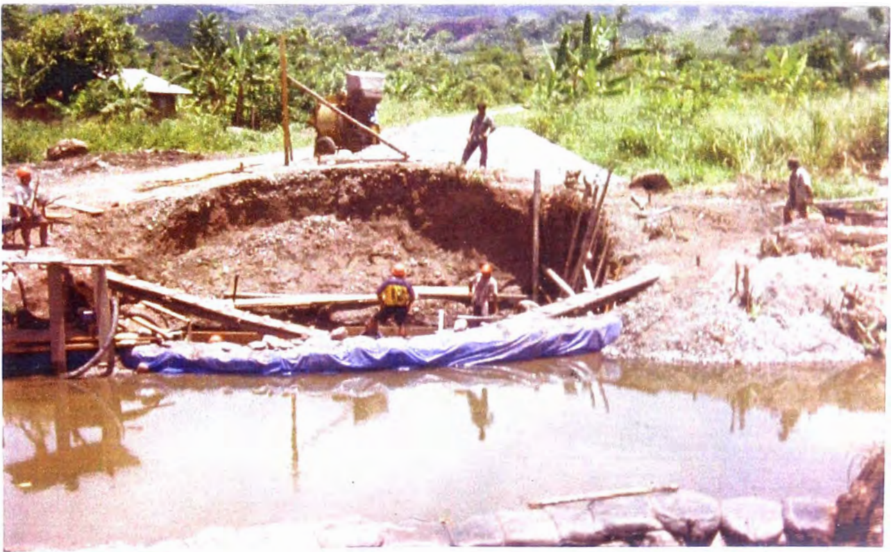
FOTO N° 06: Sacos de arena protegiendo los trabajos de excavación bajo agua.
