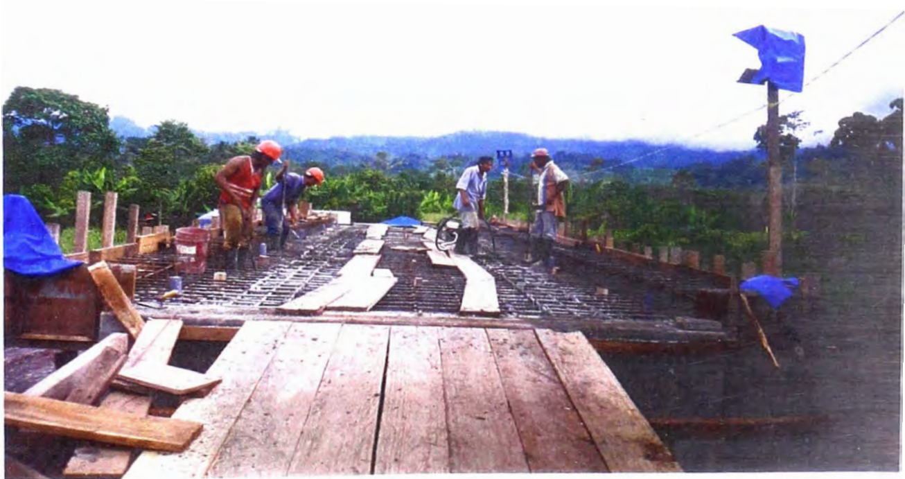
FOTO N° 30: Colocación y vibrado del concreto en la losa.
