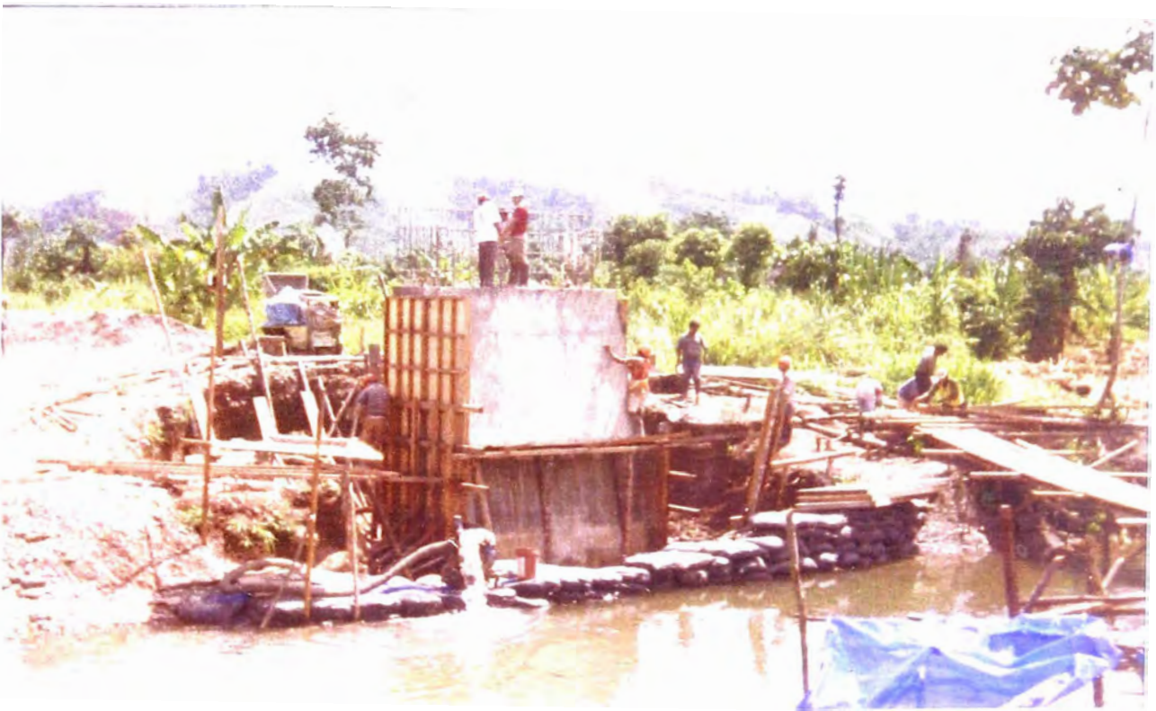
FOTO N° 14: Desencofrado del cuerpo del Estribo del puente.
