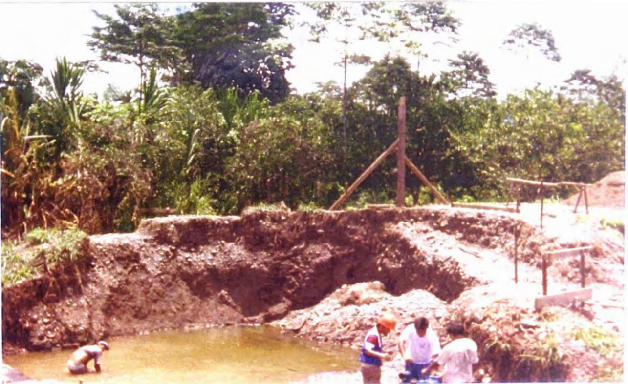
FOTO N° 04: Excavación bajo agua del Estribo Derecho.
