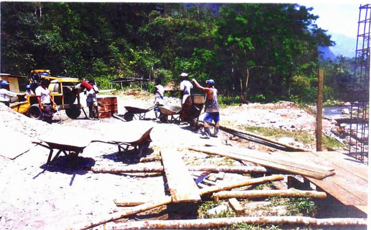
FOTO N° 12: Preparación del concreto en obra.
