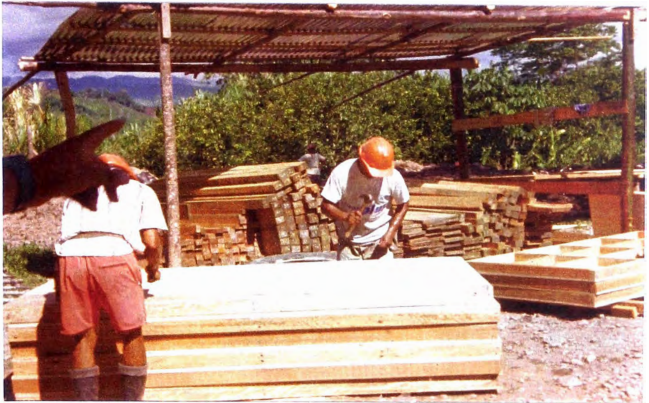
FOTO N° 07: Habilitado de los paneles para realizar el encofrado de las estructuras.
