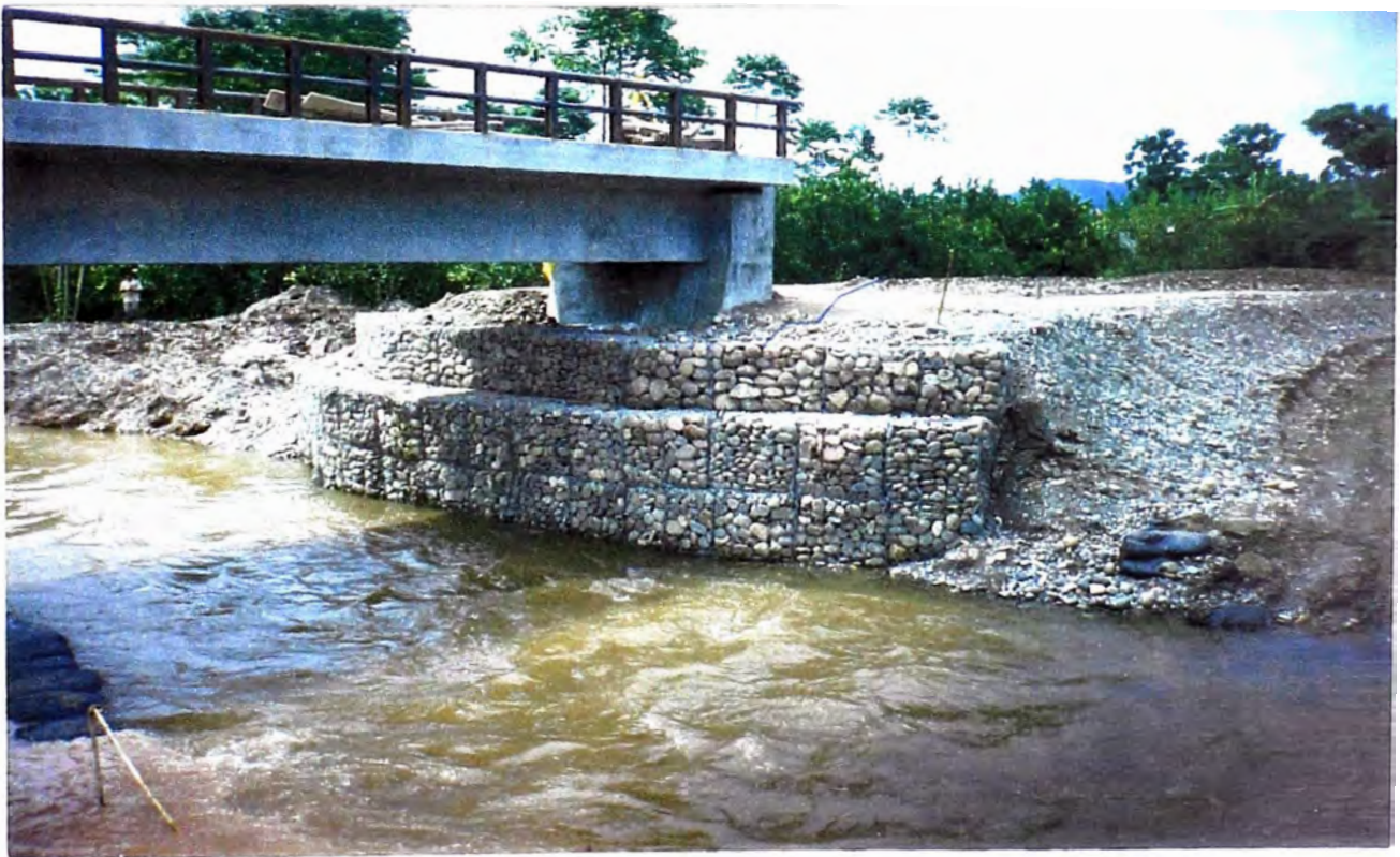
FOTO N° 50: Se observa la defensa de gaviones en el Estribo del puente.
