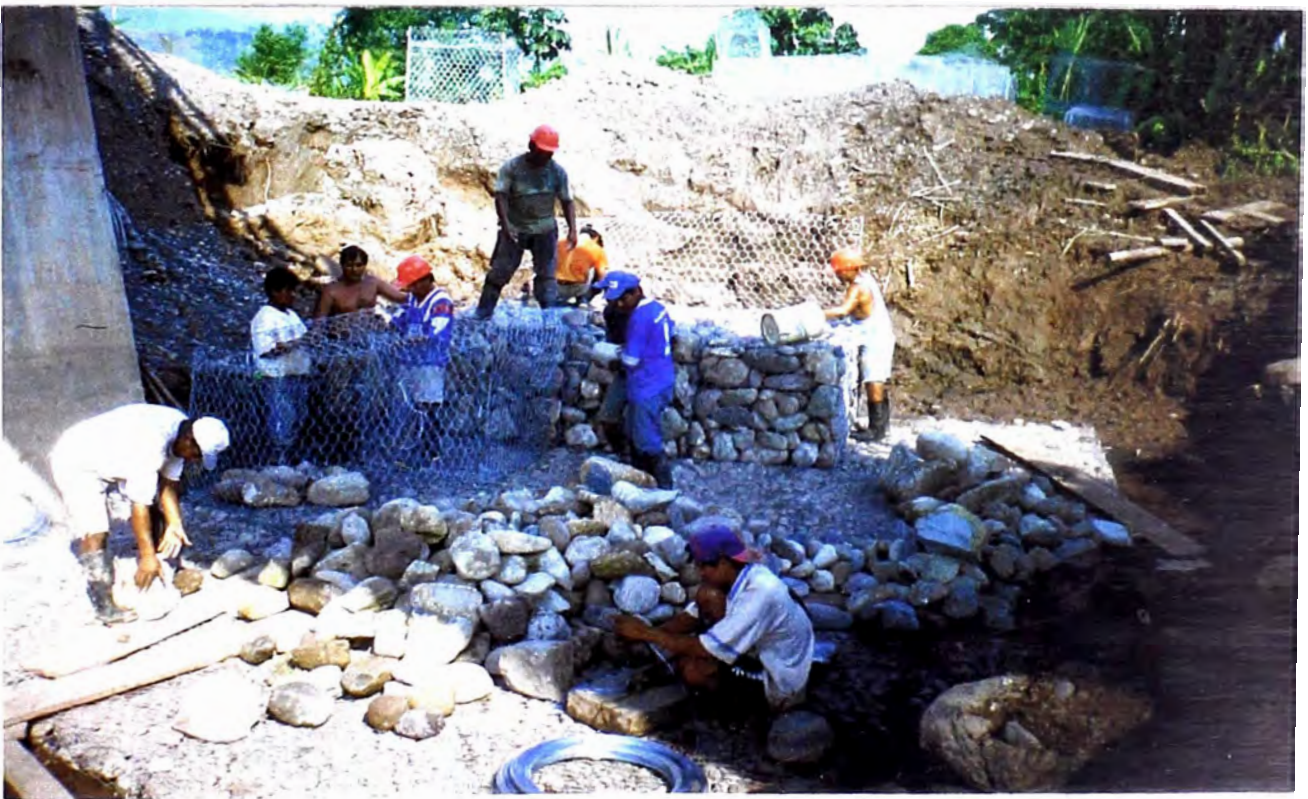
FOTO N° 38: Se observa el llenado del colchón de los Gaviones.
