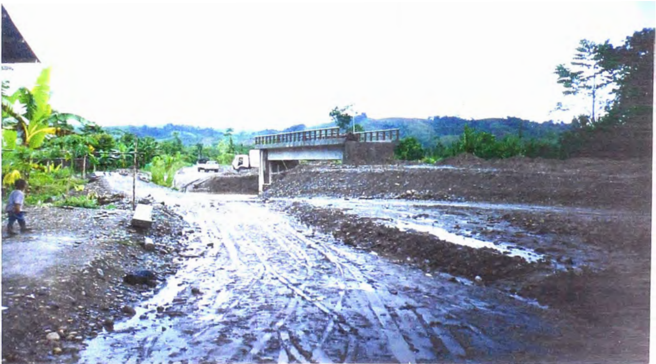
FOTO N° 44: Se observa los accesos del puente.
