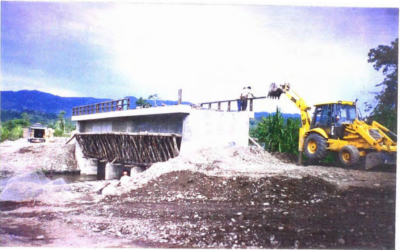
FOTO N° 39: Se observa la colocación de la baranda del puente.
