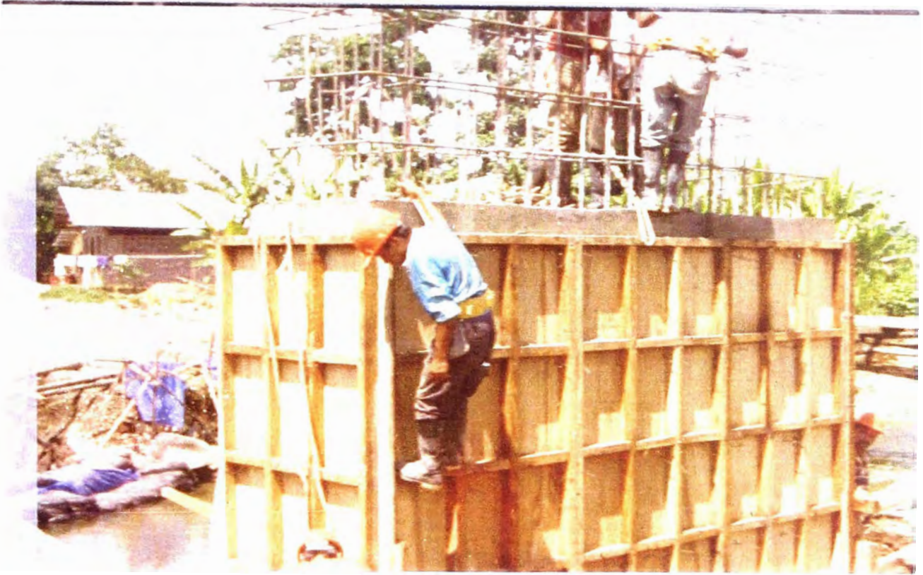
FOTO N° 15: Colocación del acero en la cajuela del Estribo del puente.
