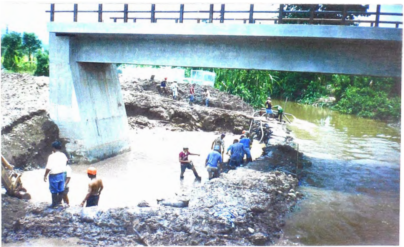
FOTO N° 40: Excavación bajo agua con el uso de las motobombas.
