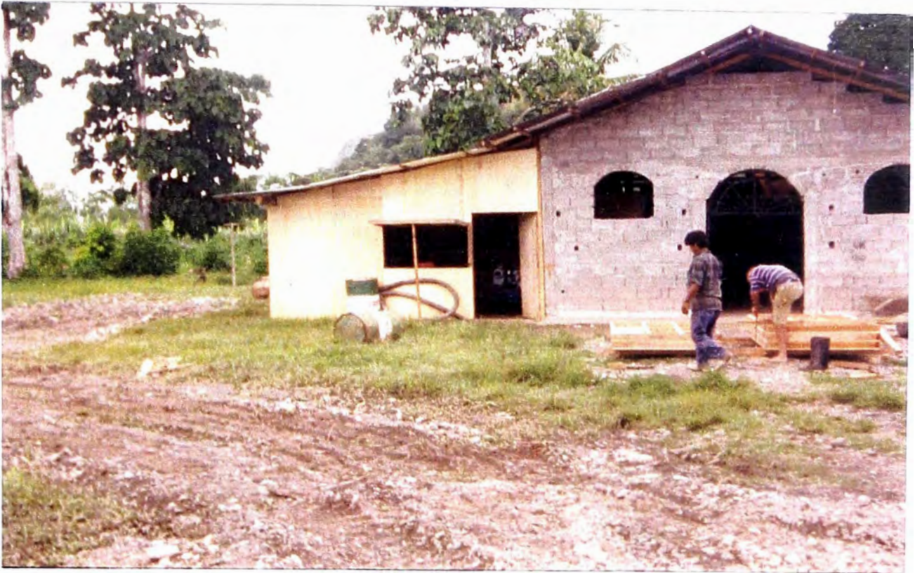
FOTO N° 01: Se observa el campamento y almacén de obra.
