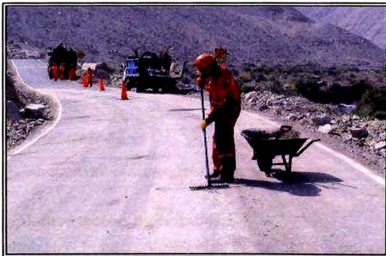
Figura N° 2.5: Bacheo la superficie de rodadura (foto de referencia)
