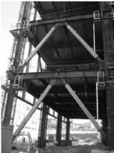
Figura 2. Disipadores instalados para la protección estructural ante sismos
