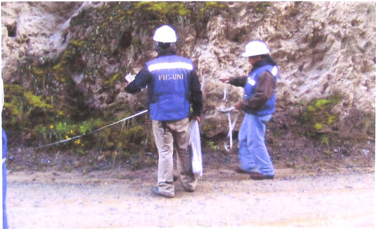
Trabajos de levantamiento topográfico
