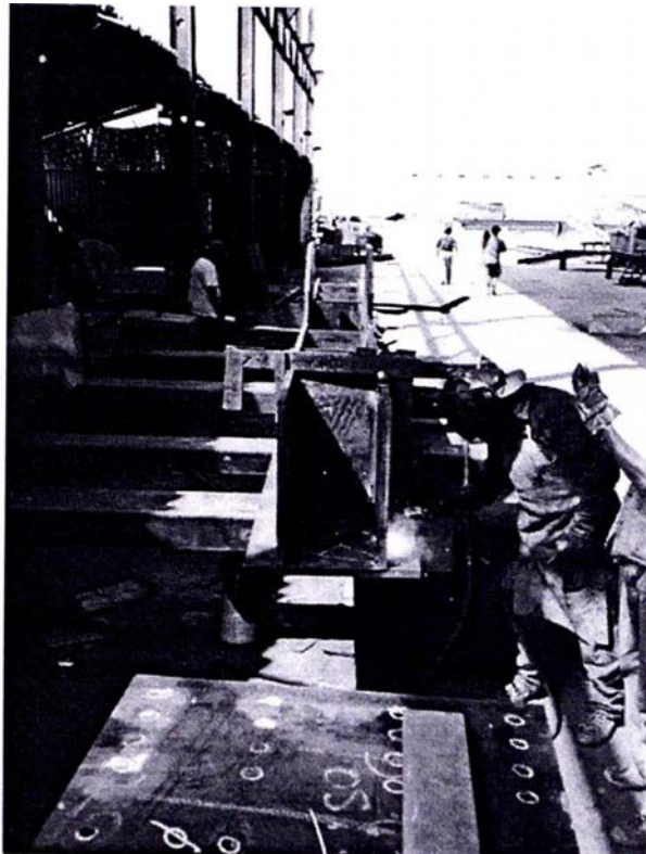
Fig. 4.6 Punto de Soldadura para Ensamblaje de Miembro
