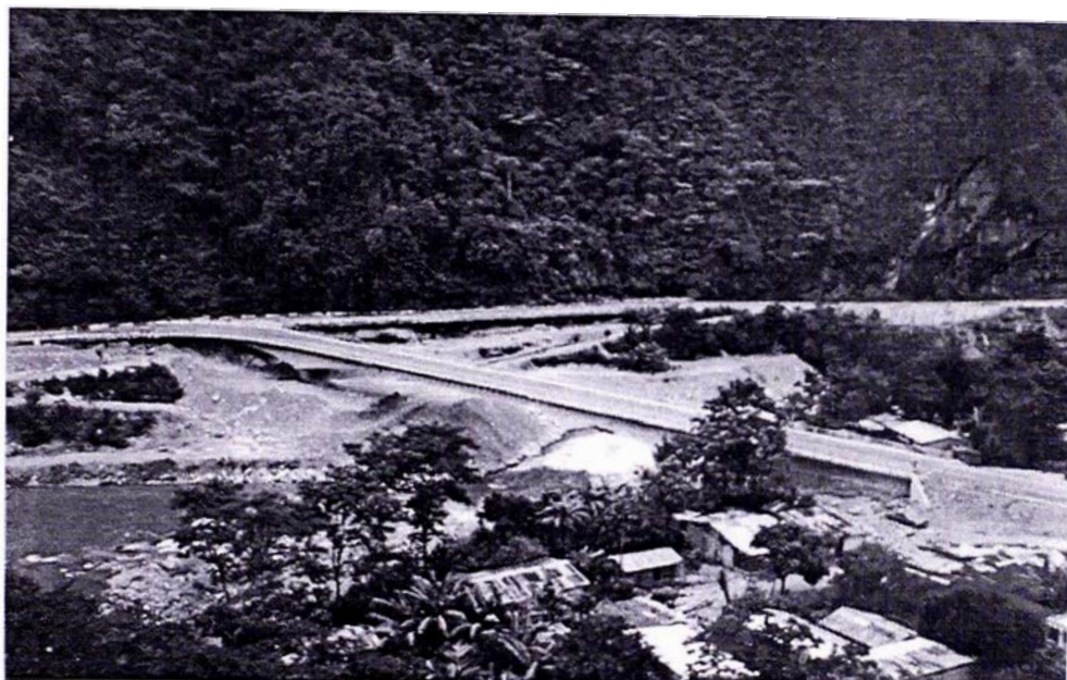
Fig. 1.3 Nuevo Puente Cayumba; Superestructura Postensada Gerber con Tramo Central Mixto; Dpto. de Huanuco
