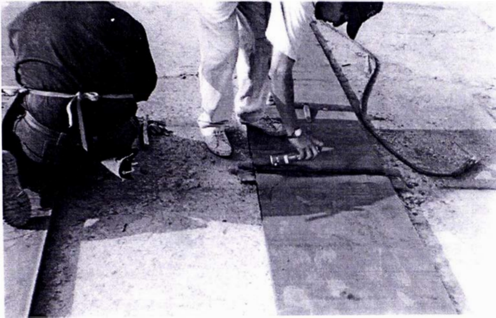
Fig. 4.9 Aplicación de Tinte Penetrante
