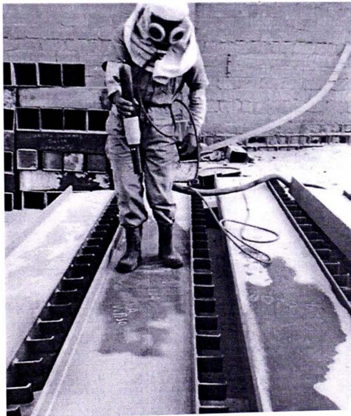
Fig. 4.16 Limpieza con Chorro de Arena
