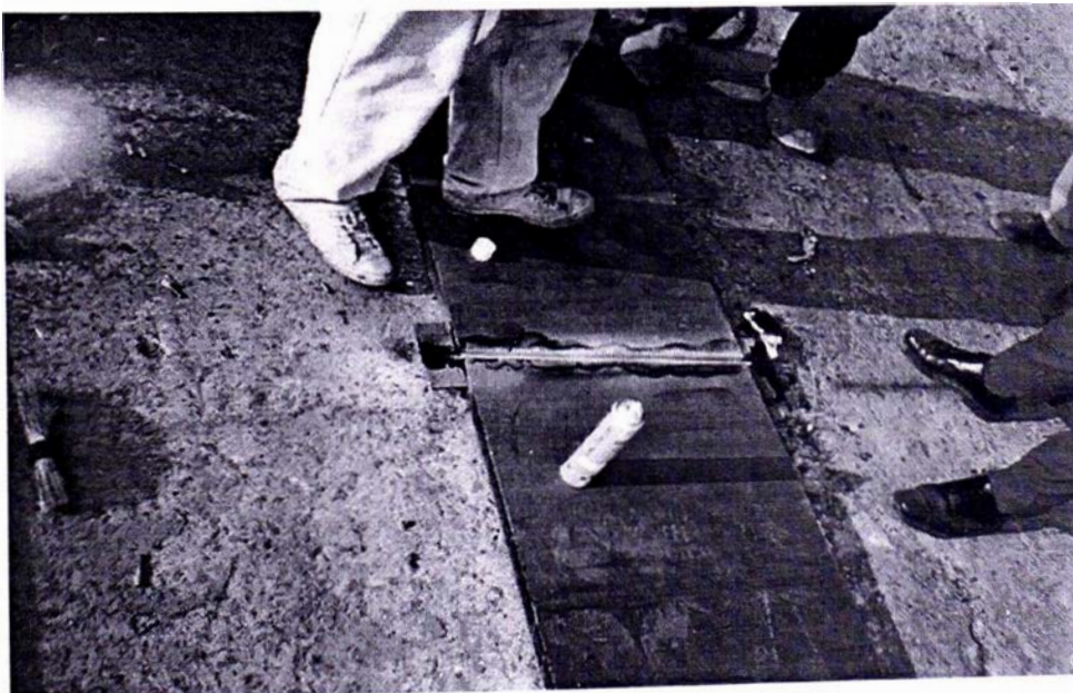
Fig. 4.10 El Revelador del Tinte Penetrante muestra Inexistencia de Porosidades
