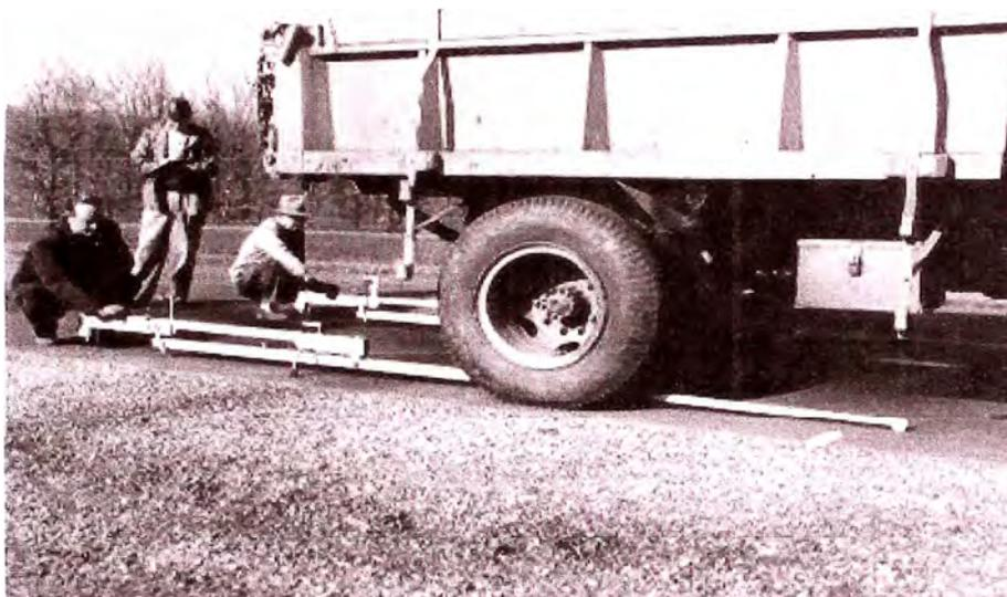
Figura N° 2.2 Uso de la Viga Benkelman en la AASHO Test road, 1962
