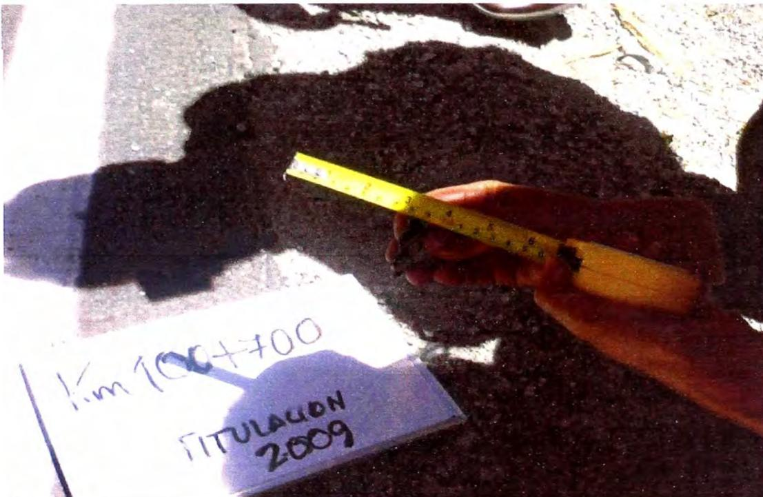
Fotografía Nº A7.2 Medición del ancho de capa en la progresiva 100+700
