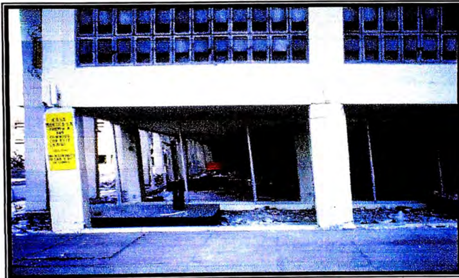
Figura N° 03: Ejemplo de falla típica por piso blando.
