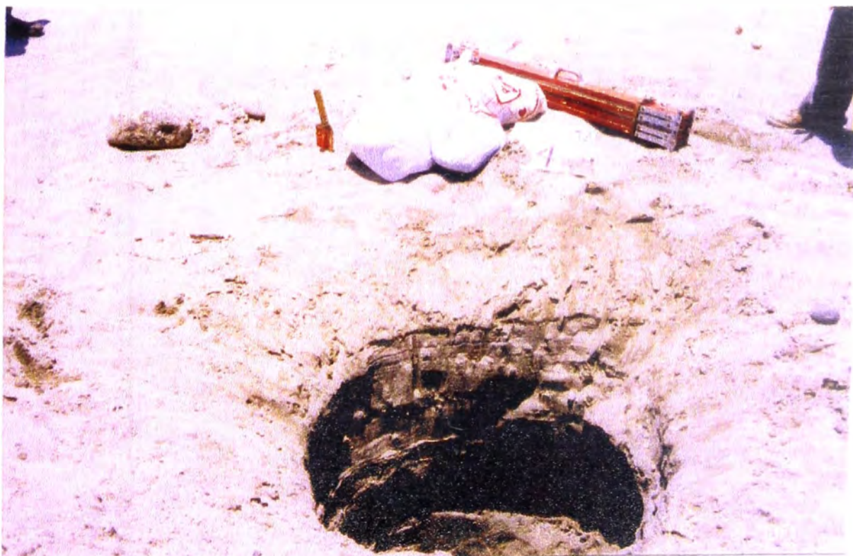
CALICATA NO. 4 : SE APRECIA EL TIPO DE SUELO ARENOSO Y MUESTRAS OBTENIDAS
