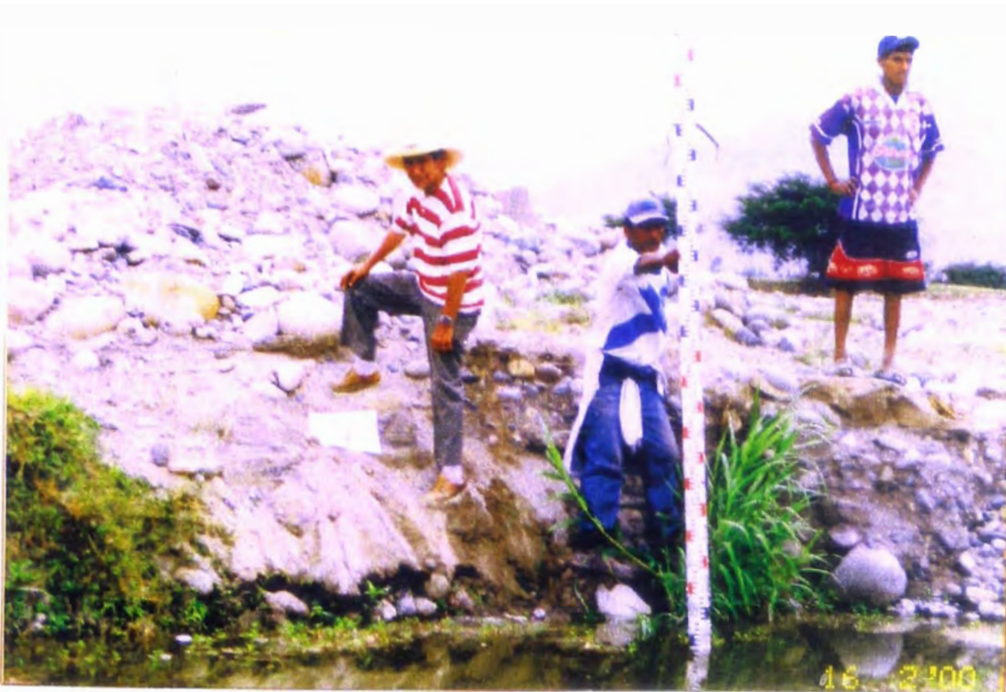
CALICATA NO. 1. SE APRECIA LAS MEDICION DEL NIVEL ESTATICO DEL AGUA, PRESENCIA DE CANTOS RODADOS Y ARENA.
