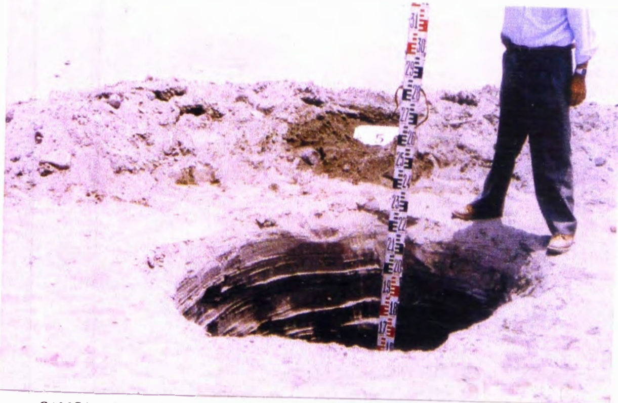
CALICATA NO. 5 : EN ESTA VISTA SE APRECIA LA MEDICION DE LA EXCAVACION Y EL TIPO DE SUELO ARENOSO
