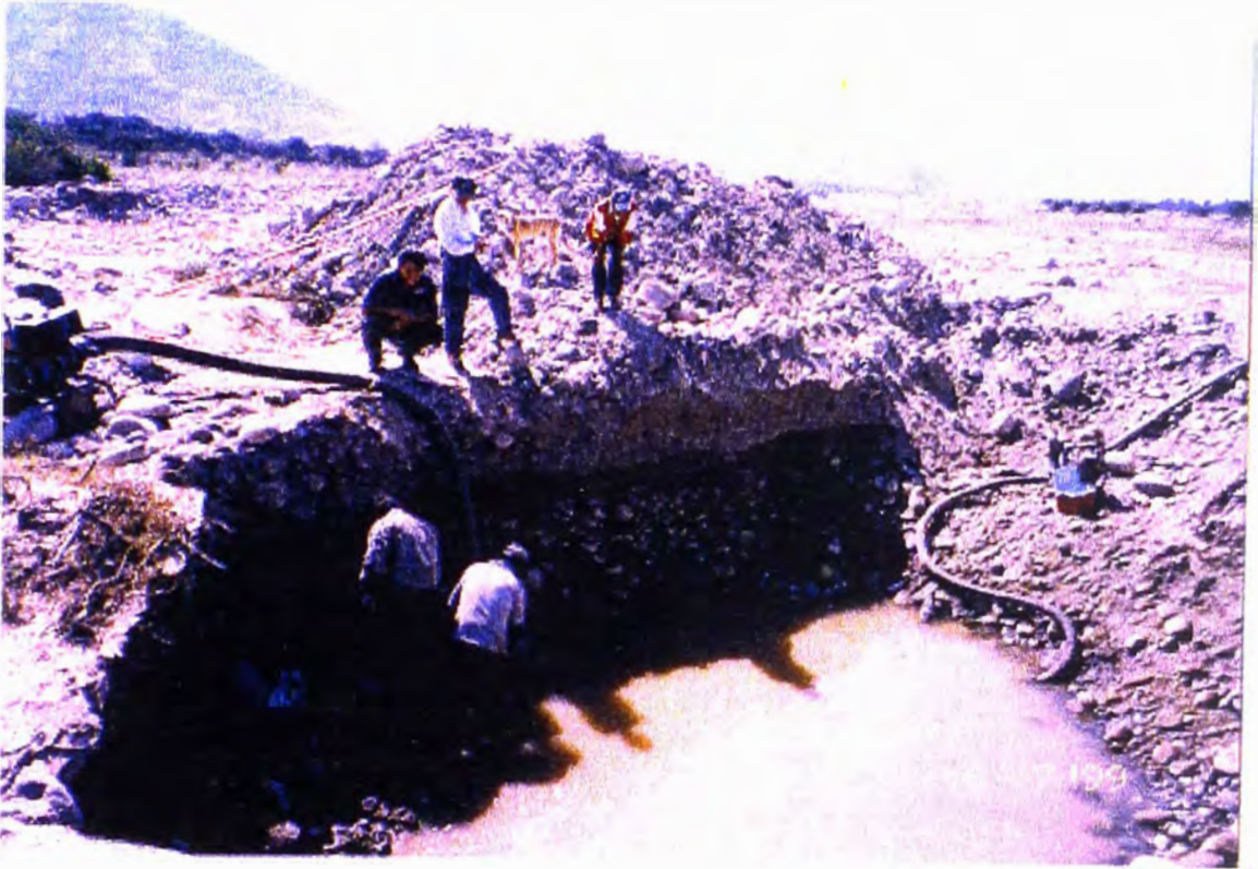
Bombeo de las aguas en la calicata para toma de muestra (06/07/99).
