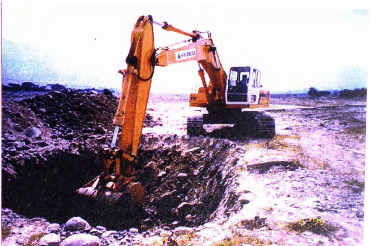
Excavación de Calicatas (02/06/99)
