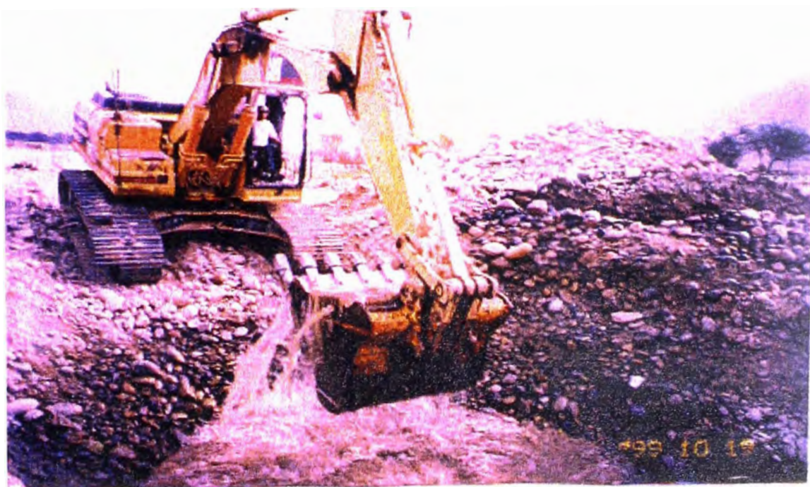
Profundización de Calicatas en la Zona "C" (19/10/99)
