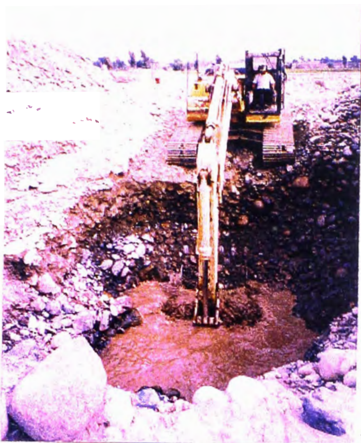
Profundización de calicatas en la Zona "C" (19/10/99)
