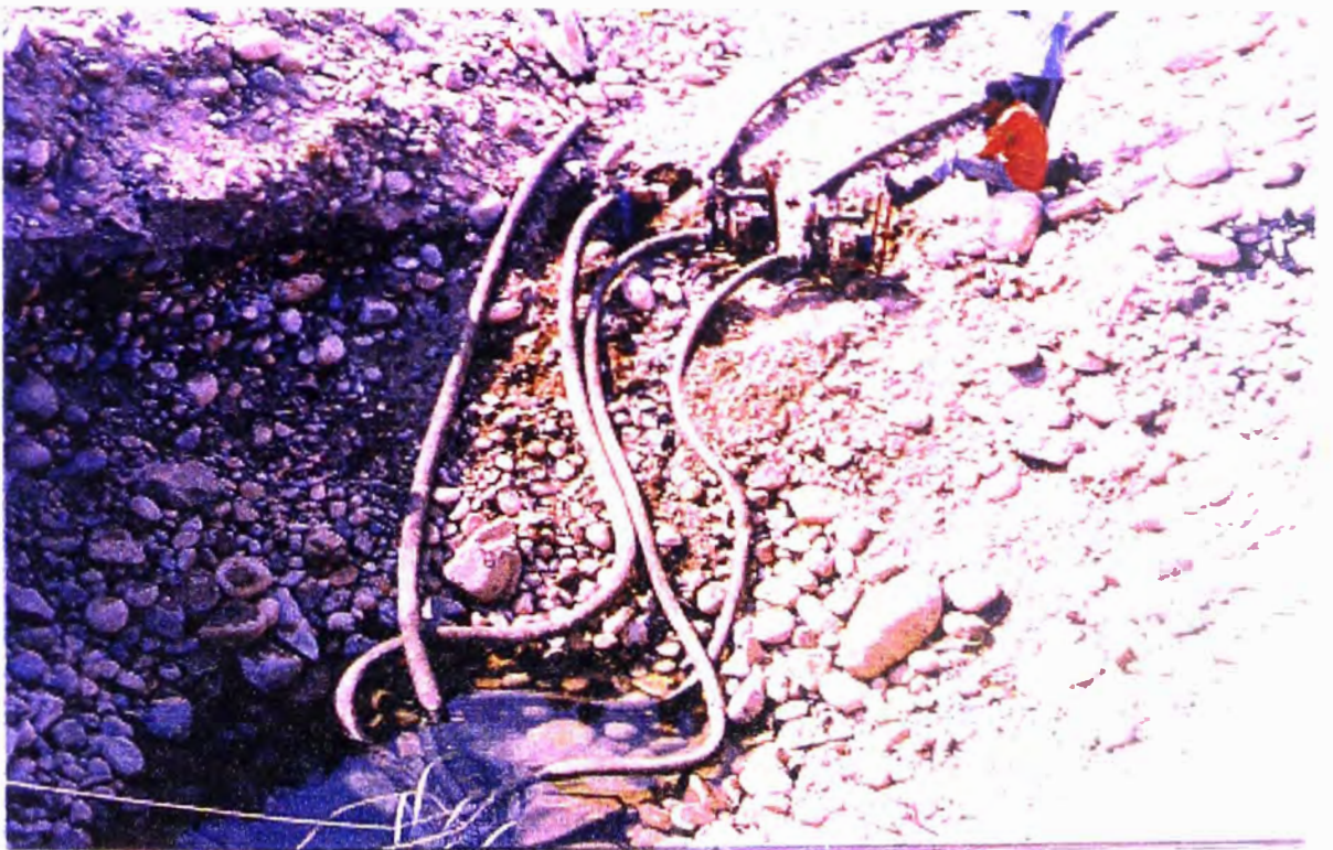
Nivel de agua estabilizado (en equilibrio), con dos equipos de bombeo que operaban alternadamente
