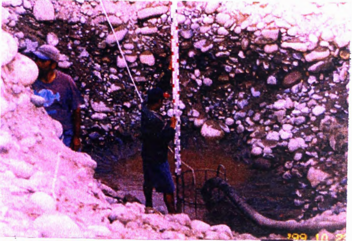
Control de nivel del agua durante el bombeo
