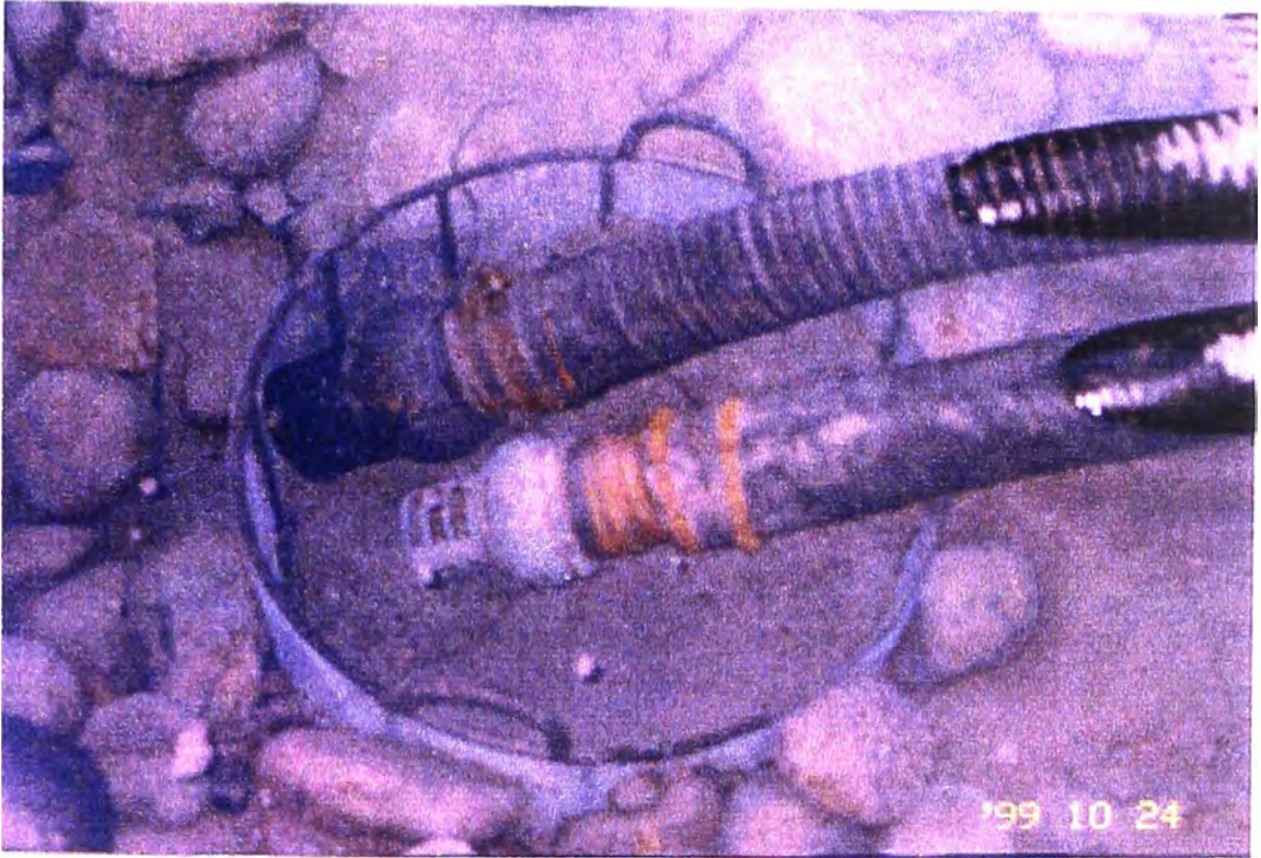
Nivel Estático Estabilizado del Agua. En la parte central durante la excavación se colocó una malla metálica circular de 1.20 m de altura
