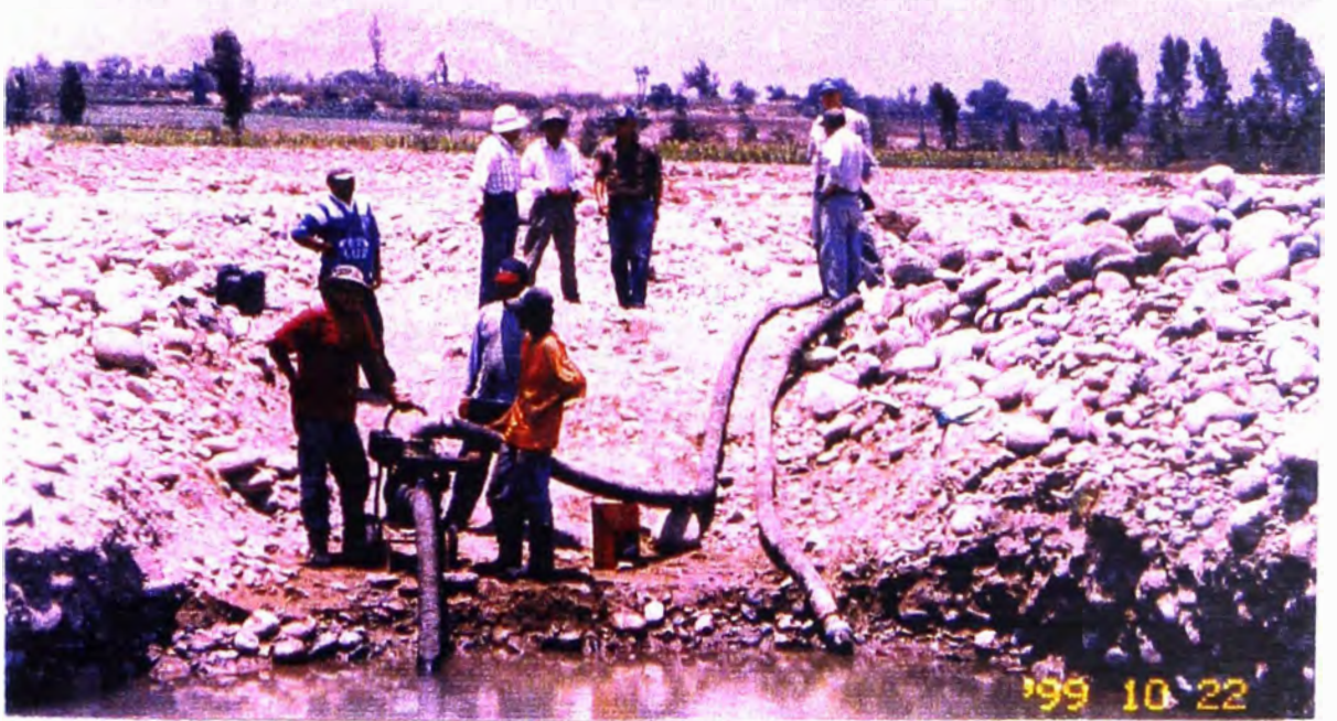
Bombeo continuo en calicata "C4" 22/10/99
