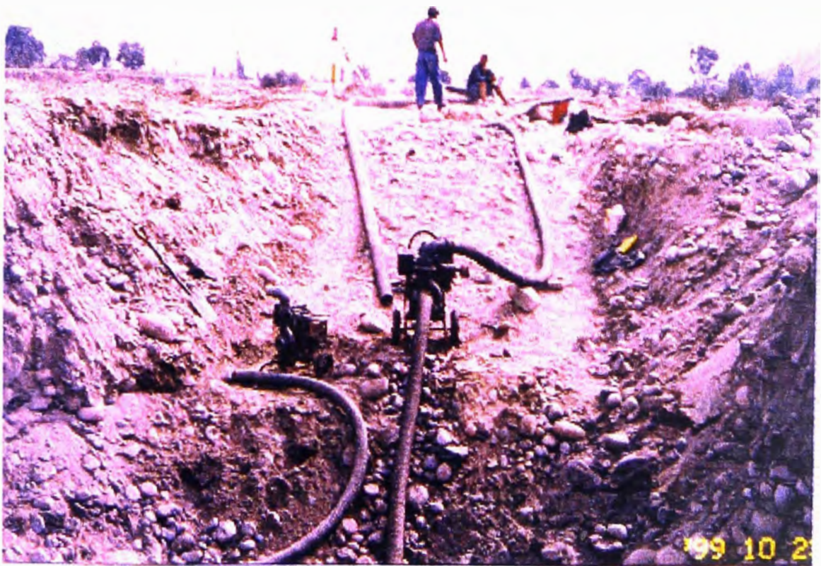
Instalación de Bombas para el Aforo de Calicatas
