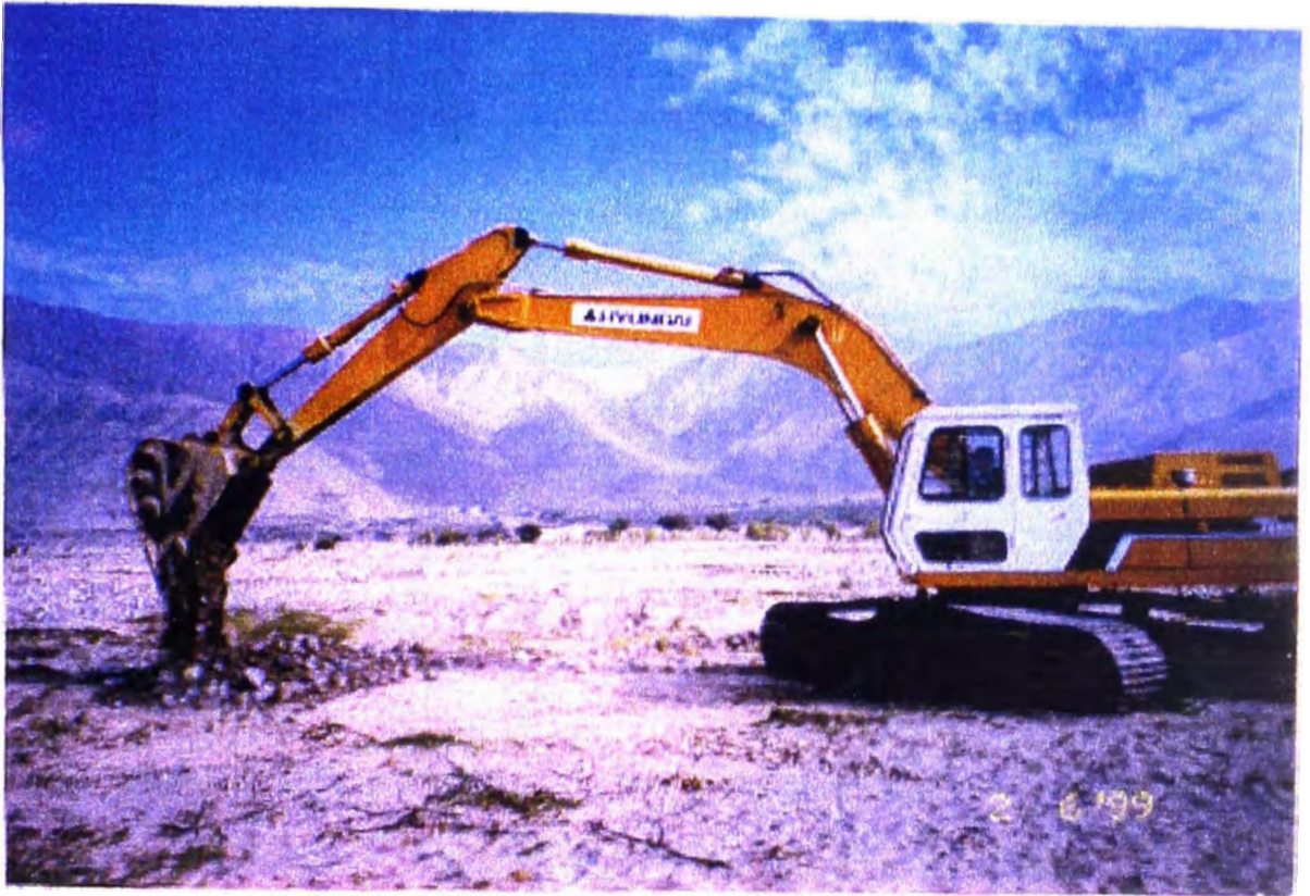
Excavación de Calicatas (02/06/99).
