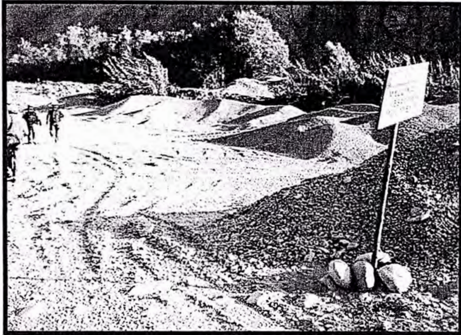
FOTO N°3: Se observa la cantera de piedra chancada y hormigón.
