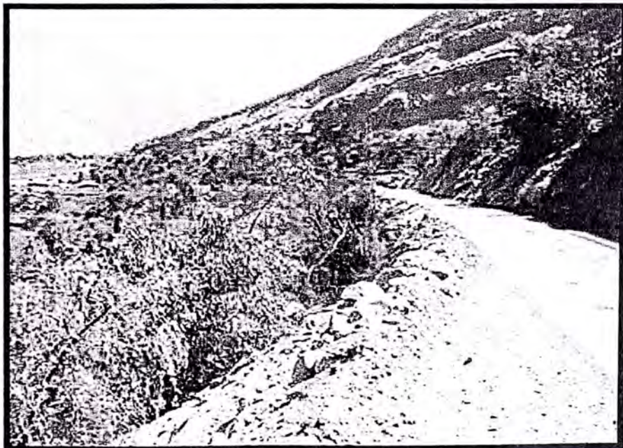
FOTO N°6: Otra vista de la carretera en su actual estado, en la margen izquierda se construirá el futuro muro de contención.
