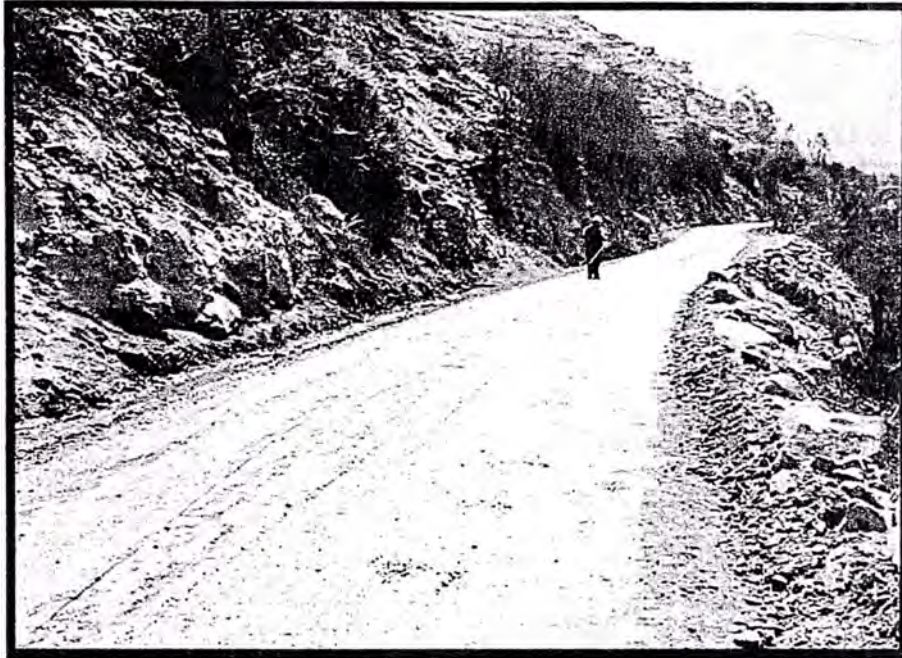
FOTO N°5: Se observa la carretera en su actual estado, en la margen derecha se construirá el futuro muro de contención.
