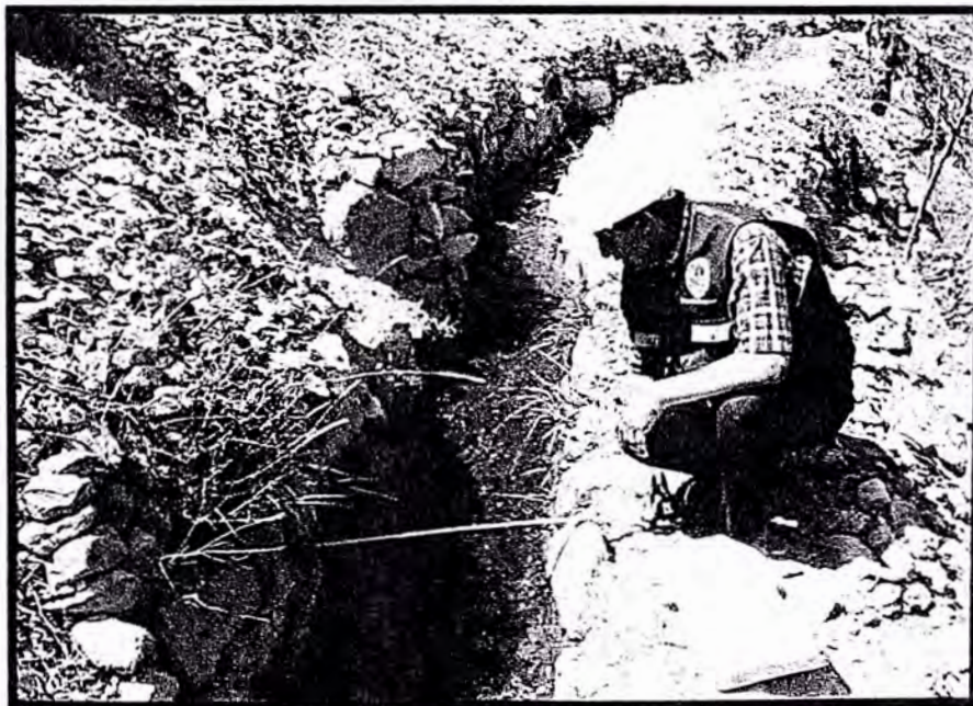
FOTO N°4: Se observa la fuente de agua que pasa por encima del tramo en estudio.
