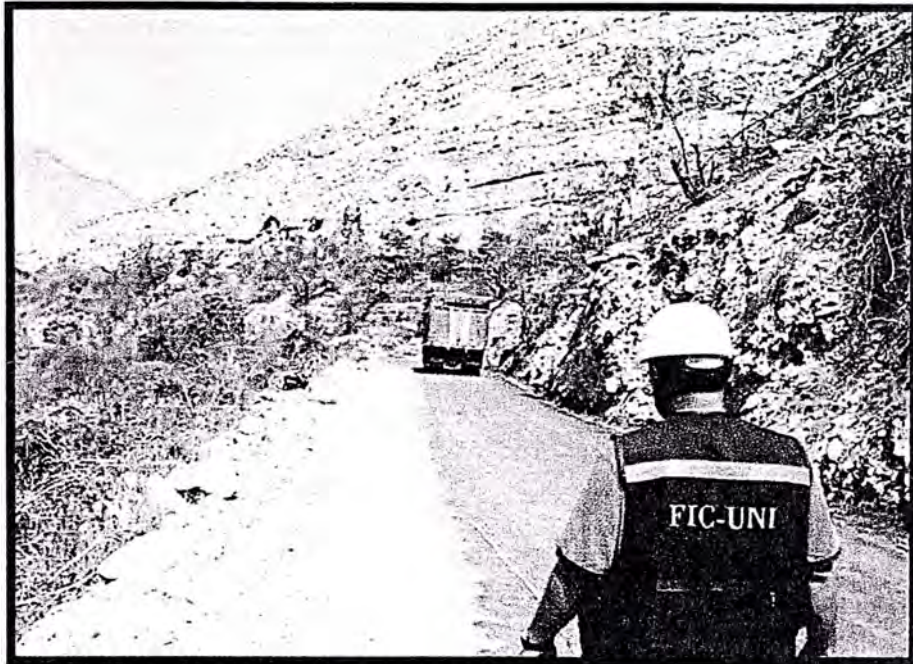
FOTO N°7: Otra vista de la carretera en su actual estado, en la margen izquierda se construirá el futuro muro de contención.
