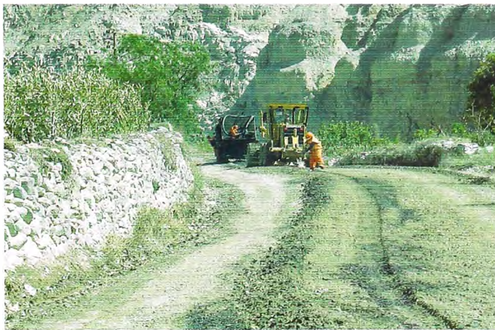
Figura N° 6.02 Estabilización del tramo con emulsión Fuente : Consorcio Gestión de carreteras
