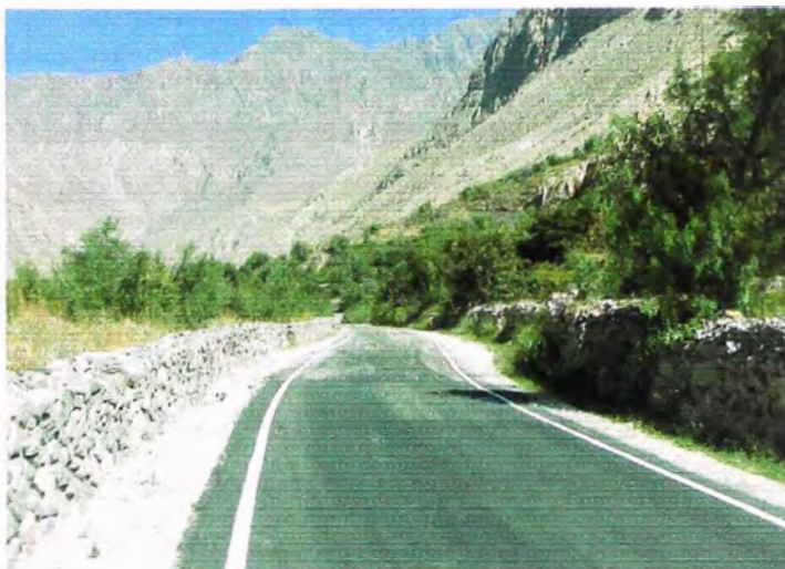
Figura N° 4.01 Acabado del tramo a nivel monocapa Fuente : Elaboración Propia
