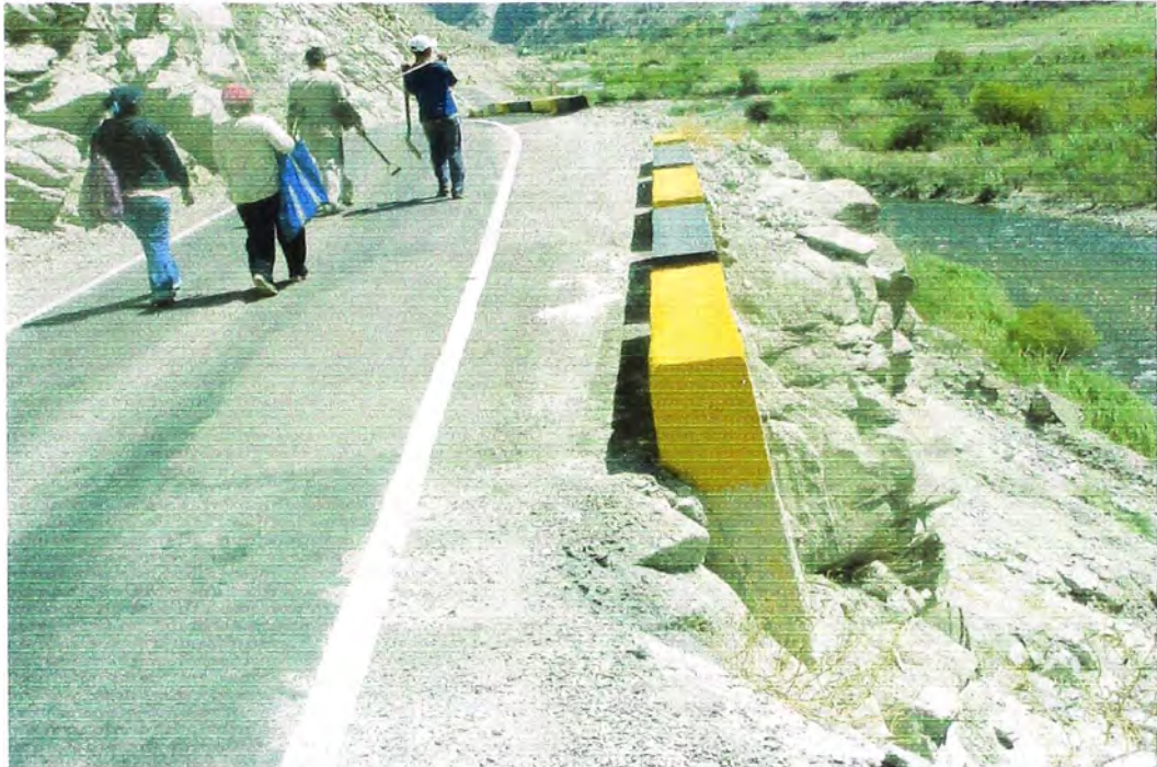
Figura N° 6.03 Visita del tramo, Km. 89+00-Km. 94+000. Personal a realizar la calicata Fuente : Elaboración Propia
