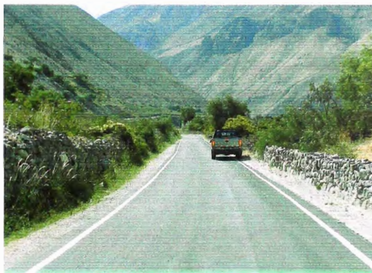
Figura N° 4.02 Acabado del tramo a nivel monocapa Fuente : Consorcio Gestión de Carreteras
