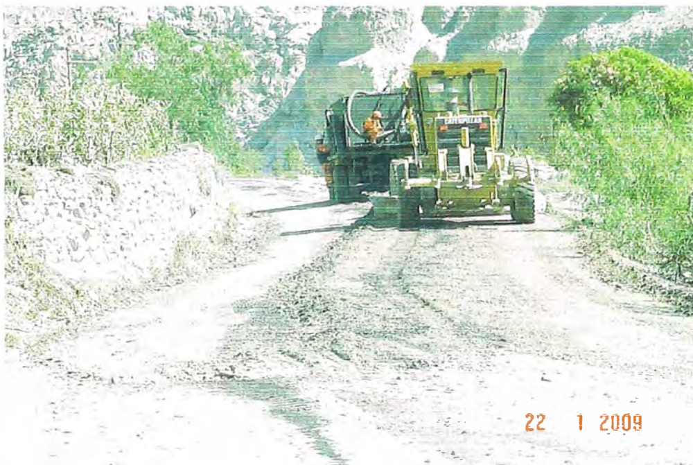
Figura N° 6.01 Estabilización del tramo con emulsión Fuente : Consorcio Gestión de carreteras
