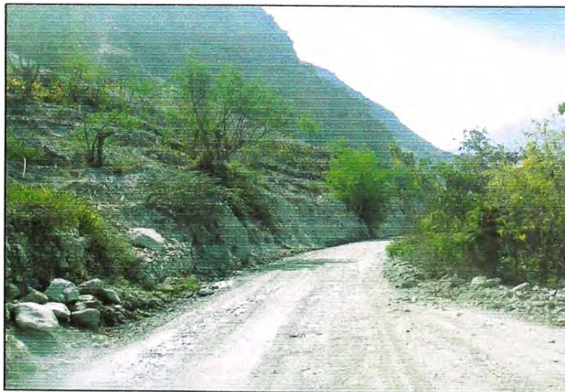
Figura N° 1.02 – Condiciones iniciales de la vía
