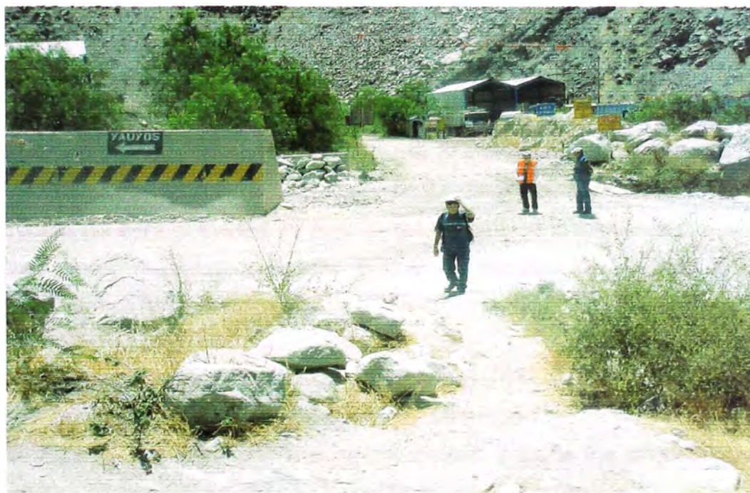
Figura N° 6.06 Visita del tramo, Km. 94+000 Fuente : Elaboración Propia
