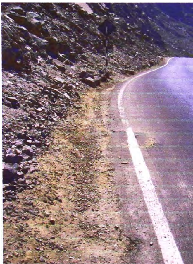
Foto Nº 1: Km 68+950 al Km 69+000: Problemas de Drenaje – Cunetas de tierra en mal estado
