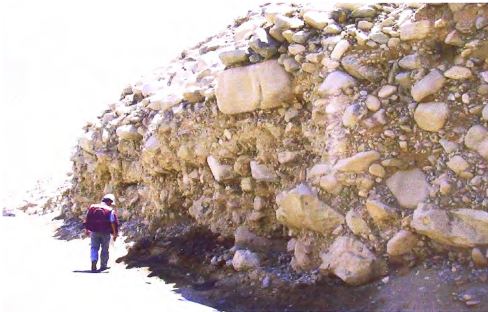
Foto N° 10: Km 68+200: Filtraciones en lado adyacente a la carretera, lo cual posiblemente proviene de las tierras de cultivo adyacentes a la vía, por consiguiente sería necesaria la colocación de una tajea o alcantarilla de tubería de PVC de D=6".
