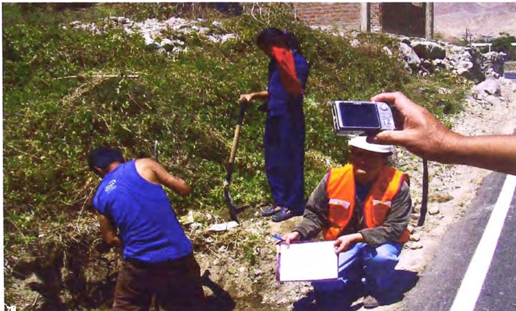
Foto N° 16: Km 67+275, Calicata realizada para conocer las características propias del suelo de la vía.
