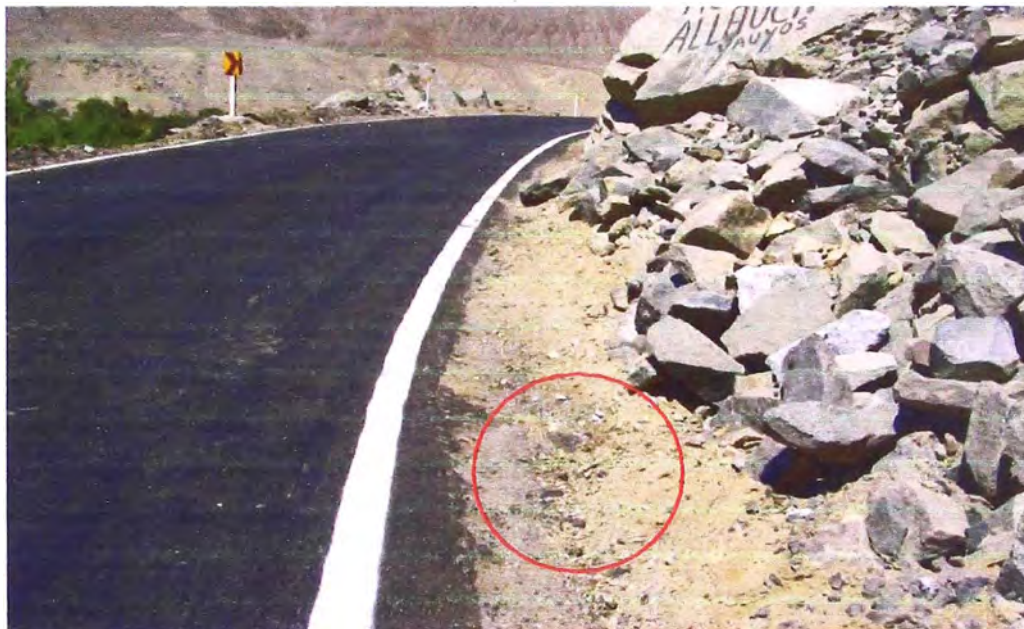
Foto Nº 1: Km 68+950 al Km 69+000: Problemas de Drenaje – Cunetas de tierra en mal estado
