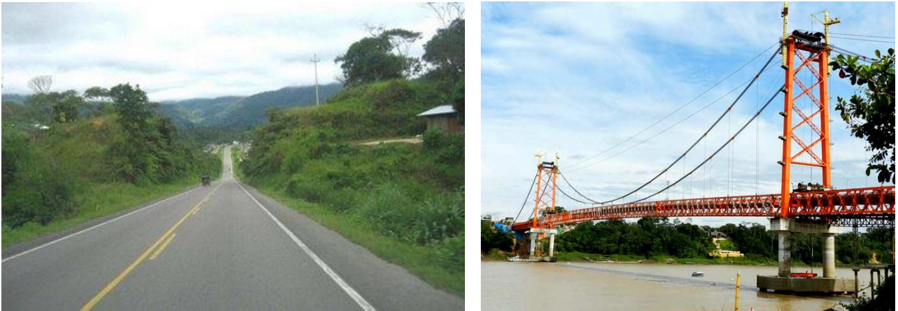
Figura 3. Obras de infraestructura en la región amazónica
