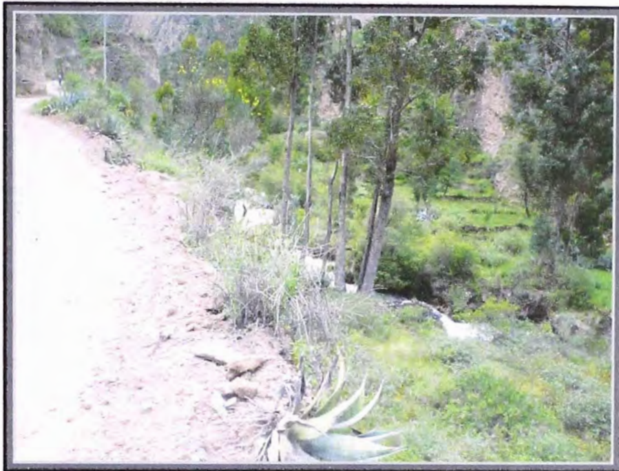
Vista del extremo sur de la carretera en el cual se observa la gran altura de la vía respecto al río Alis.
