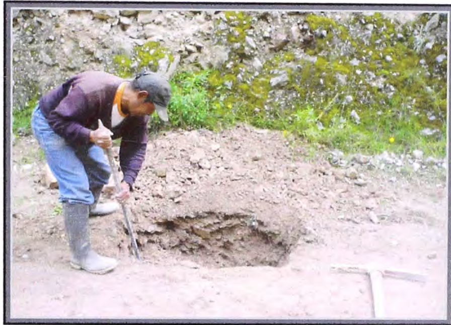
Excavación de calicata en Km. 162+730.
