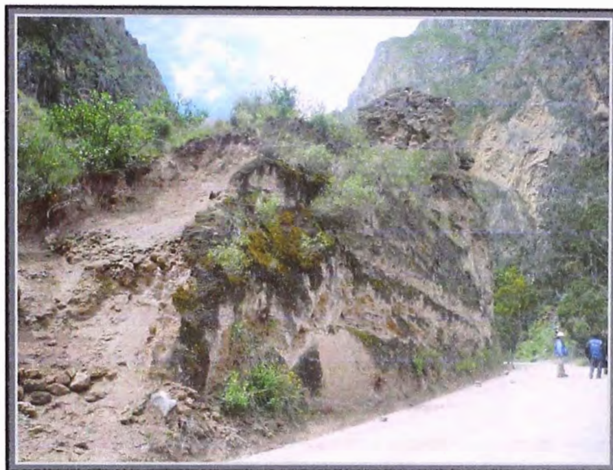
Talud empinado formado de tierra.
