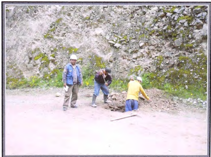
Calicata ubicada a un lado de la carretera próxima al talud.
