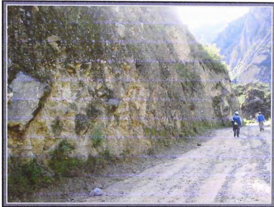
Talud formado de un depósito coluvial.
