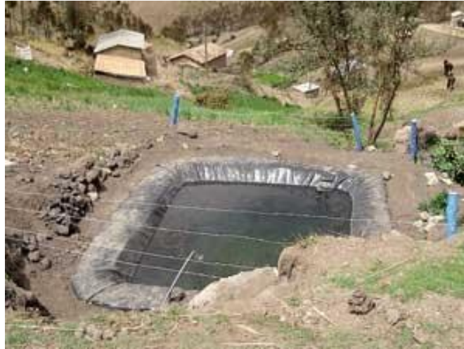
Figura N° 4. Reservorio con geomembrana
