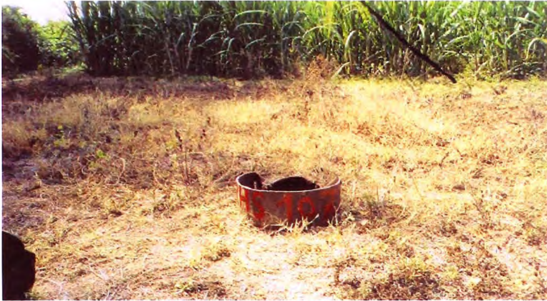
FOTO N° 01 Pozo tubular 07_187 No utilizable ubicado en el sector santa Rosa, Distrito de Lagunas (INRENA, 2006)
